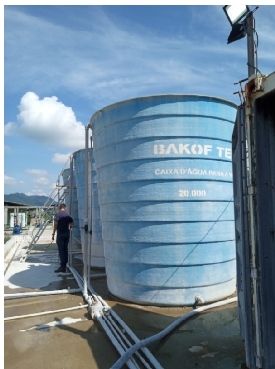
Figura 16: Tanques da estação de tratamento
