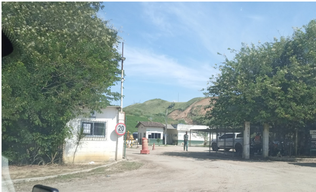
Figura 2: Vista da entrada do CTDR Paracambi.
