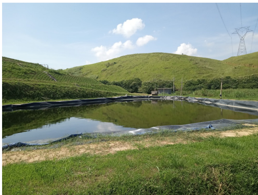
Figura 11 : Nova lagoa de recebimento de chorume já em funcionamento
