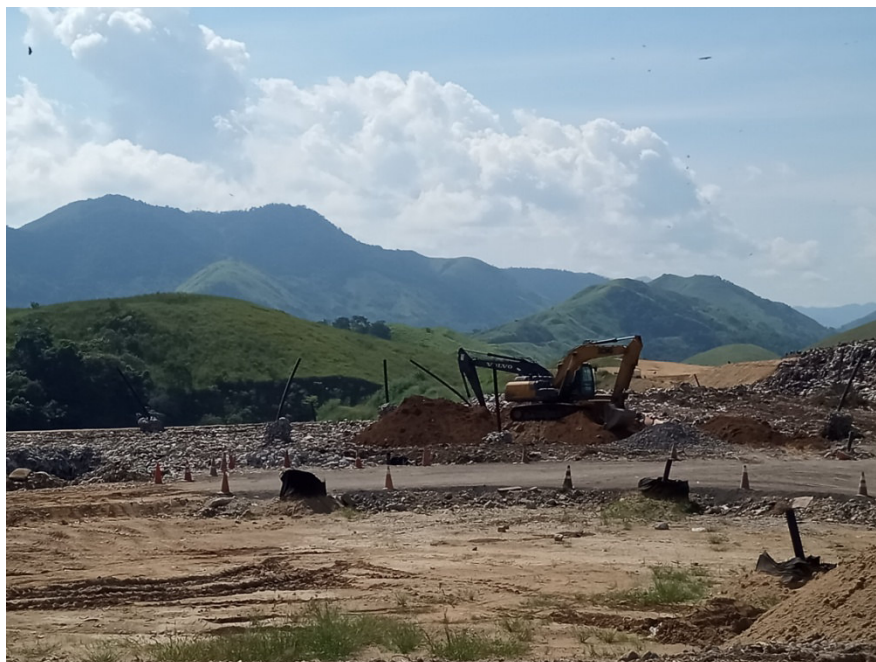
Figura 5: Frente de trabalho – Cobertura dos Resíduos
