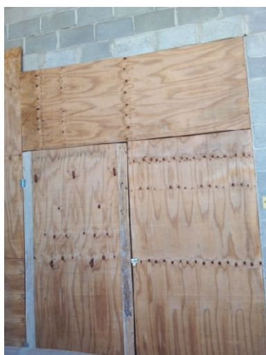
Figura 23: Acesso ao galpão de RSS .
