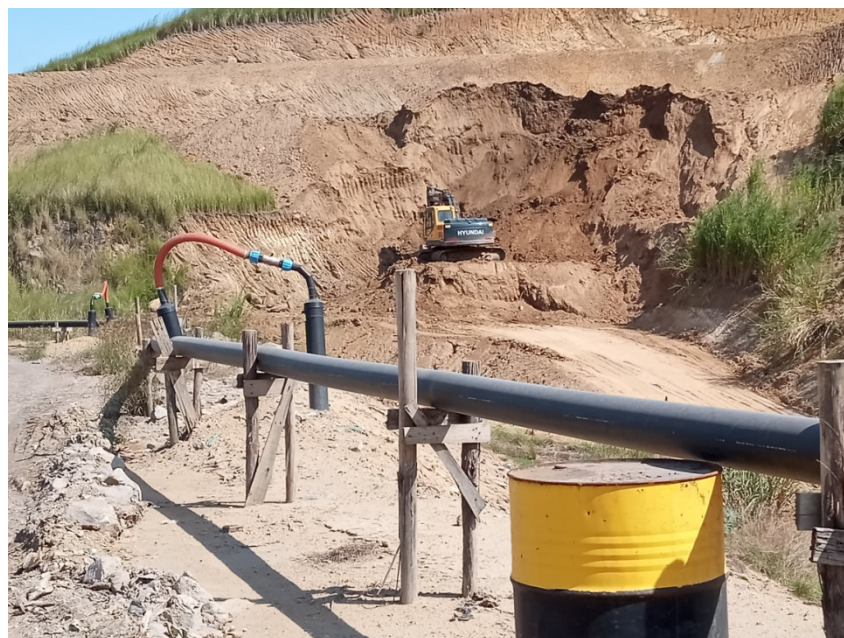
Figura 6: Dutos coletores de gás e ao fundo preparação de nova célula
