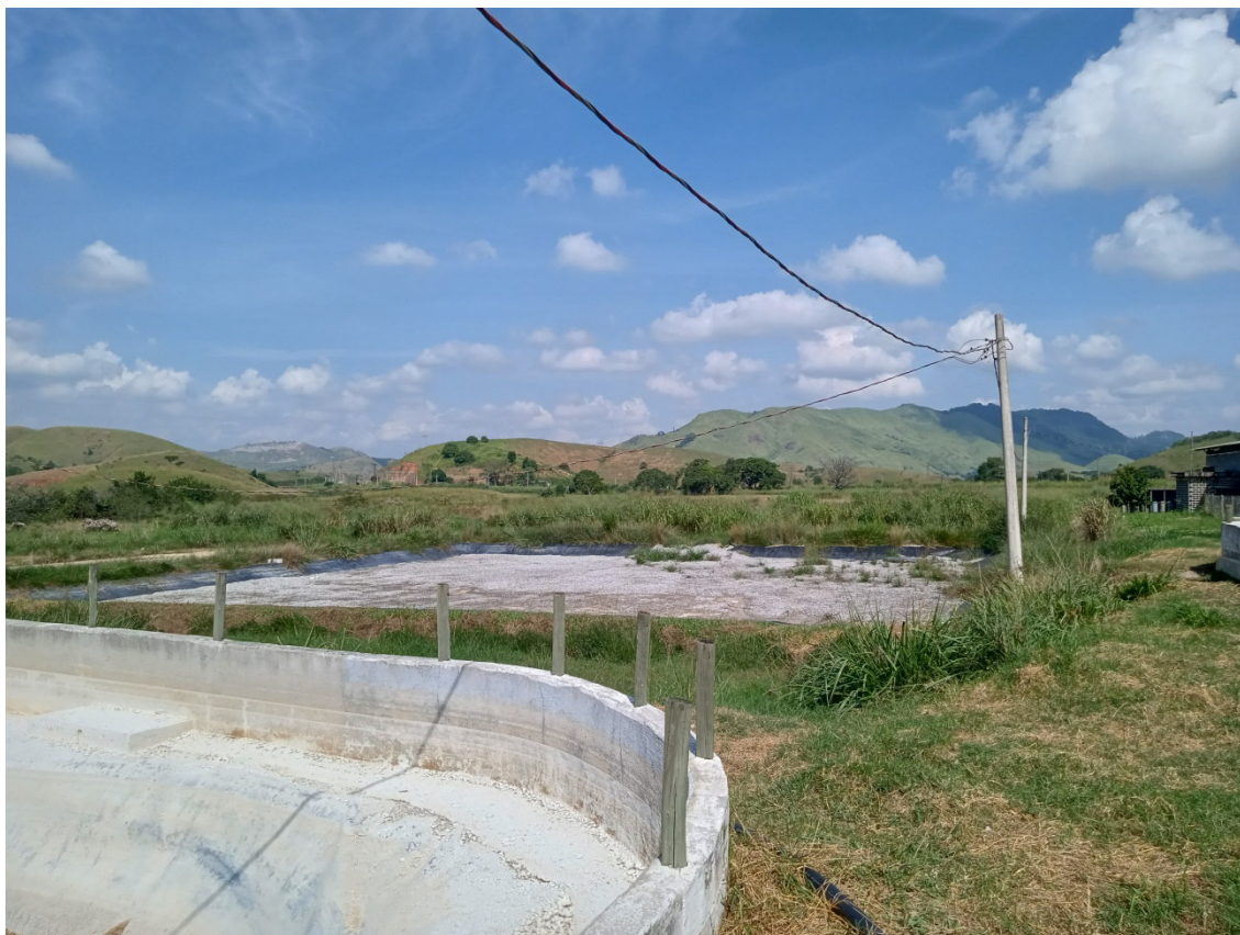
Figura 13 : Construção de uma nova lagoa para recebimento de chorume
