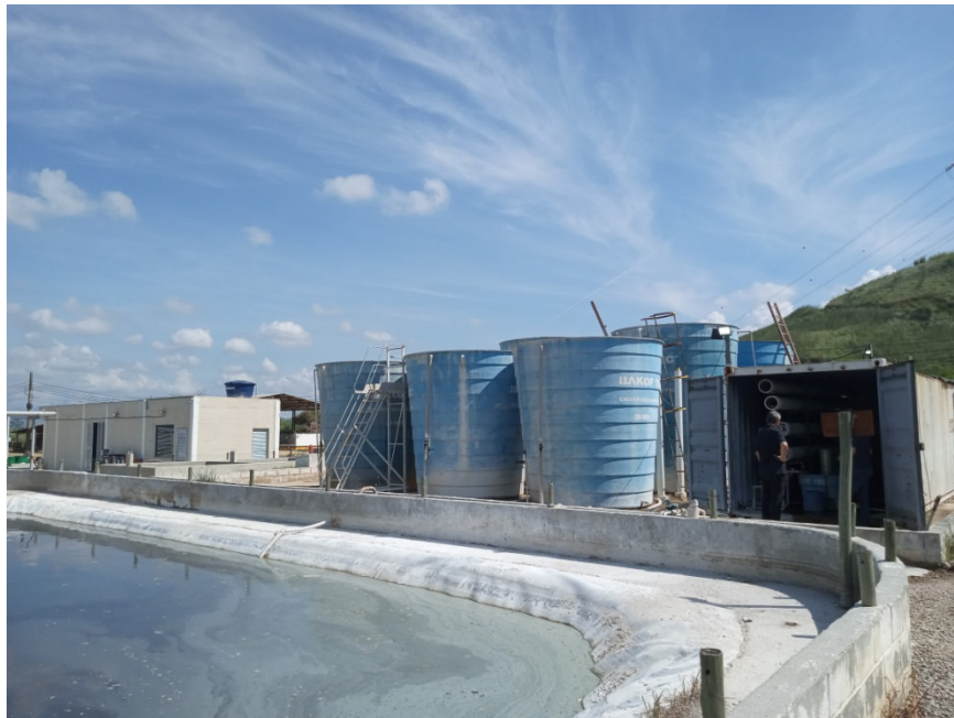
Figura 17: Tanques da estação de tratamento
