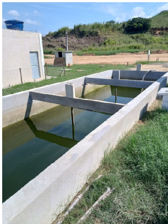
Figura 18: Obra de assentamento para os novos tanques em fase de testes para verificação de possíveis vazamentos
