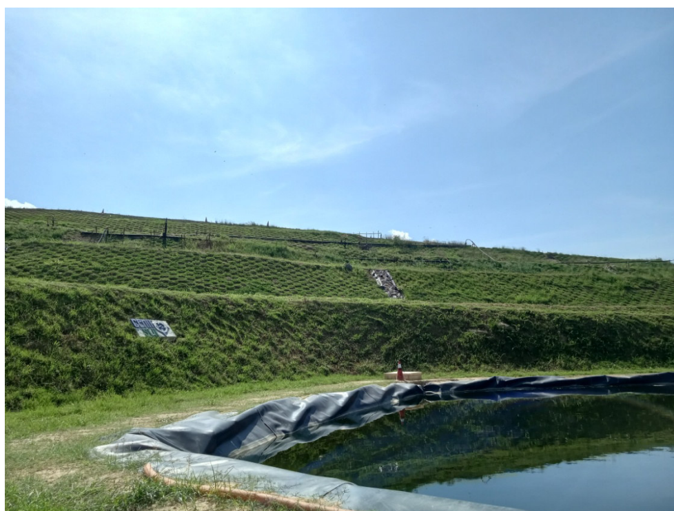
Figura 12 : Nova lagoa de recebimento de chorume já em funcionamento. Talude com vegetação recomposta
