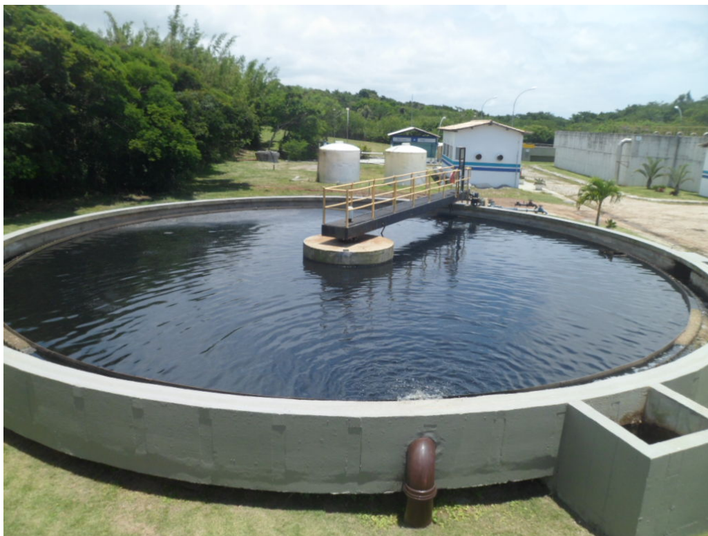
Foto 10 – Decantador Primário
