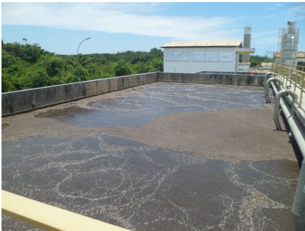
Foto 12 – Tanque de Aeração
