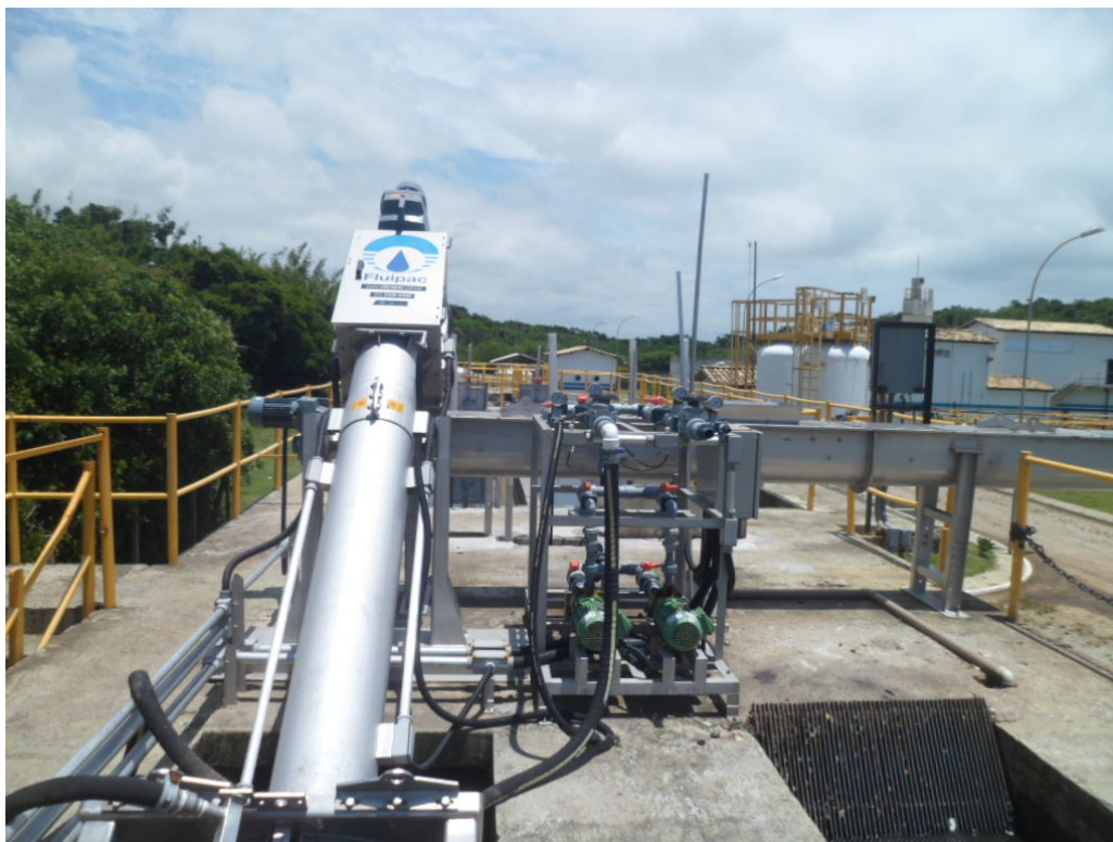
Foto 06 – Peneira Rotativa, Lançando Resíduos Sólidos para Caçamba
