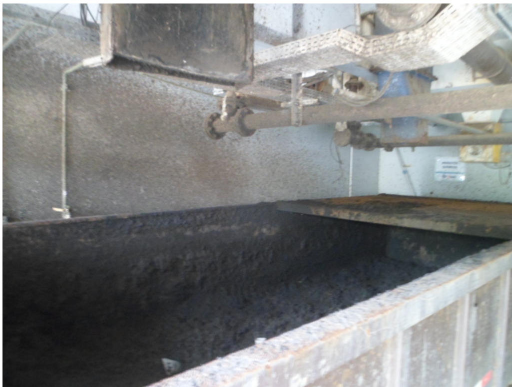
Foto 20 – Lançamento de Lodo na Caçamba
