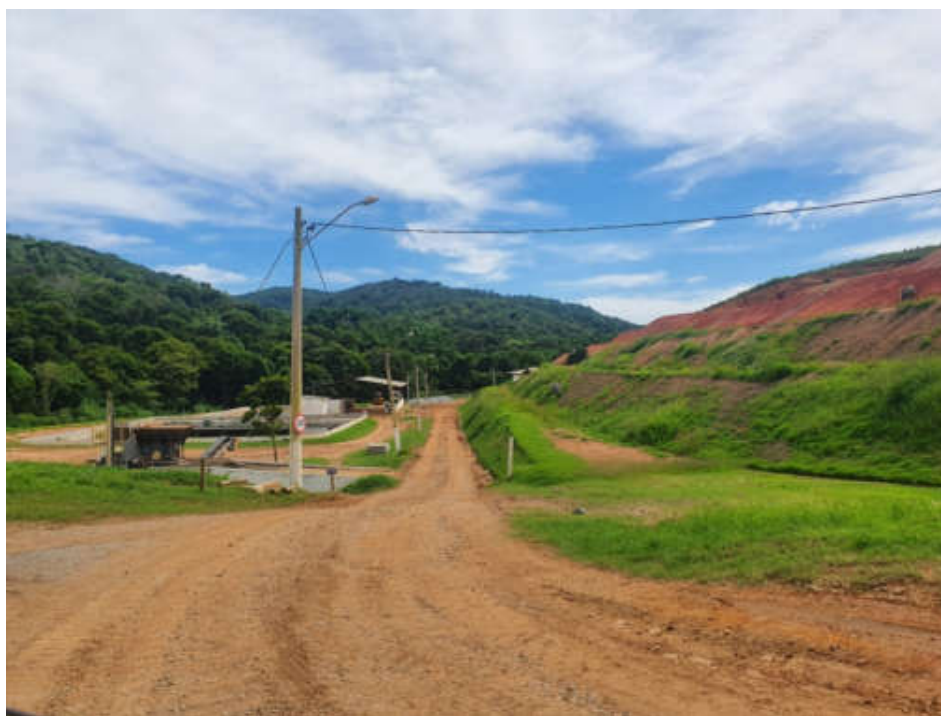
Figura 09: Vista do britador de resíduo de construção civil à esquerda e lateral da célula b, à direita.
