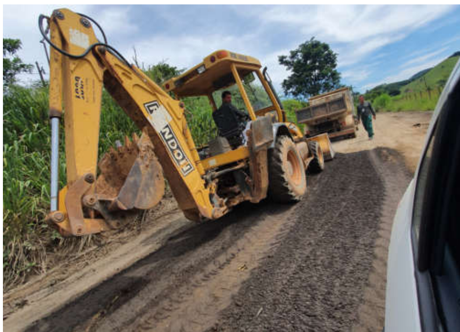
Figura 4: Trabalho de melhoria na via de acesso ao aterro.
