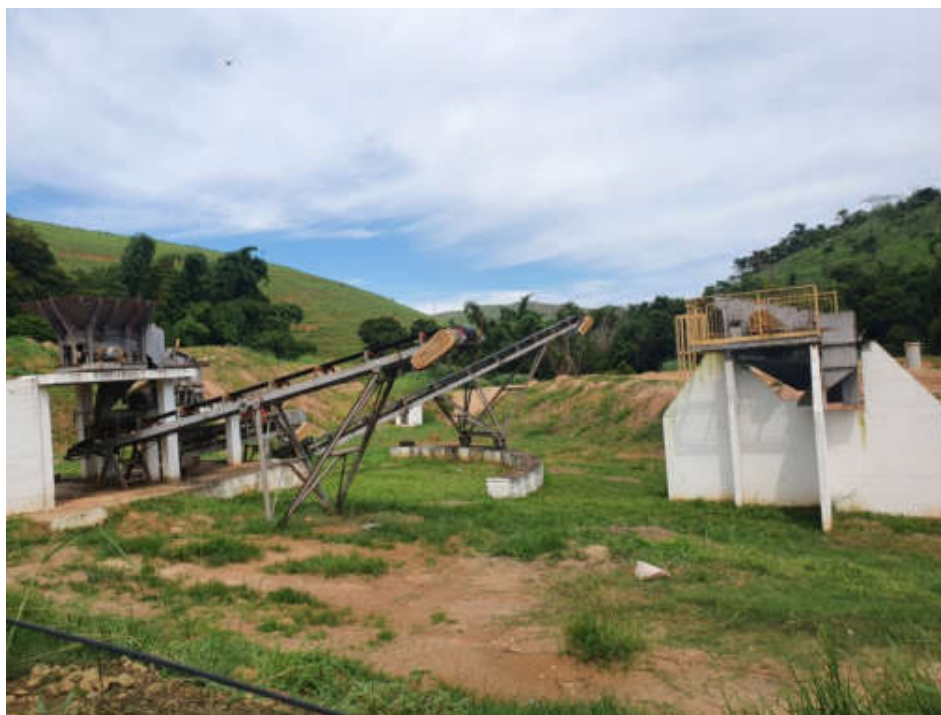
Figura 8: Britador de resíduos da construção civil inoperante.
