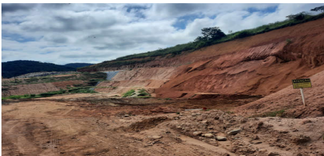
Figura 6: Jazida utilizada para recobrimento de resíduos e pavimentação das vias e, ao fundo, frente de trabalho.
