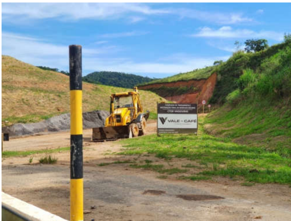
Figura 4: Entrada do aterro sanitário visto da balança de pesagem.
