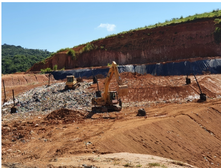
Figura 6: Vista da frente de trabalho com o trator de esteira e escavadeira em operação.
