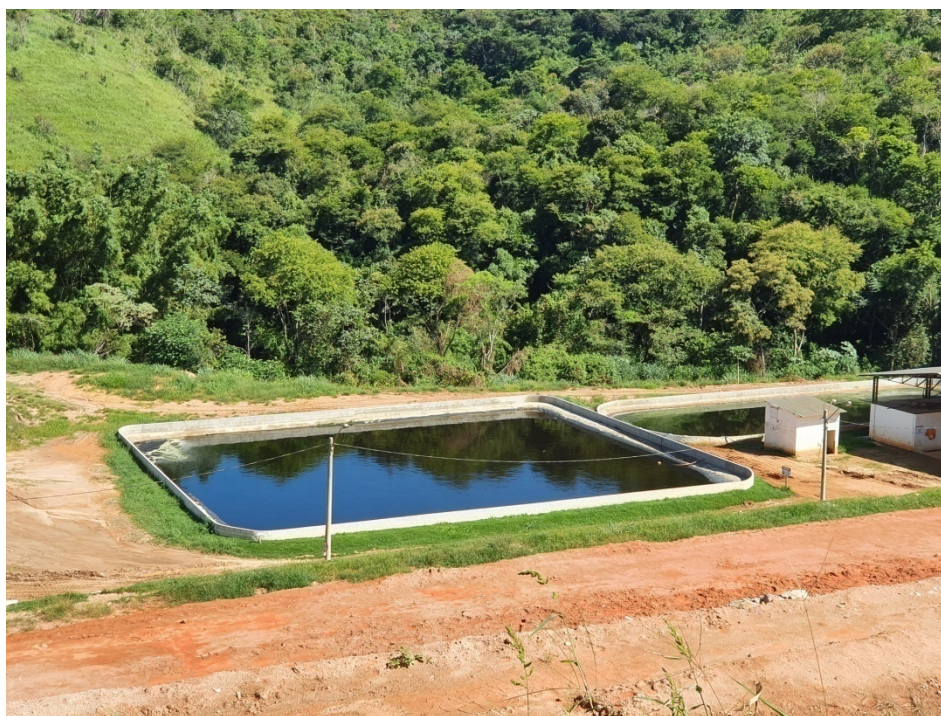
Figura 9: Vista das lagoas de armazenamento de chorume.
