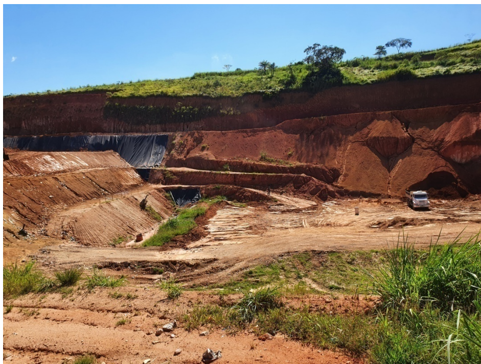
Figura 7: Vista dos taludes à esquerda e, à direita, jazida de onde é retirado o solo para fazer o recobrimento dos resíduos.
