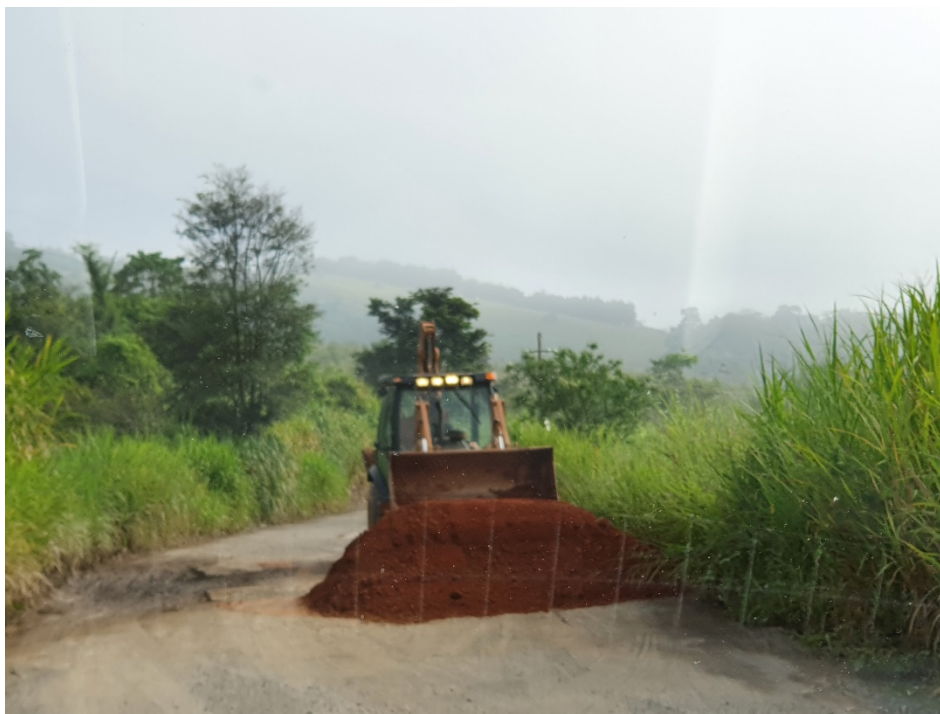
Figura 3: Parte da estrada onde está sendo realizada melhoria da pavimentação.
