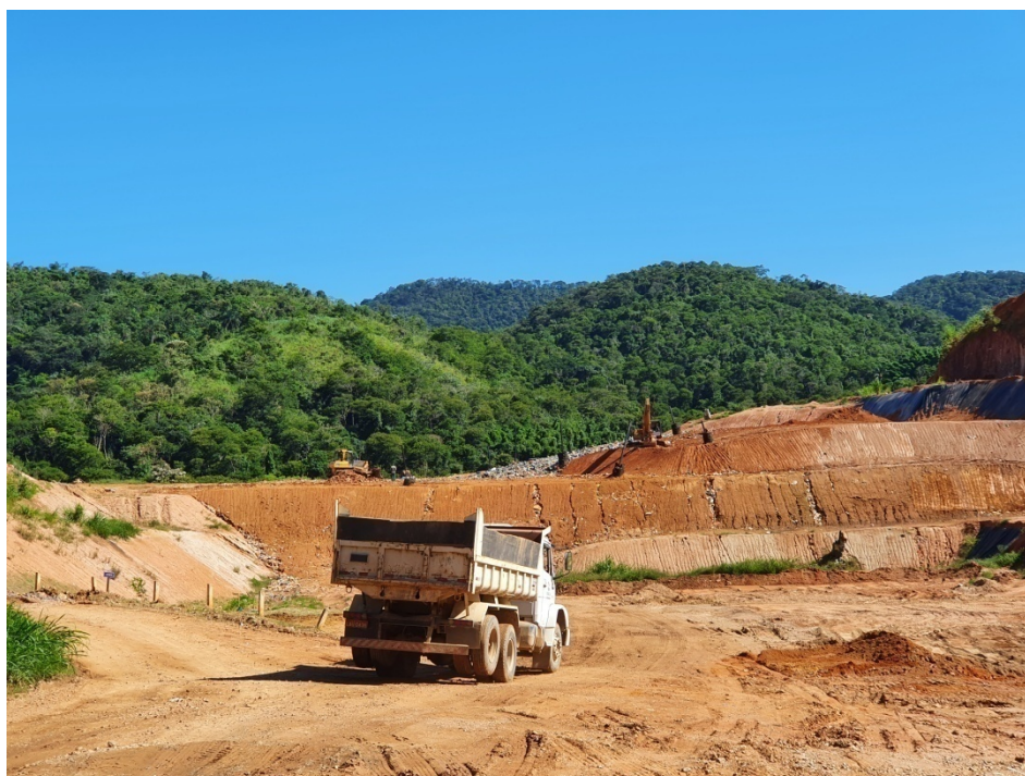
Figura 4: Vista da frente de trabalho.
