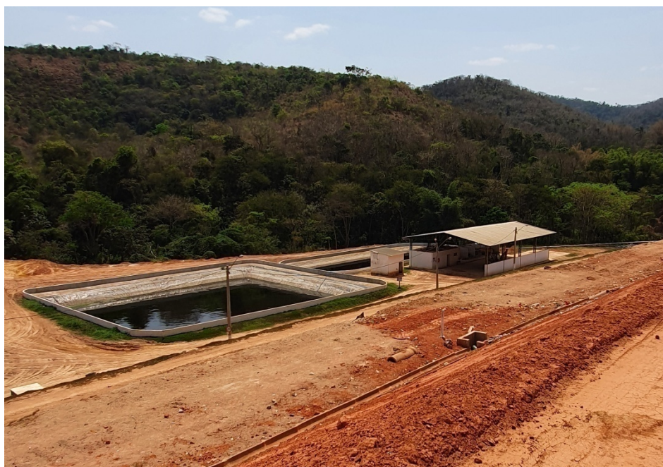
Figura 13: Vista das lagoas de acumulação.
