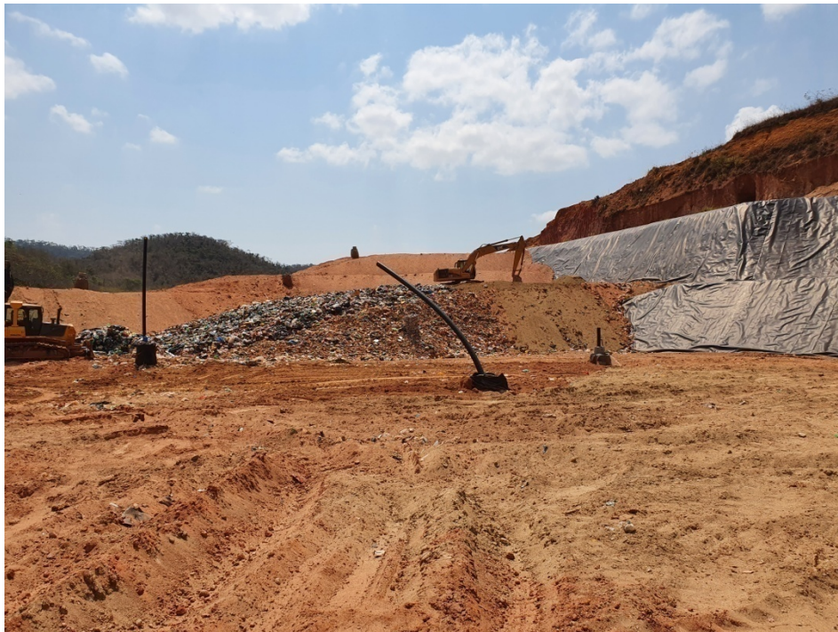
Figura 3: Vista da frente de trabalho, célula b, etapa 2. À direita, pode-se observar a manta de PEAD, com função impermeabilizante.
