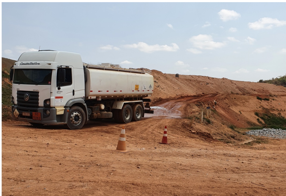
Figura 6: Caminhão pipa fazendo a umectação das vias.
