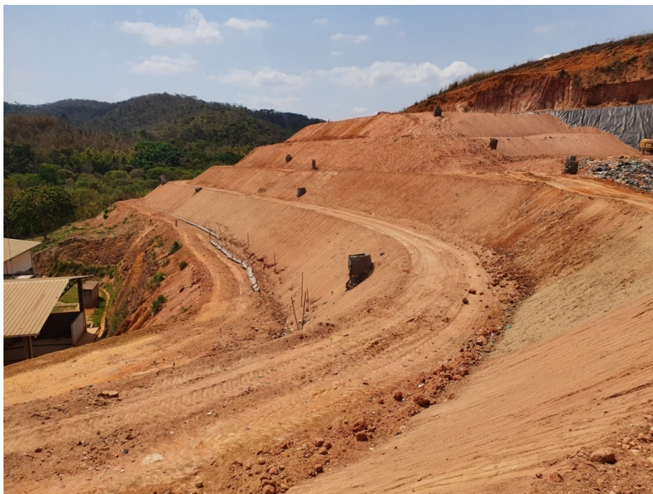
Figura 8: Vista dos taludes já operados da célula b, porém, sem cobertura vegetal.
