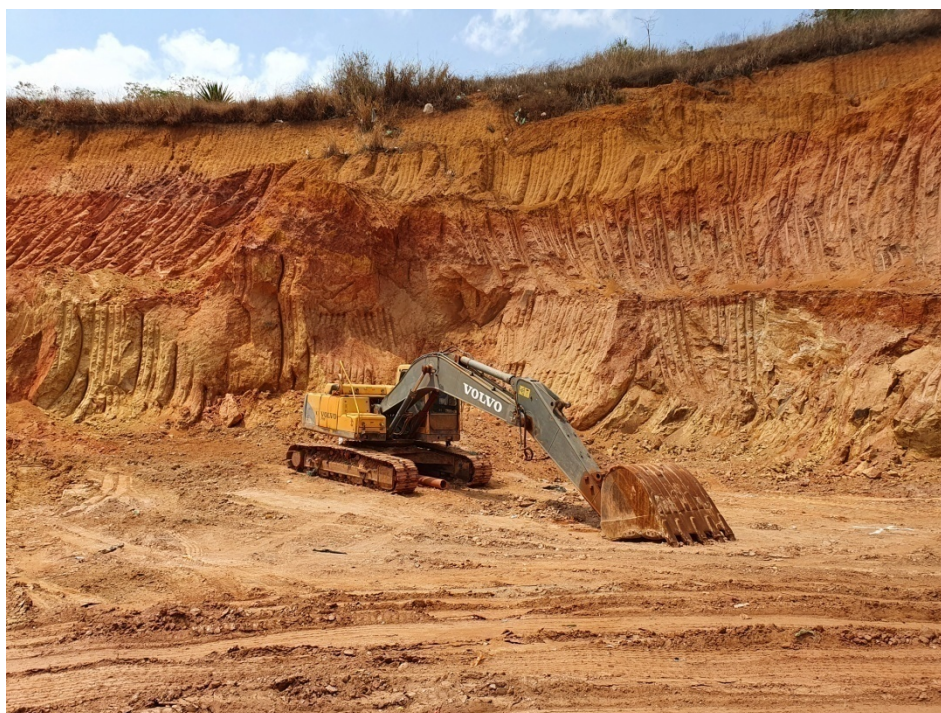
Figura 7: Escavadeira em operação para retirada de solo da jazida.
