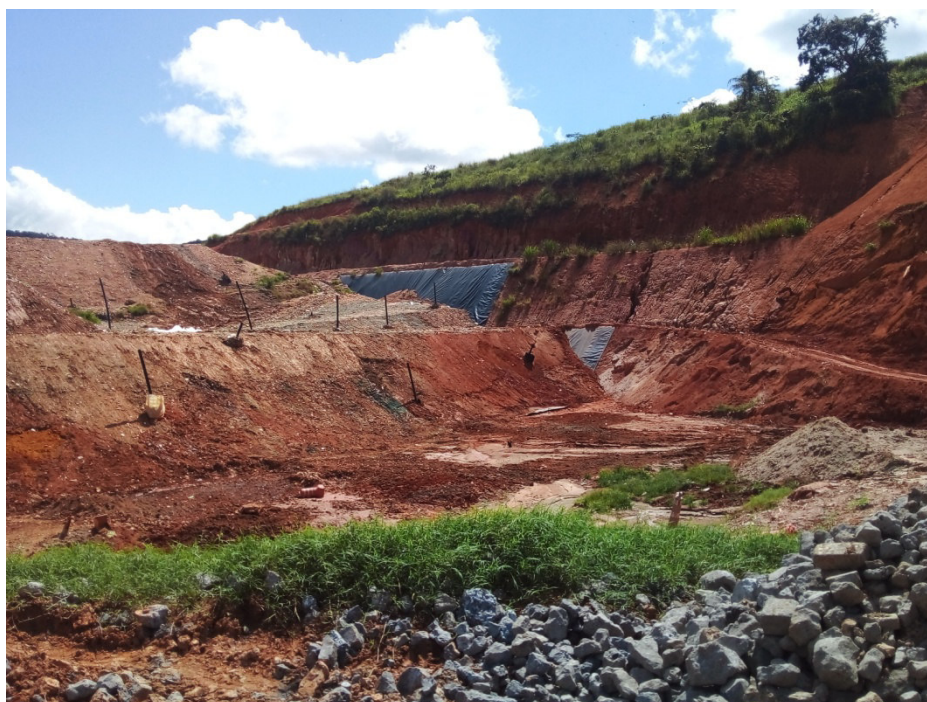
Figura 12: Preparação da nova célula
