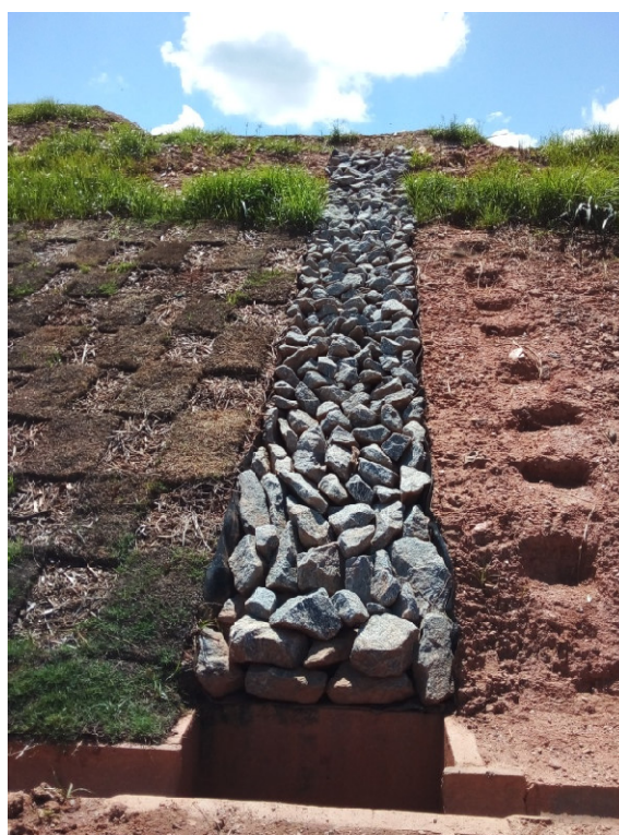
Figura 7: Drenagem do talude
