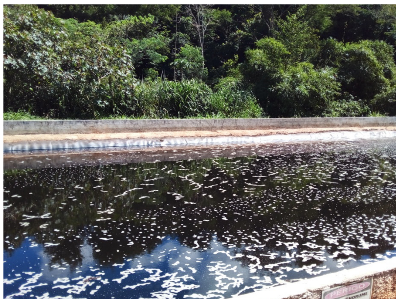
Figura 16: Lagoa de recebimento e armazenagem de chorume.
