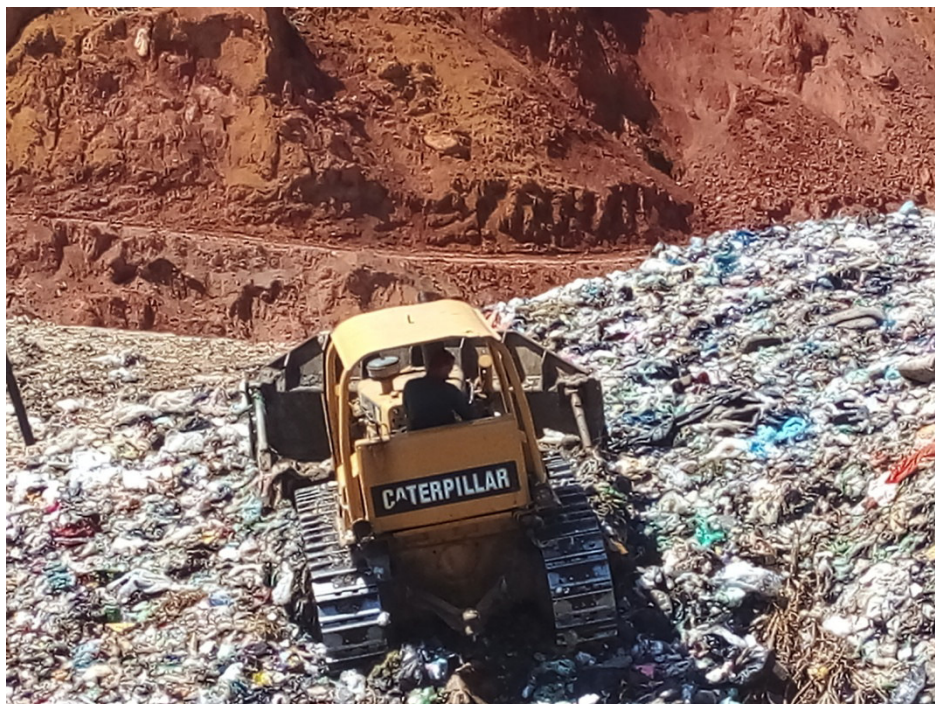
Figura 6: Frente de trabalho. Equipamento operando para compactar e recobrir os resíduos
