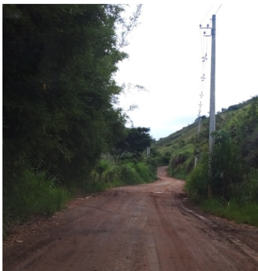
Figura 2: Estrada de acesso apresentando boas condições.
