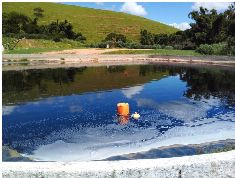
Figura 15: Lagoa de recebimento e armazenagem de chorume.
