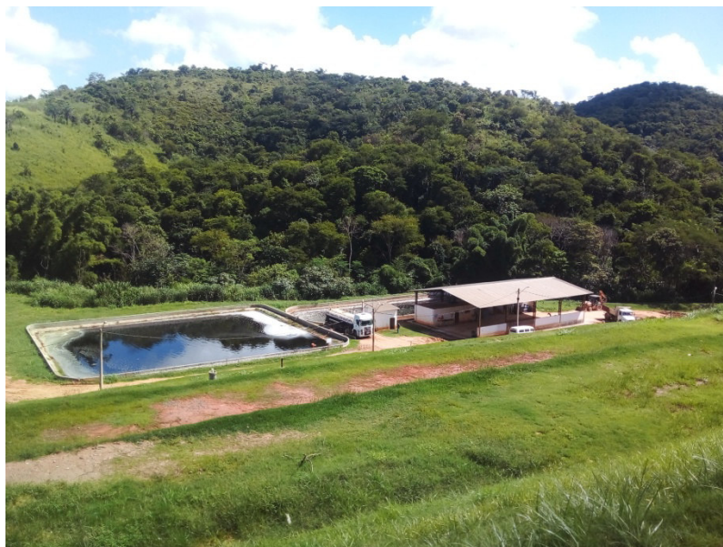
Figura 18: Vista panorâmica da lagoa de armazenagem de chorume no momento da coleta pelo caminhão tanque
