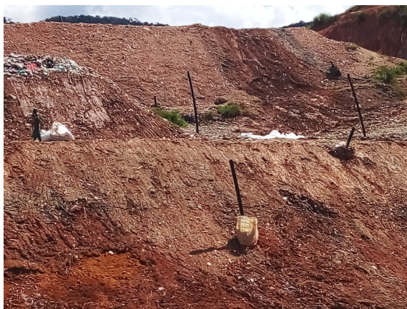
Figura 13: Preparação da nova célula, detalhe dos queimadores
