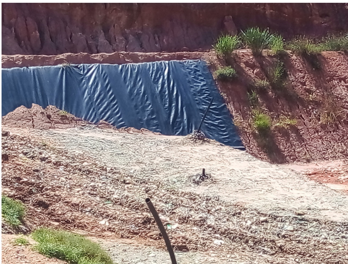
Figura 14: Preparação de nova célula , detalhe na aplicação da geomembrana
