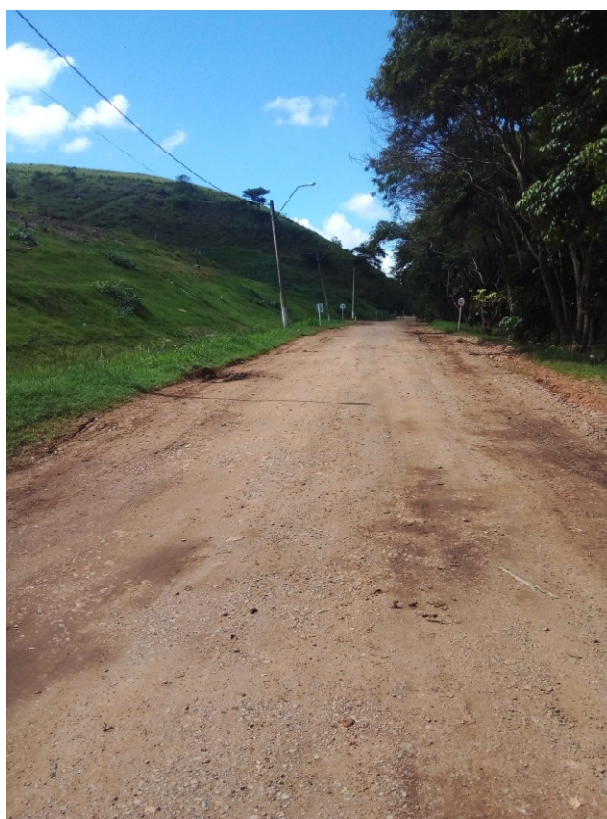
Figura 4: Estrada de acesso interno do aterro
