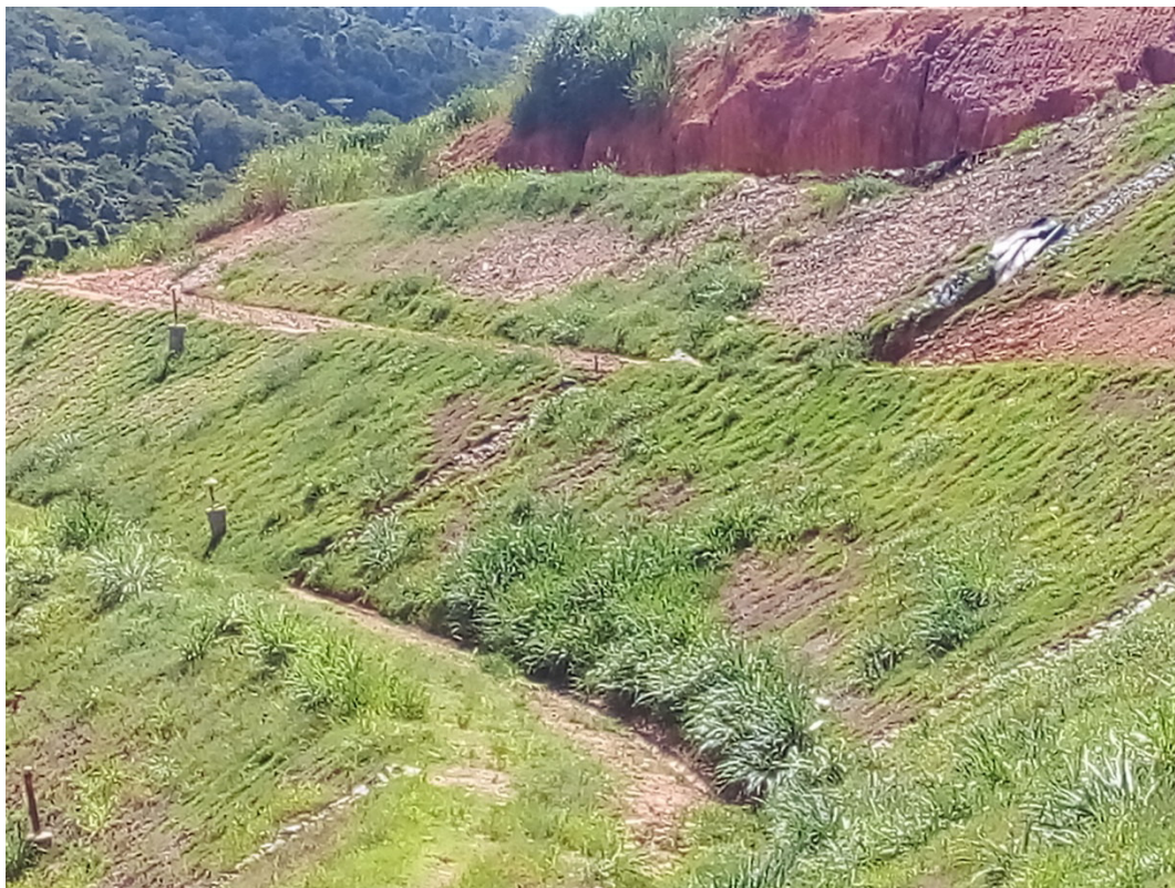
Figura 8: Recomposição vegetal do talude com vista dos queimadores
