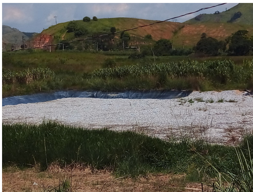
Figura 19 : Construção de uma nova lagoa para recebimento de chorume
