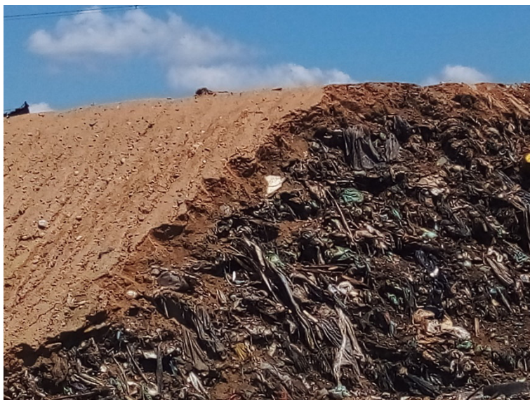
Figura 6: Frente de trabalho – Cobertura dos Resíduos
