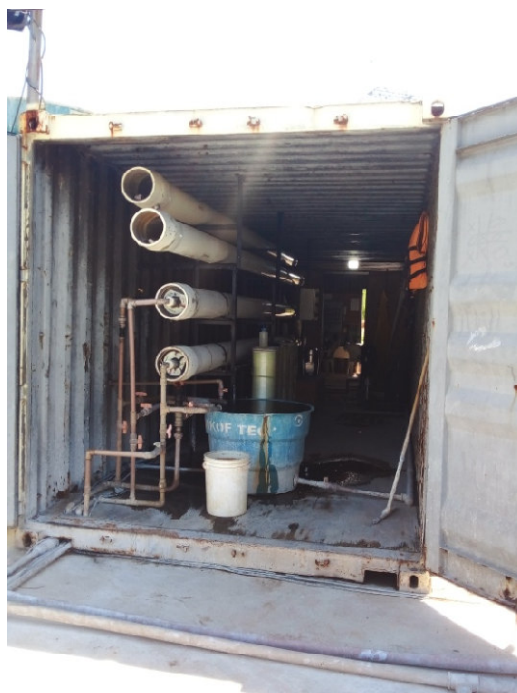
Figura 20 : Sistema de filtragem e membranas para a osmose reversa
