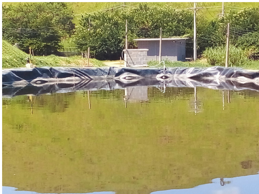
Figura 16 : Nova lagoa de recebimento de chorume já em funcionamento
