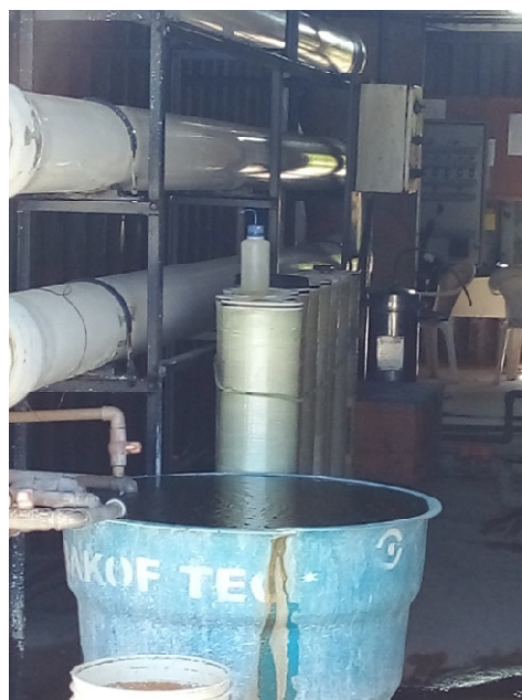
Figura 21: Sistema de filtragem e membranas para a osmose reversa
