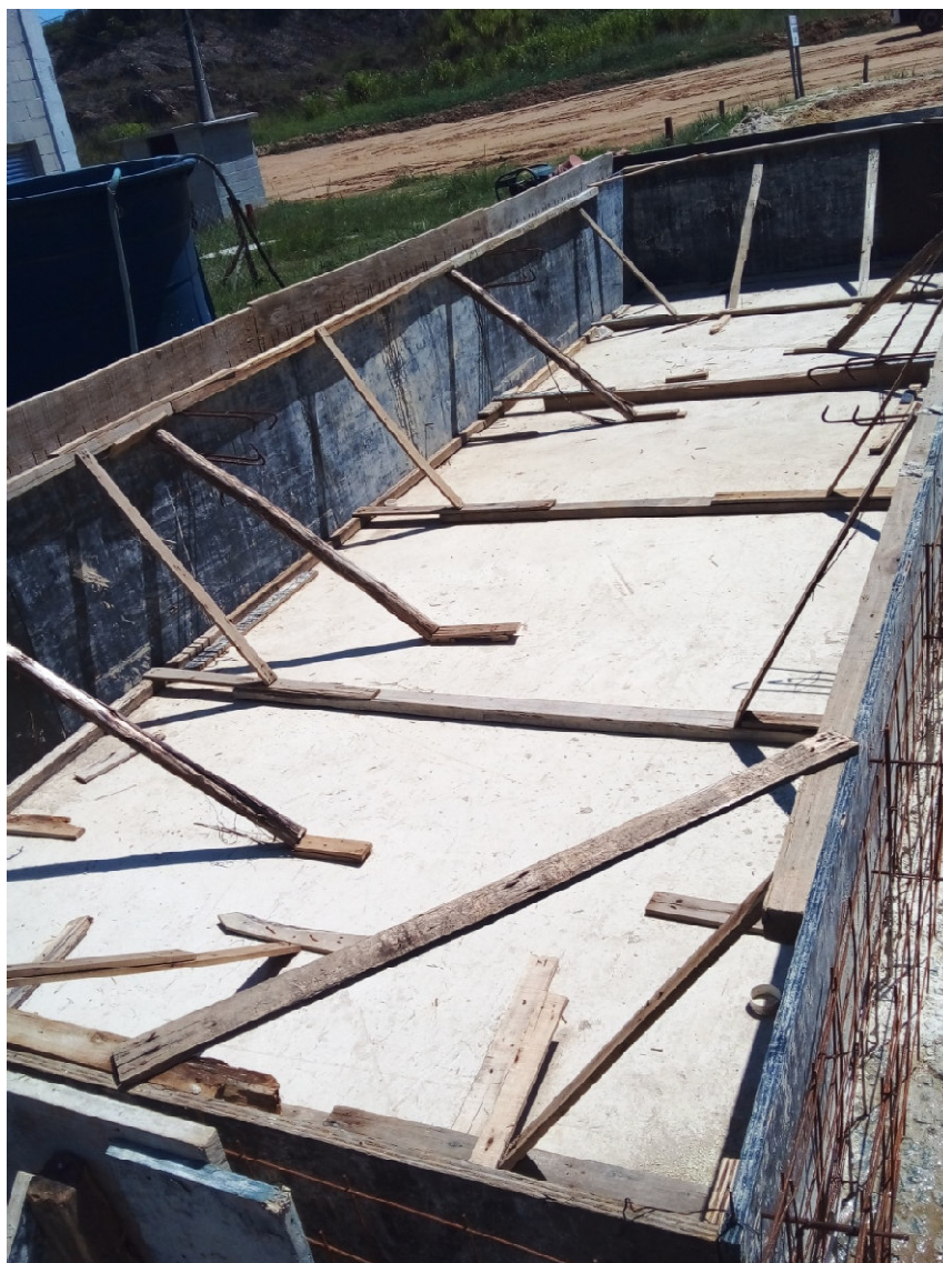
Figura 23: Obra de assentamento para os novos tanques
