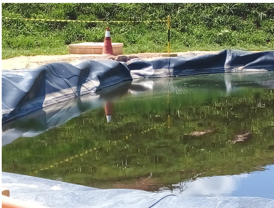
Figura 17 : Nova lagoa de recebimento de chorume já em funcionamento
