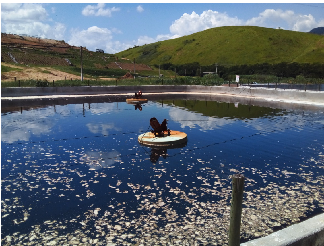
Figura 12: Lagoa de chorume primária com flocculação
