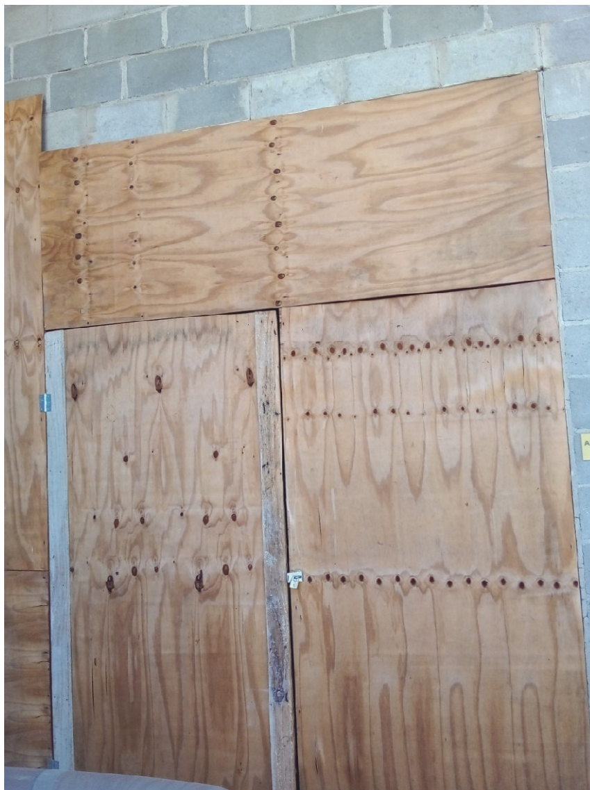
Figura 28: Acesso ao galpão de RSS .
