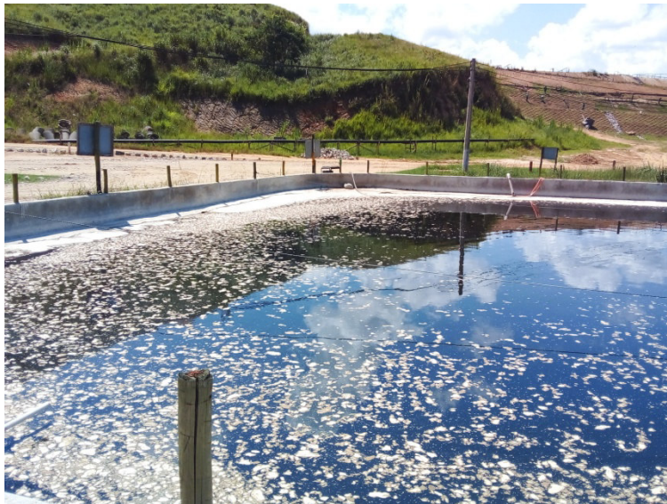
Figura 13: Lagoa de chorume primária com flocculação
