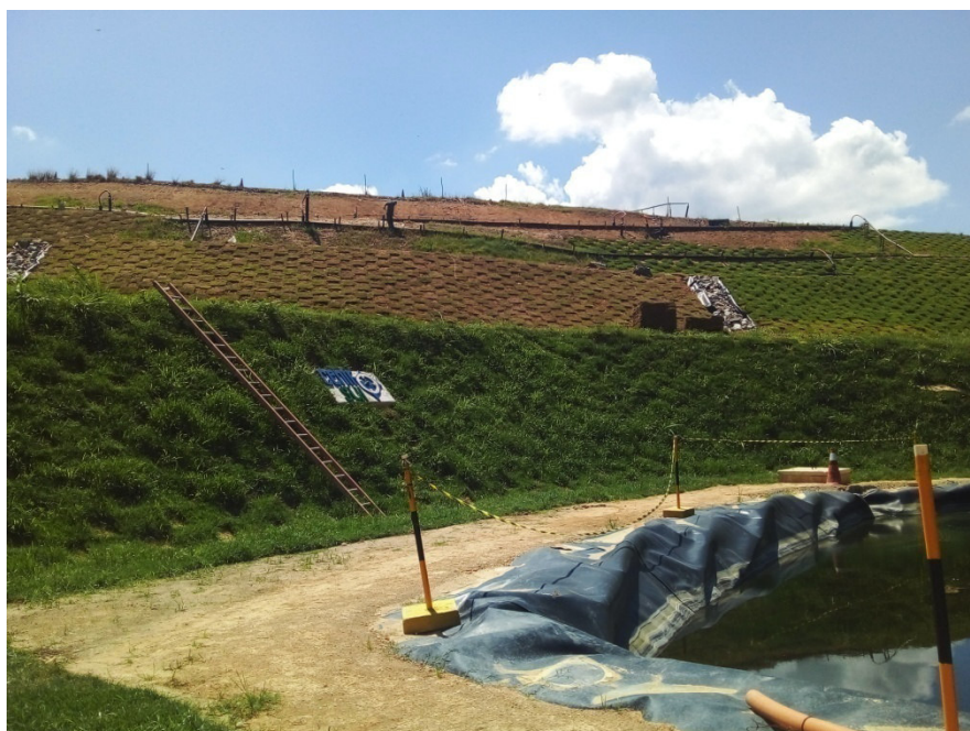
Figura 18 : Detalhe dos taludes com vegetação recomposta da nova lagoa de chorume
