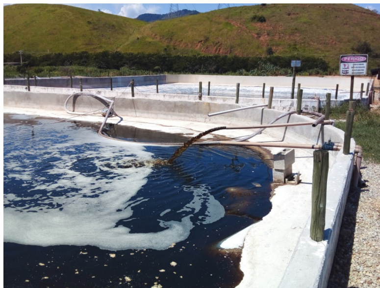
Figura 14: Detalhe vazão do chorume
