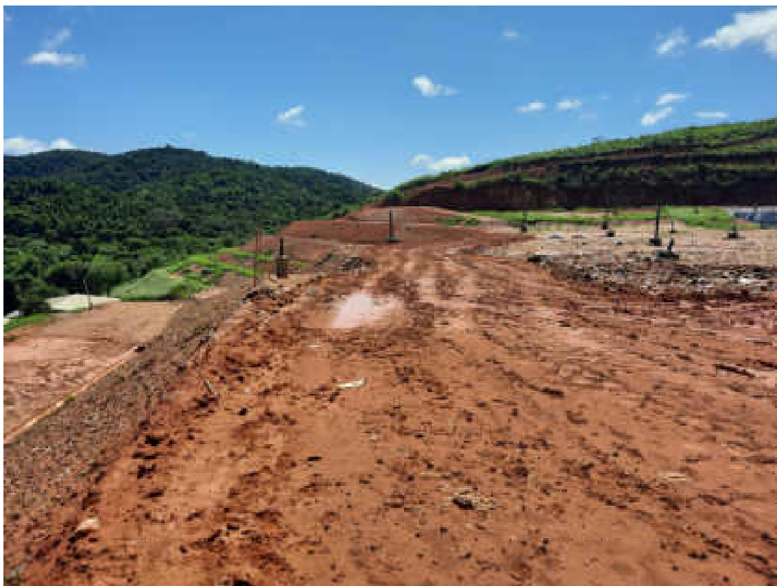
Figura:07 Fortes chuvas no local aproximadamente 200mm/Mês. Fonte: Relatório de Fiscalização CARES/AGENERSA nº 02/2022.
