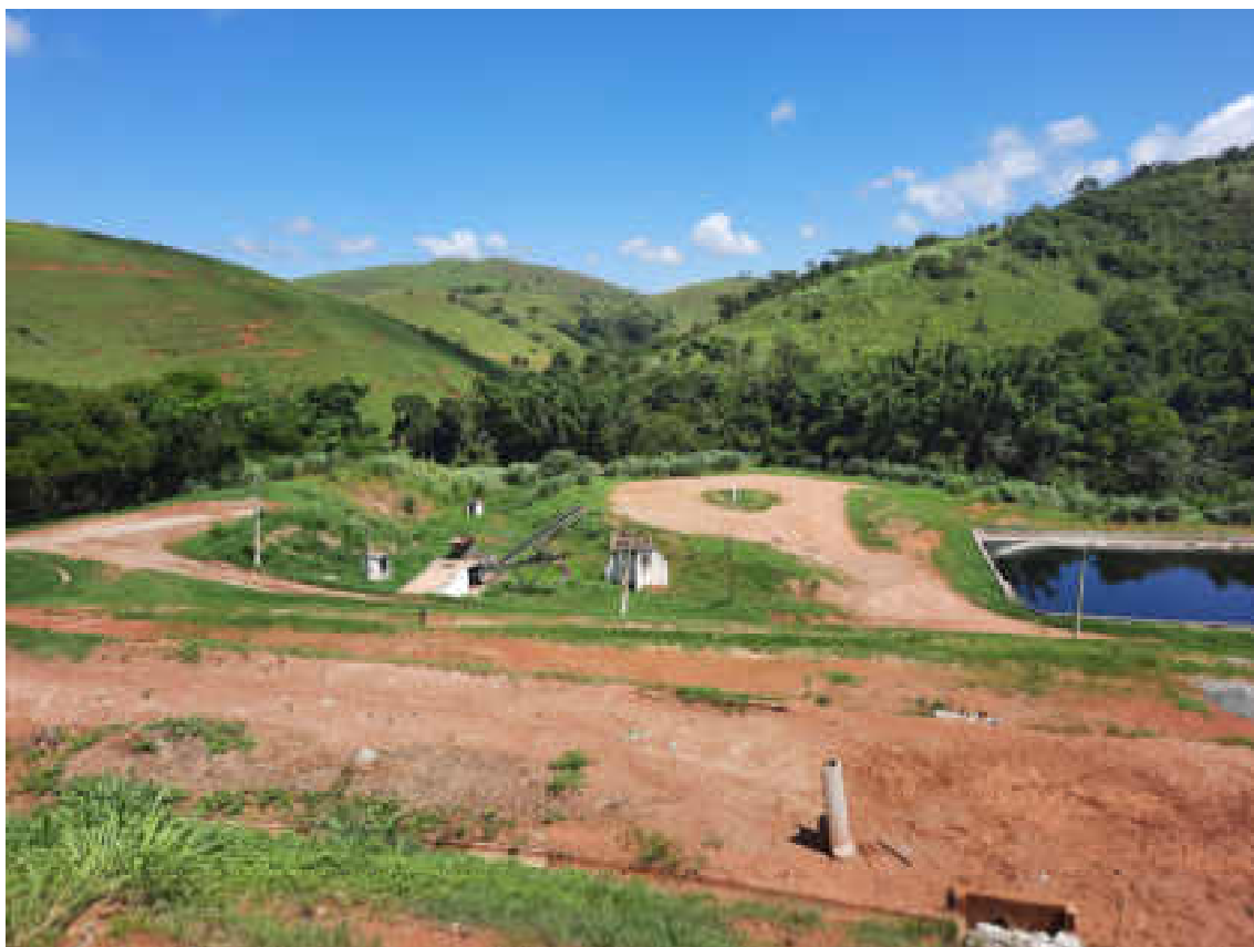
Figura08: Britador de resíduos da construção civil inoperante. Fonte: Relatório de Fiscalização CARES/AGENERSA nº 02/2022.
