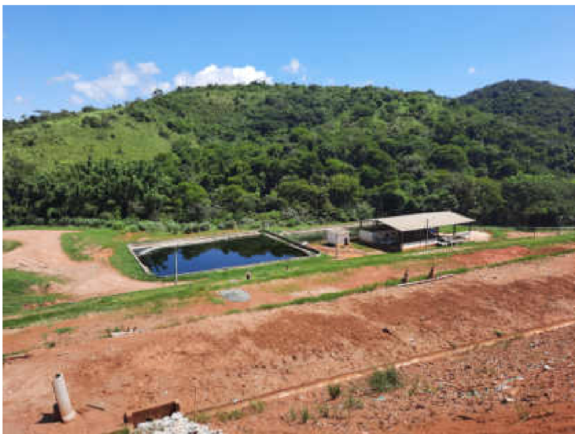
Figura:06: Lagoa de armazenamento de chorume. Fonte: Relatório de Fiscalização CARES/AGENERSA nº 02/2022.
