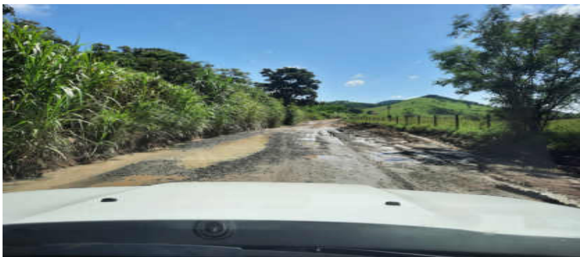
Figura 1: Estrada de acesso ao CTDR apresentando más condições. Fonte: Relatório de Fiscalização CARES/AGENERSA nº 02/2022.
