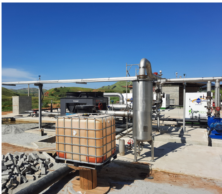
Figura 04 Motor gerador de energia , através do Biogás. Detalhe do Flare ao fundo
