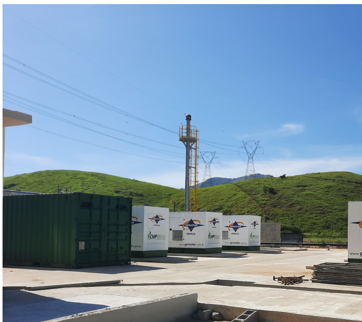
Figura 04 Motor gerador de energia , através do Biogás. Detalhe do Flare ao fundo
