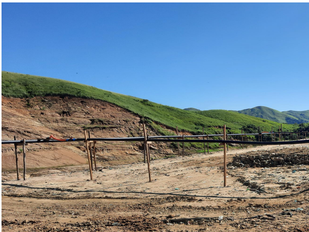
Figura 03 Implantação da Captação do biogás.
