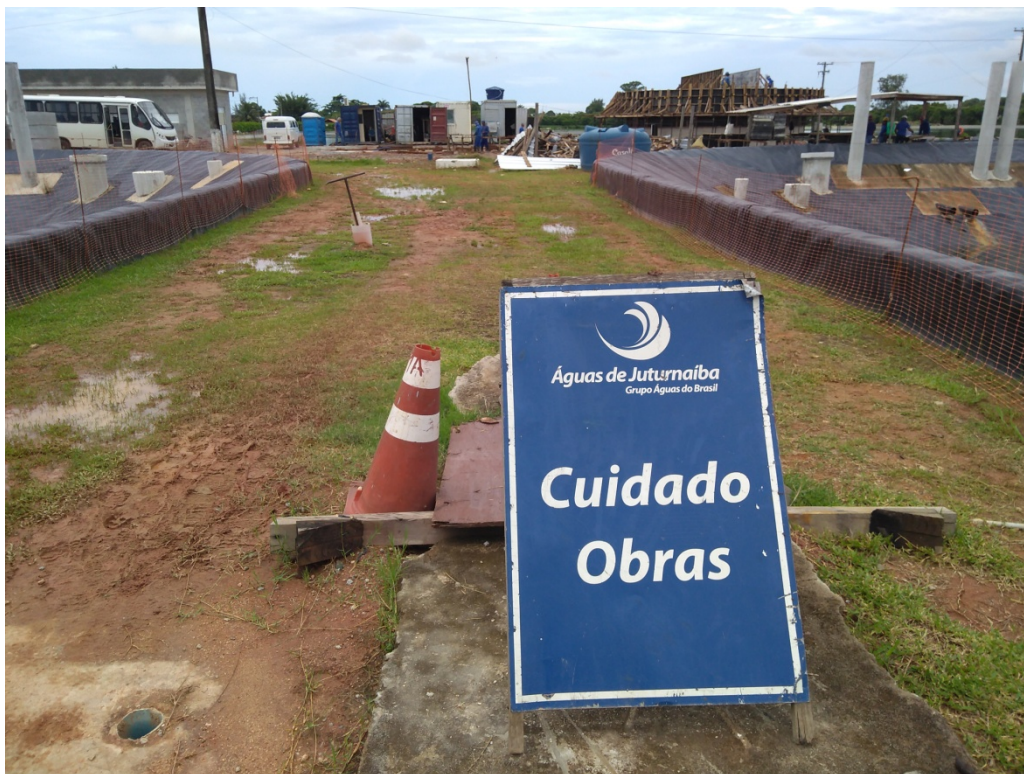
Foto 20 – Obras de Ampliação e Modernização da ETE Ponte dos Leites
