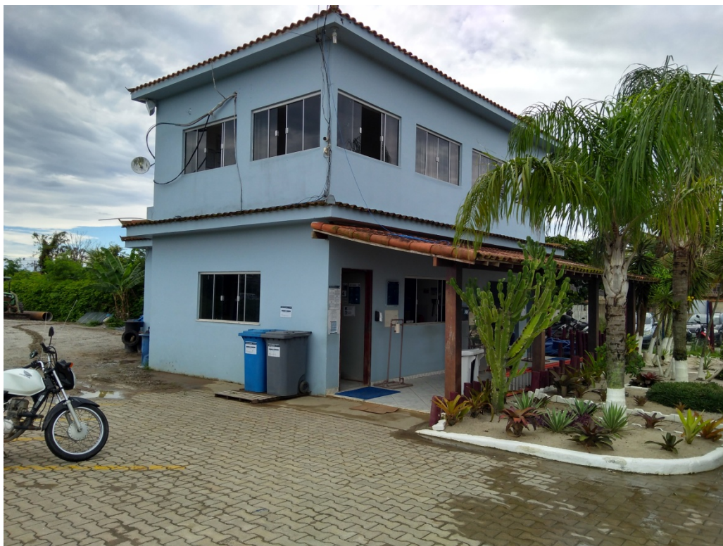
Foto 22 – Escritório da Estação de Tratamento Ponte dos Leites
