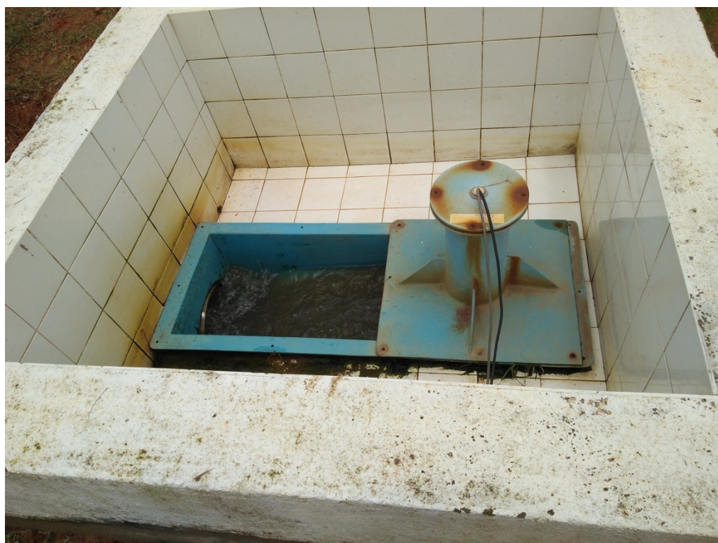
Foto 09 – Calha Parshall com Medidor de Vazão Ultrassônico
