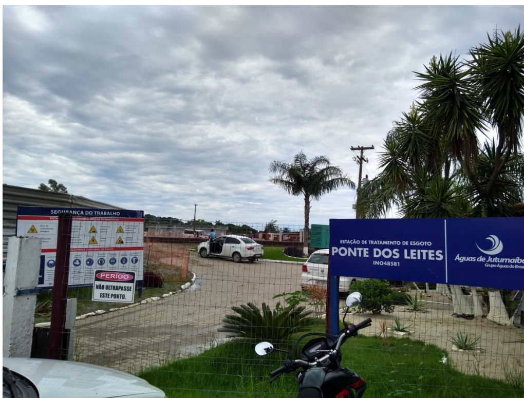
Foto 01 – Entrada da ETE Ponte dos Leites
