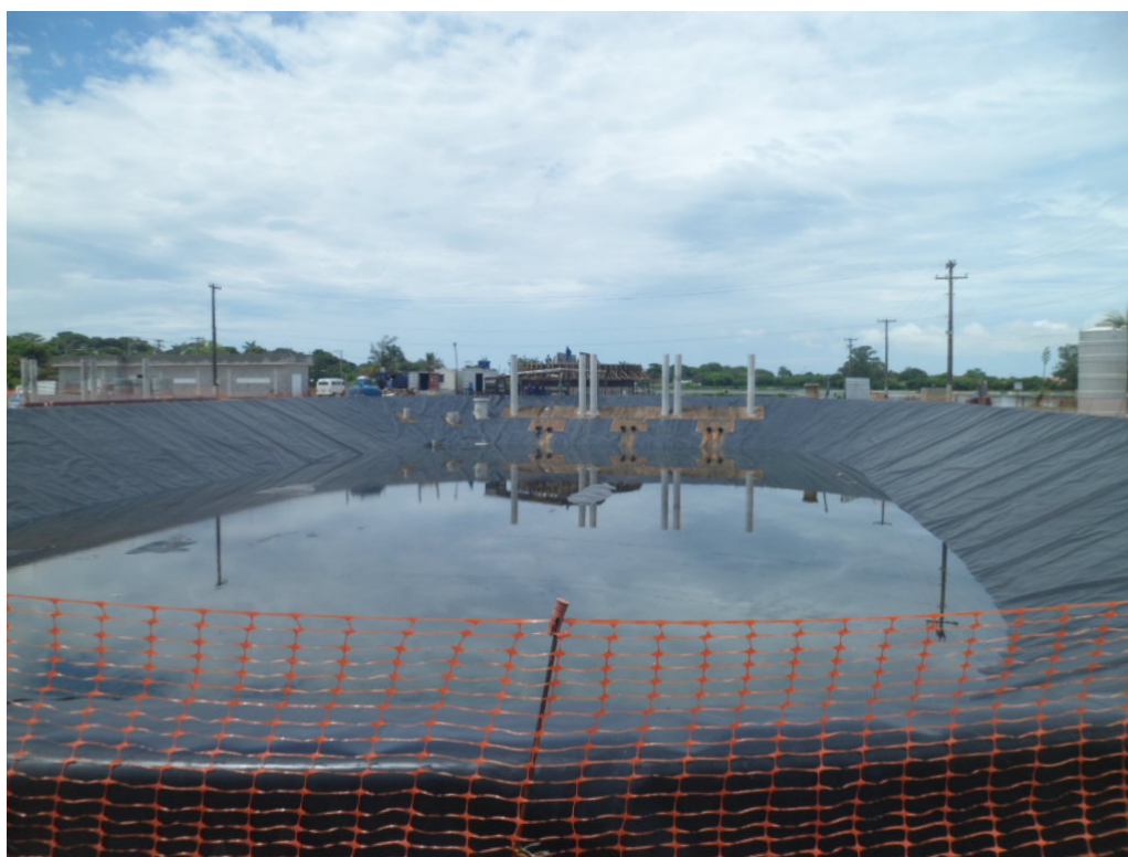
Foto 19 – Obra de Ampliação e Modernização da ETE
