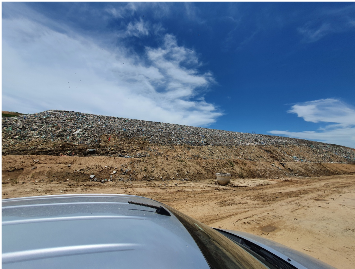
Figura 01: Frente de trabalho sem cobertura de solo.
