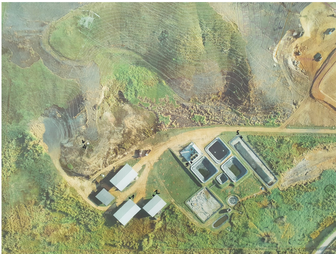
Figura 04: Vista aérea do aterro .
