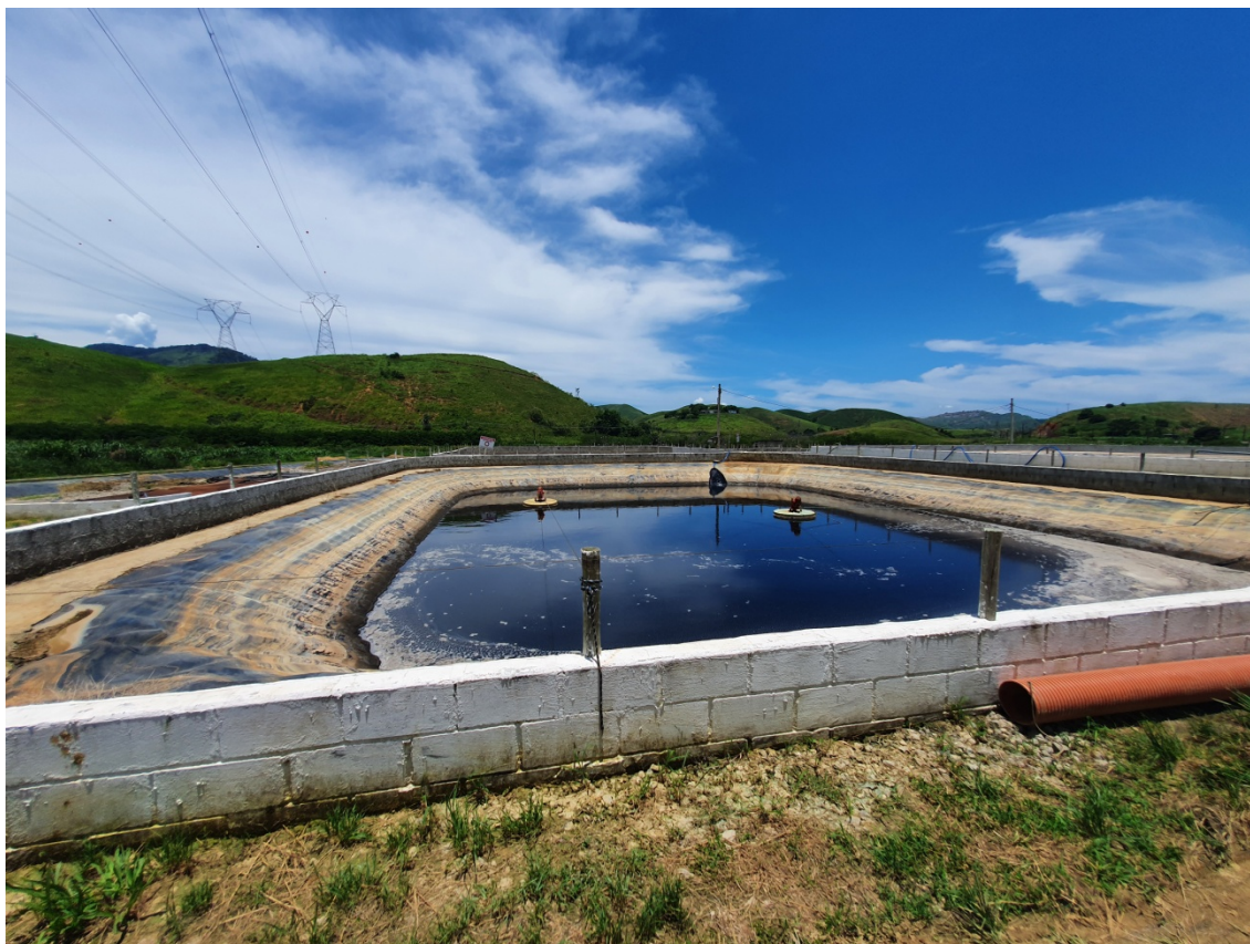
Figura 04: Lagoa de chorume com aerador sem funcionamento.
