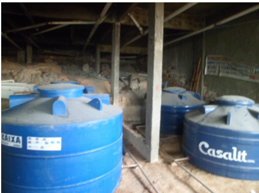
Foto 07 – 02 (dois) Reservatórios com 3.000 litros d'Água
