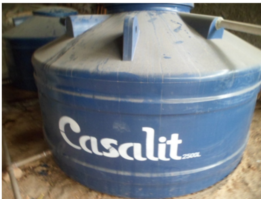
Foto 06 – 02 (dois) Reservatórios com 2.500 litros d'Água
