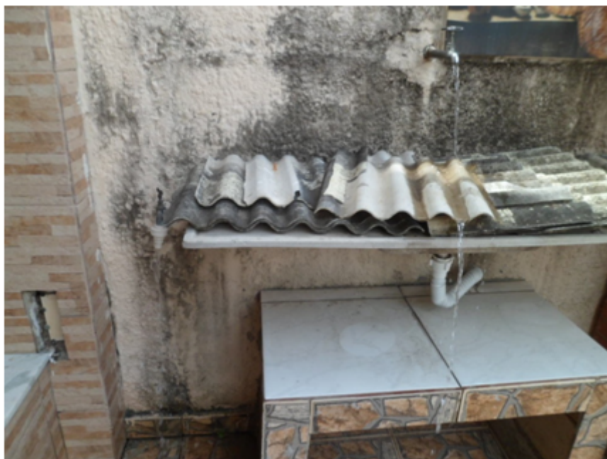
Foto 03 – Torneira aberta com água na frente do prédio
