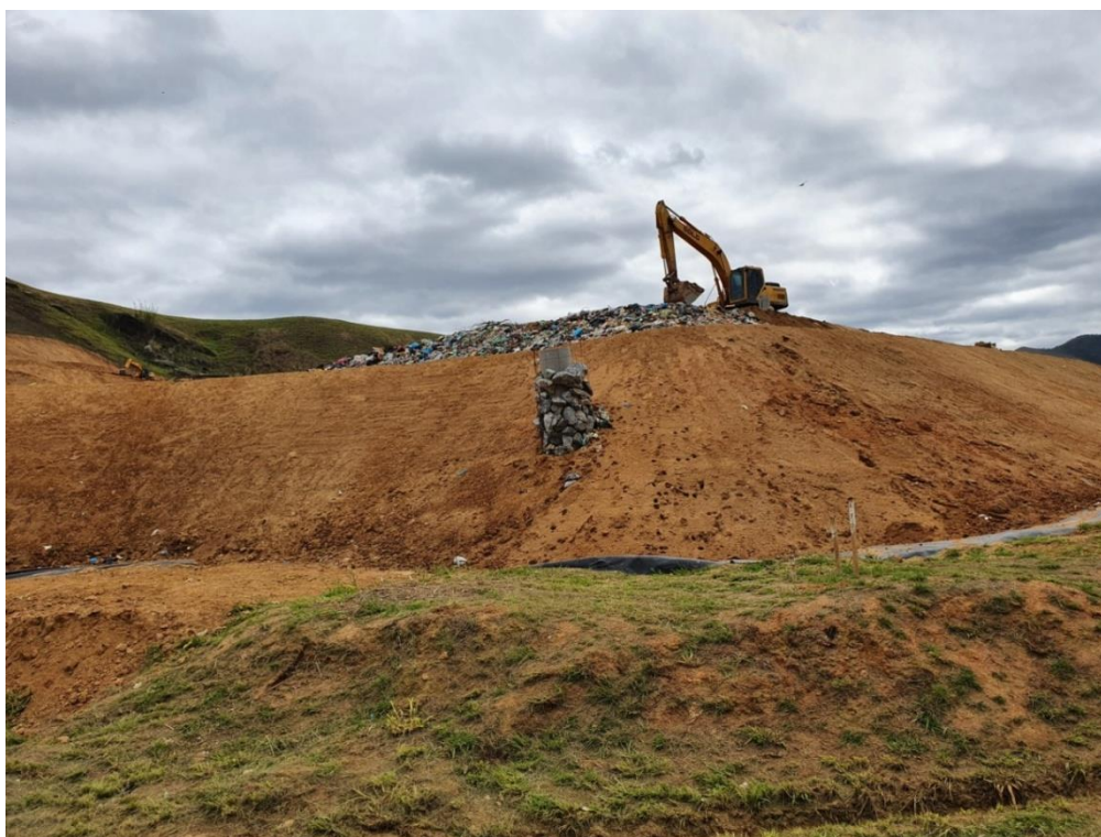
Figura 6: Vista lateral da frente de trabalho
