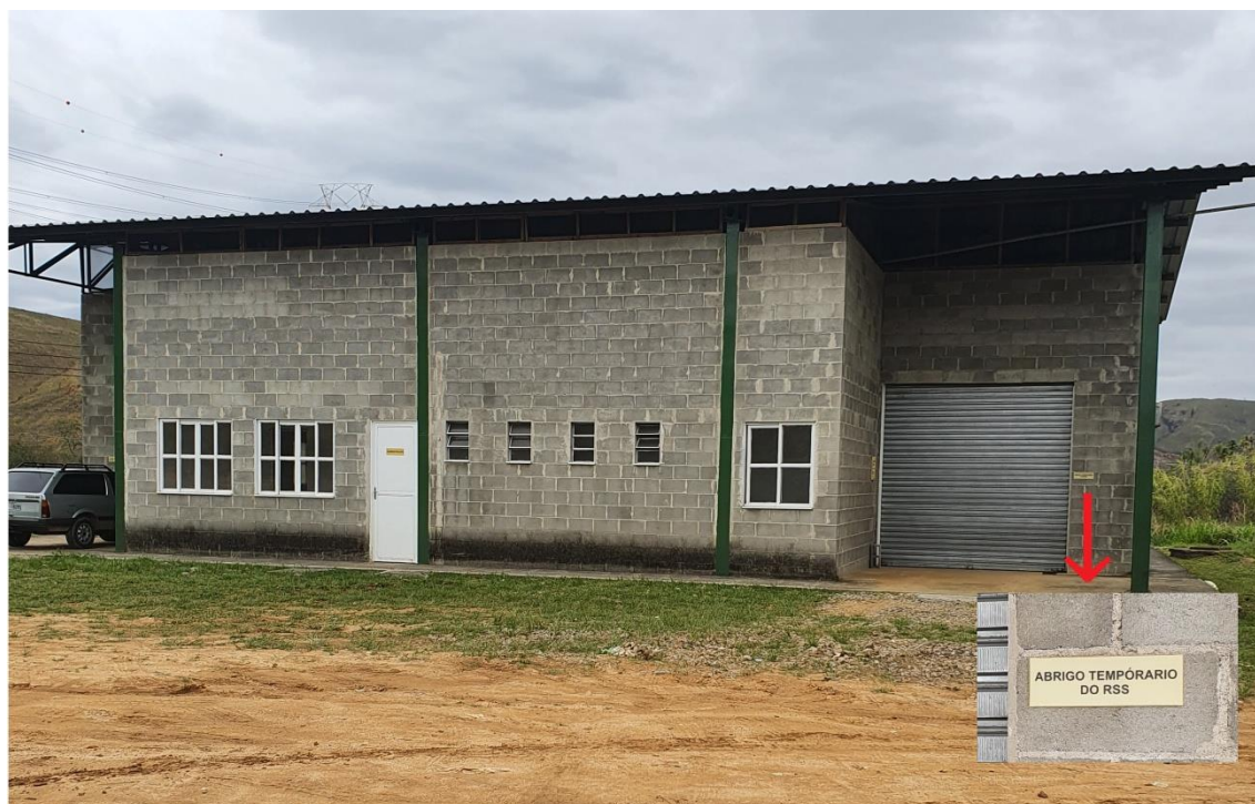
Figura 20: Sala da autoclave e abrigo temporário de RSS
