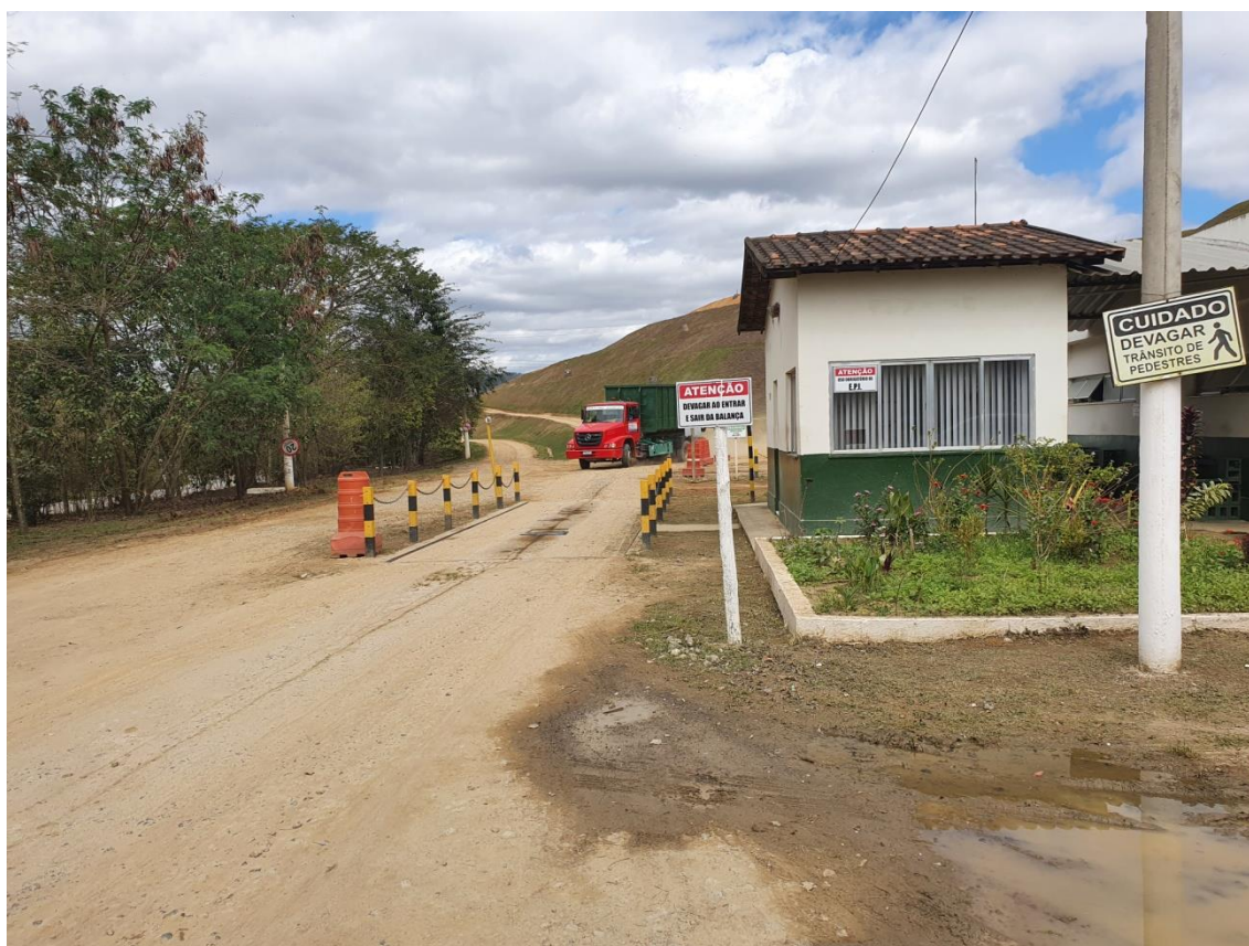
Figura 2: Cinturão verde, balança de pesagem, guarita e placas
