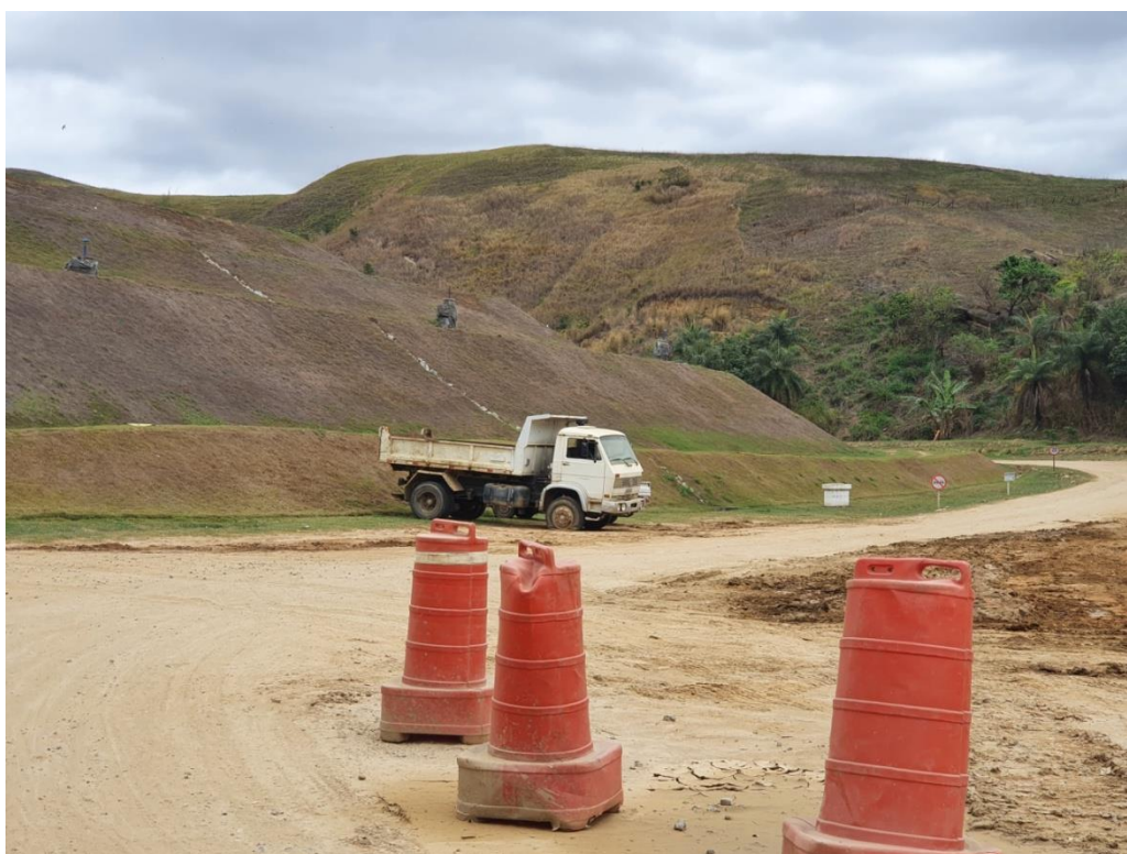
Figura 4: Vista parcial da fase 1
