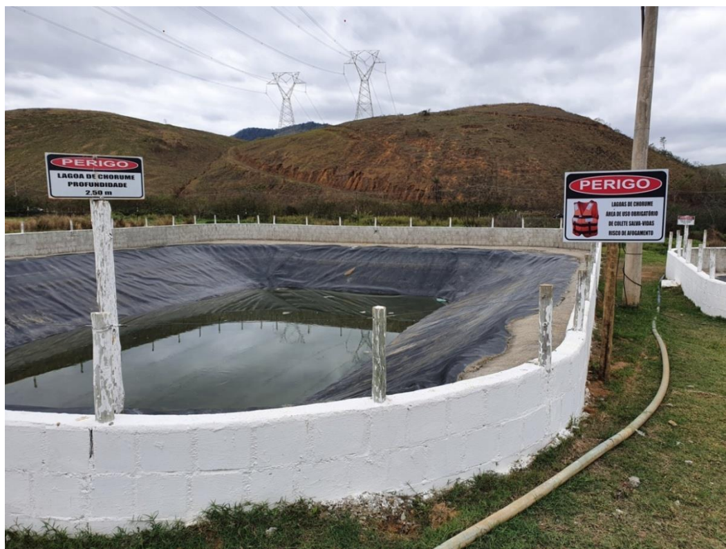
Figura 12: Lagoa de chorume e placas de sinalização
