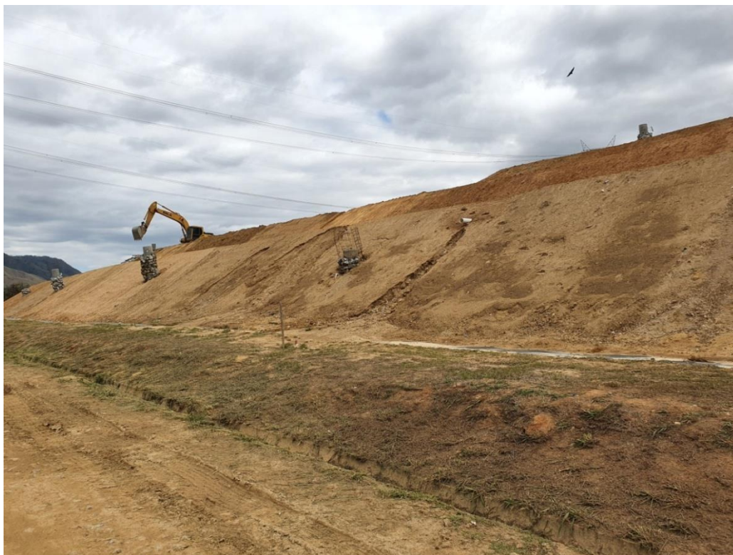
Figura 5: Vista parcial das fases 2 e 3
