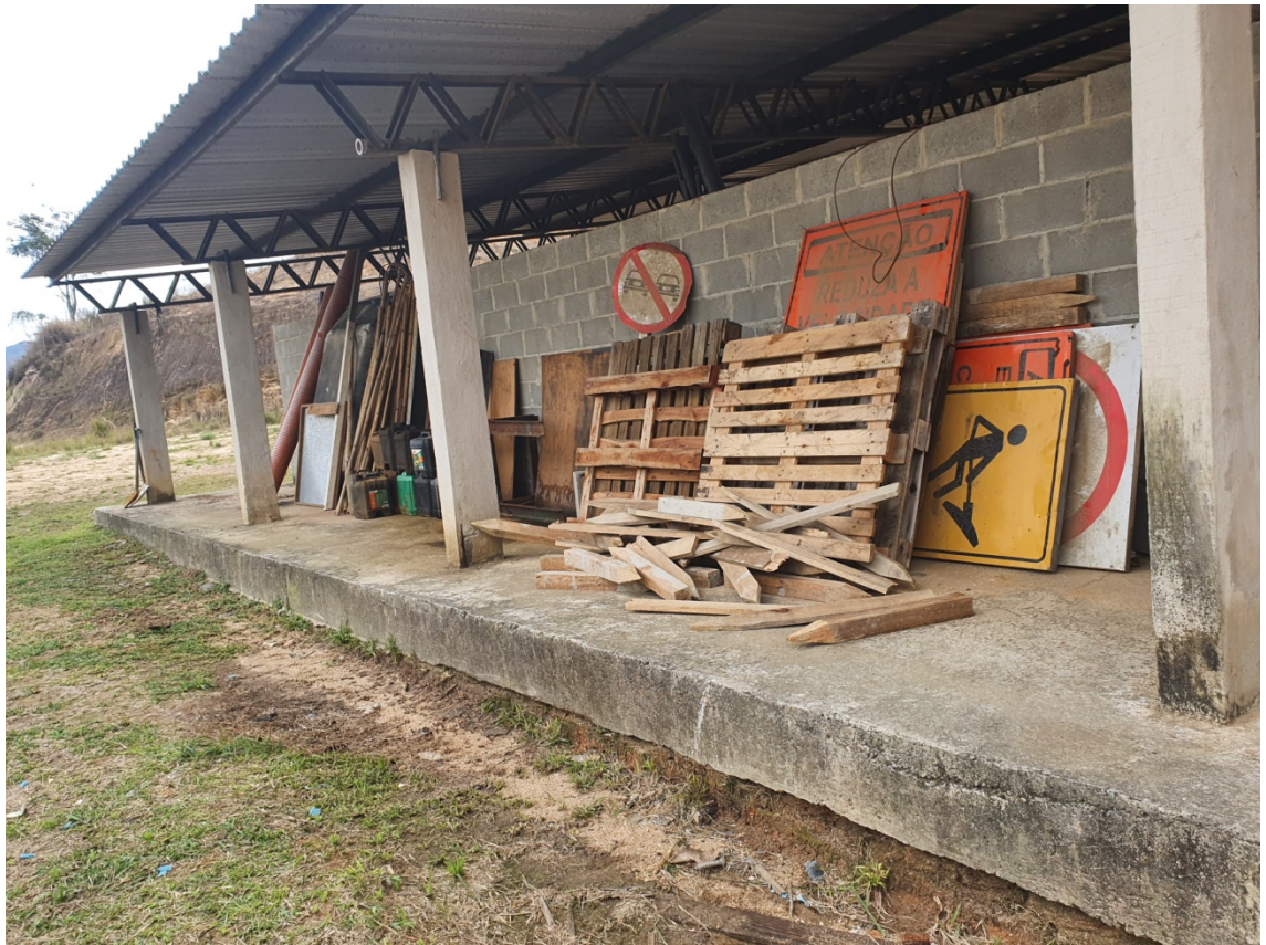
Figura 06 Unidades de Triagem e Apoio à Coleta Seletiva
