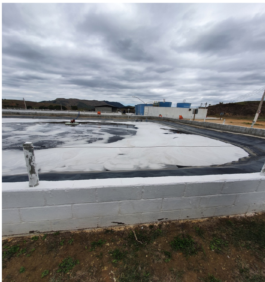
Figura 03: Lagoa de chorume com aerador em funcionamento.
