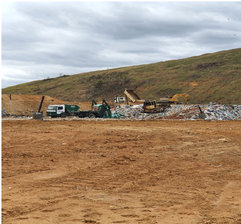
Figura 02: Vista da frente de trabalho.
