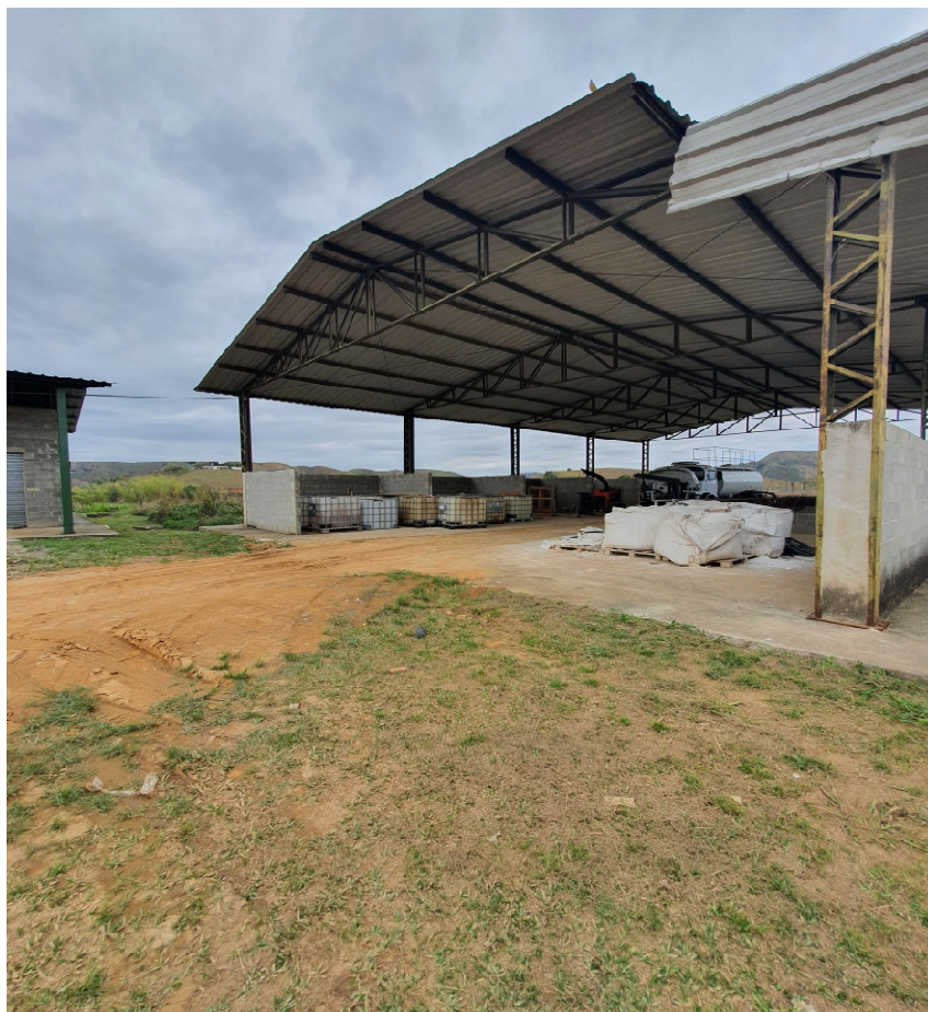
Figura 07 Os galpões destinados para as unidades de triagem e apoio à coleta seletiva .
