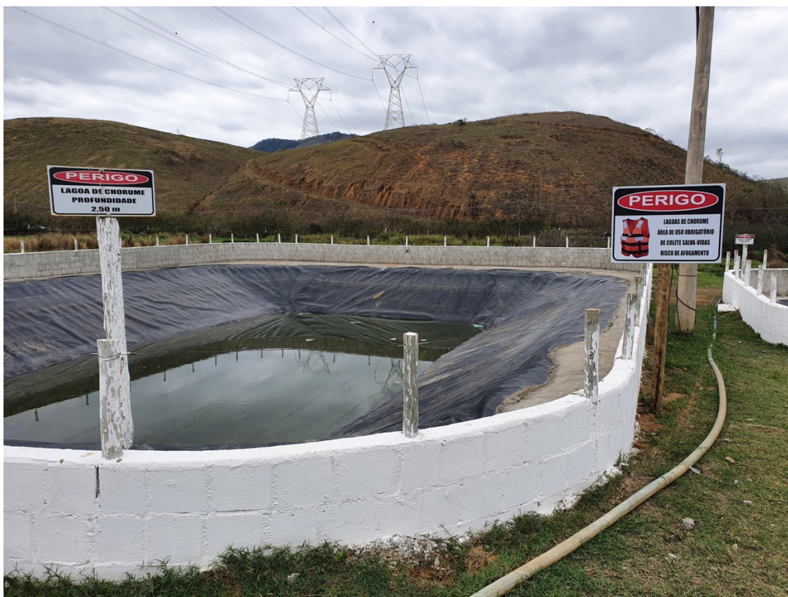
Figura 04: Lagoa de tratamento de chorume.
