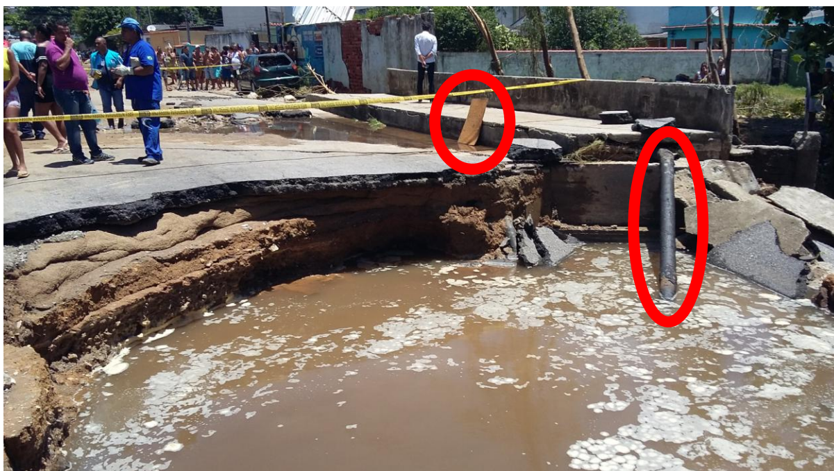
DETALHE EM VERMELHO - JANELA DE VISITA (40 x 100CM) E TUBULAÇÃO DA CEG
