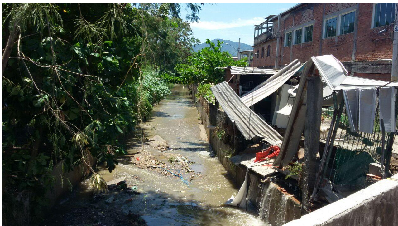
DETALHE DO RIO DOS CACHORROS, JUNTO AO VAZAMENTO
