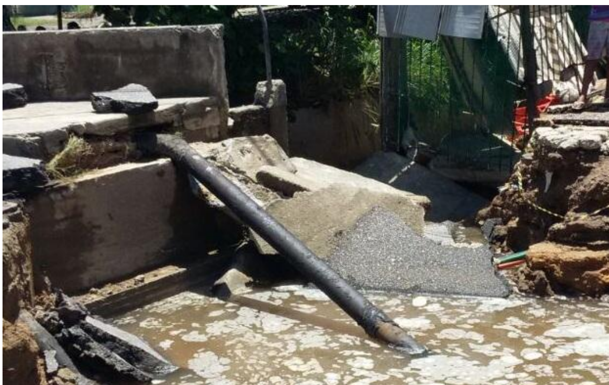
TUBULAÇÃO DA CEG
