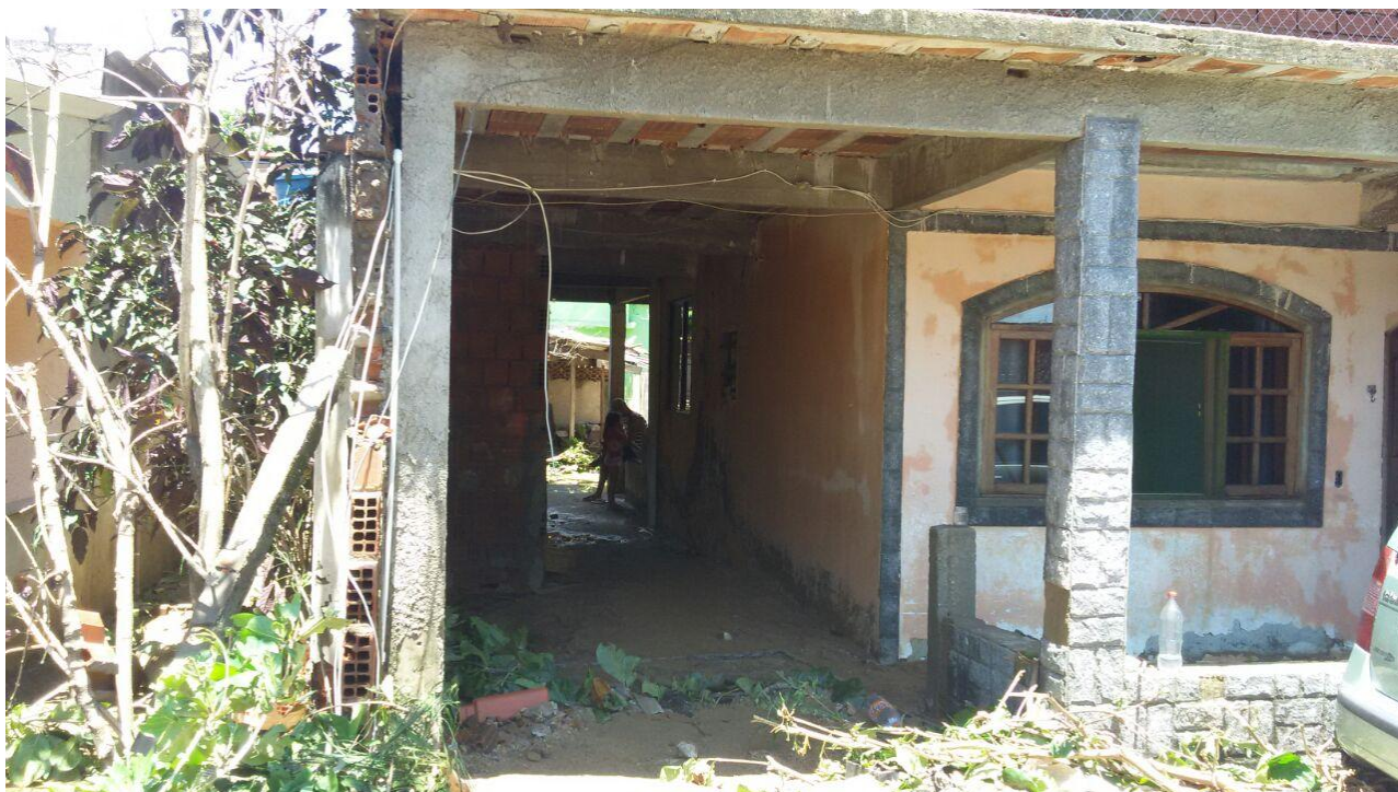
RESIDÊNCIA INVADIDA PELA ÁGUA
