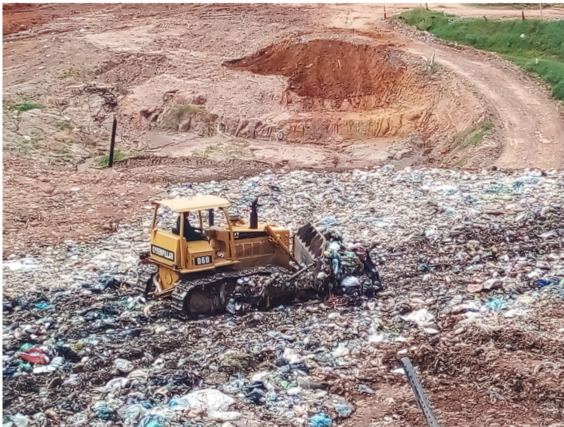
Figura 7: Frente de trabalho. Equipamento operando para recobrir os resíduos
