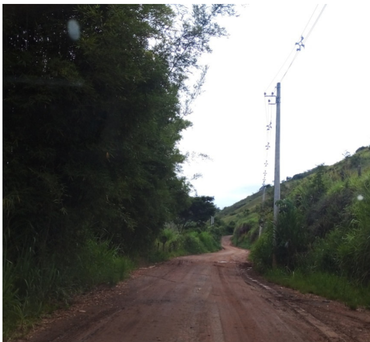
Figura 2: Estrada de acesso apresentando boas condições.
