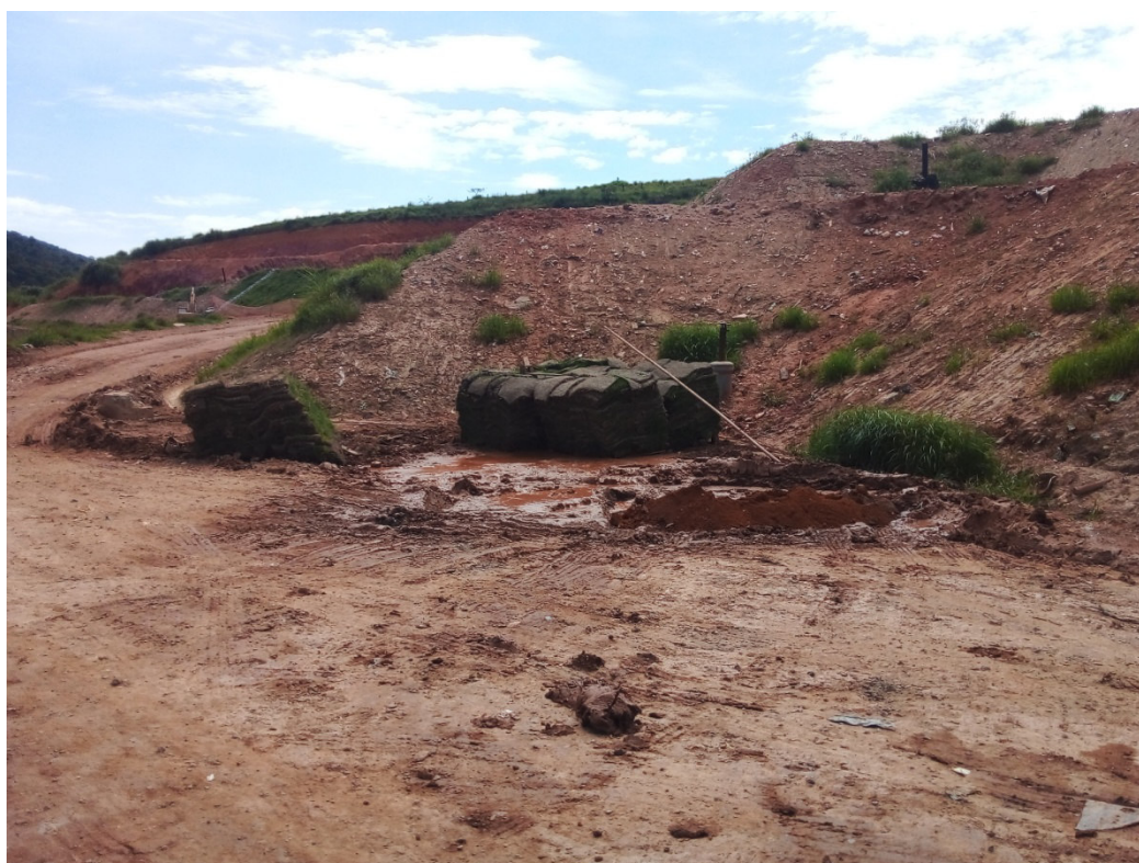
Figura 9: Talude com recomposição das gramíneas
