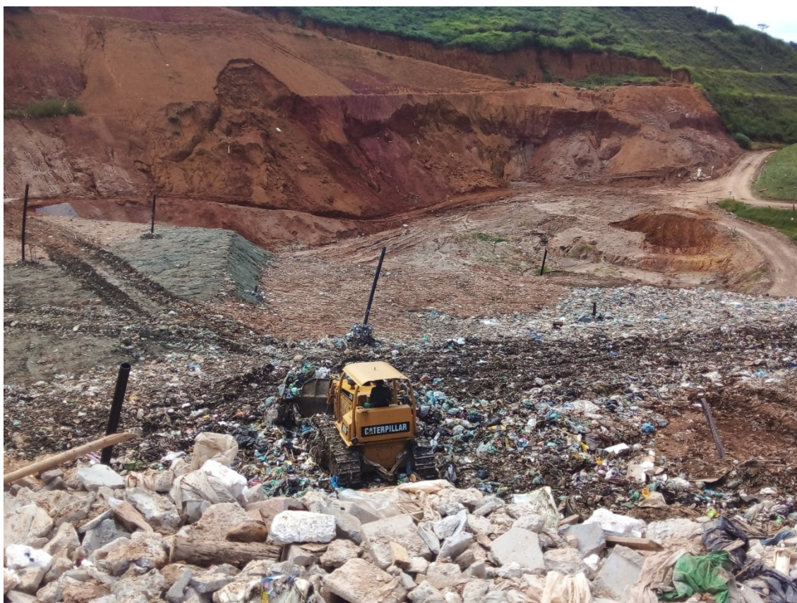
Figura 6: Frente de trabalho. Equipamento operando para recobrir os resíduos
