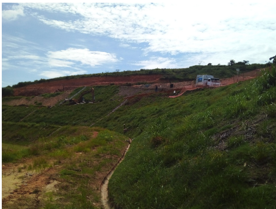
Figura 8: Talude com vegetação recomposta .
