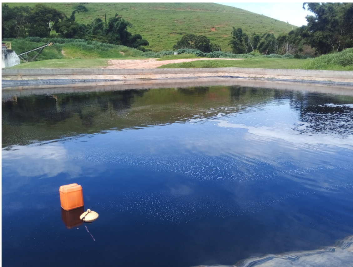
Figura 10: Lagoa de recebimento e armazenagem de chorume.
