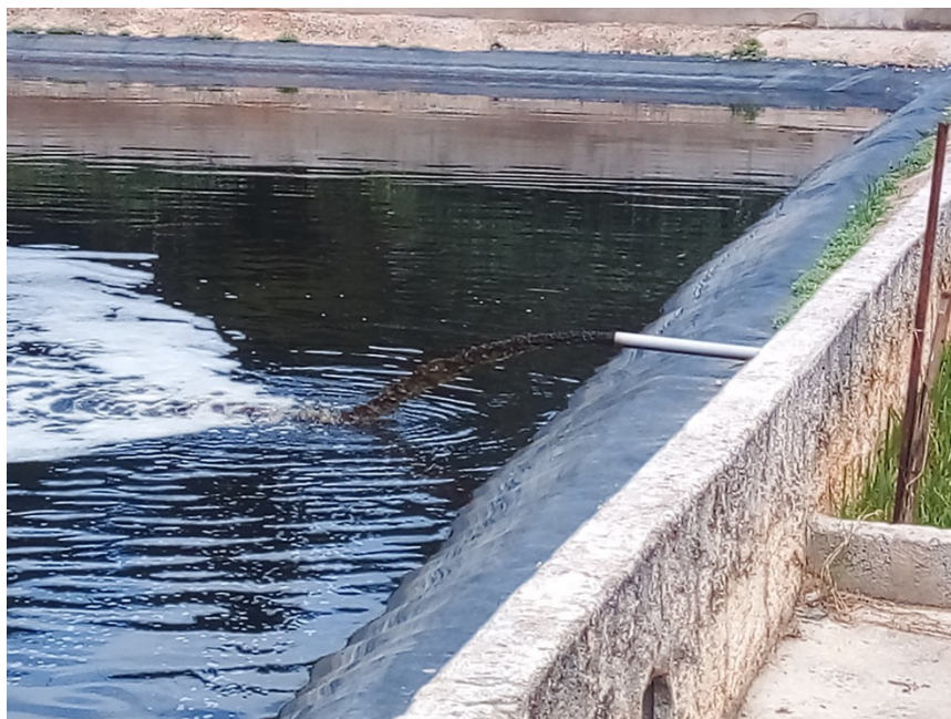
Figura 11: Lagoa de recebimento e armazenagem de chorume.
