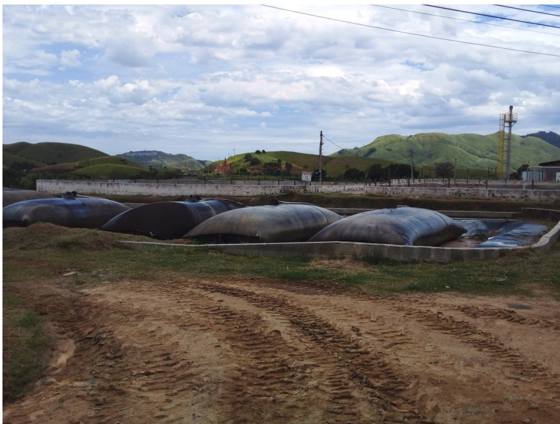
Figura 19: Bags de armazenagem e secagem do lodo
