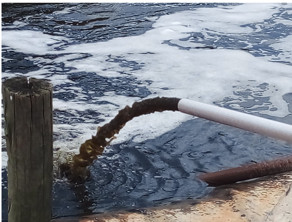
Figura 10: Detalhe vazão do chorume
