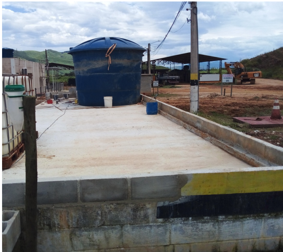
Figura 16: Obra de ampliação da capacidade de tratamento do chorume por osmose reversa
