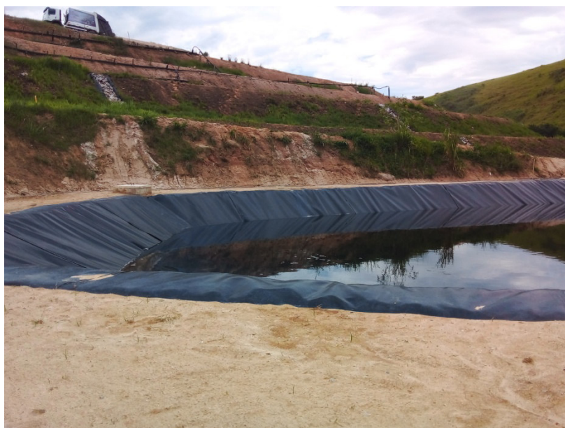
Figura 13 : Nova lagoa de recebimento de chorume
