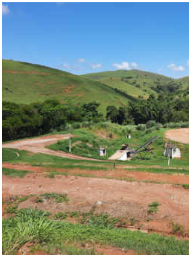
Figura 6: Britador de resíduos da construção civil inoperante..
