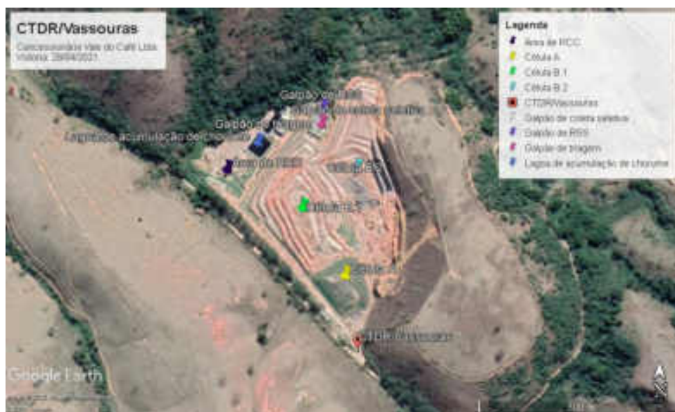
Figura 1: Vista aérea do CTDR/Vassouras. Fonte: Google Earth, 28/04/2021.
