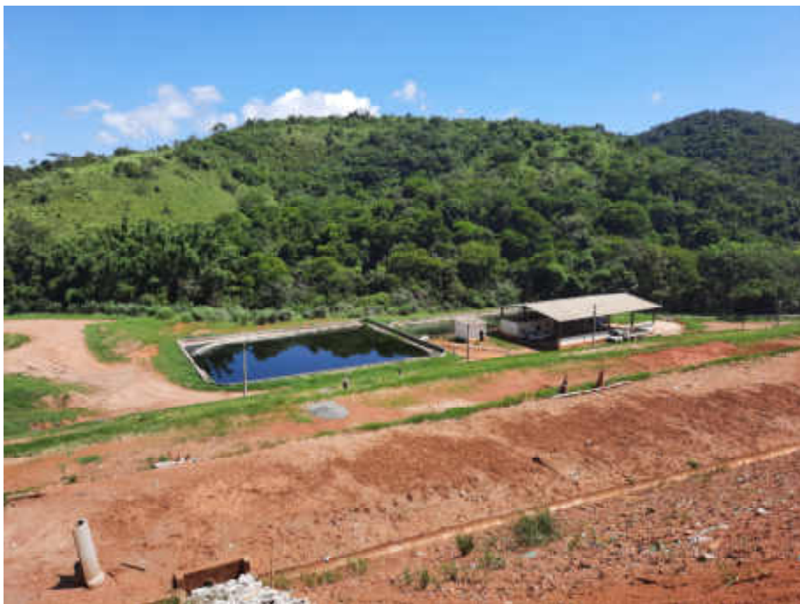
Figura:05: Lagoa de armazenamento de chorume
