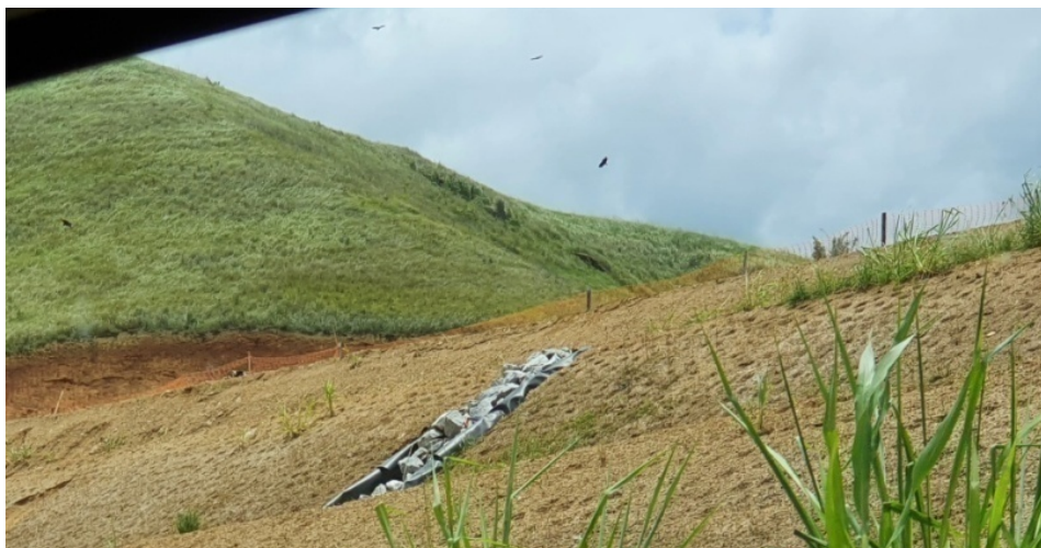
Figura 3: Vista das camadas já operadas onde foi feita a hidrossemeadura.
