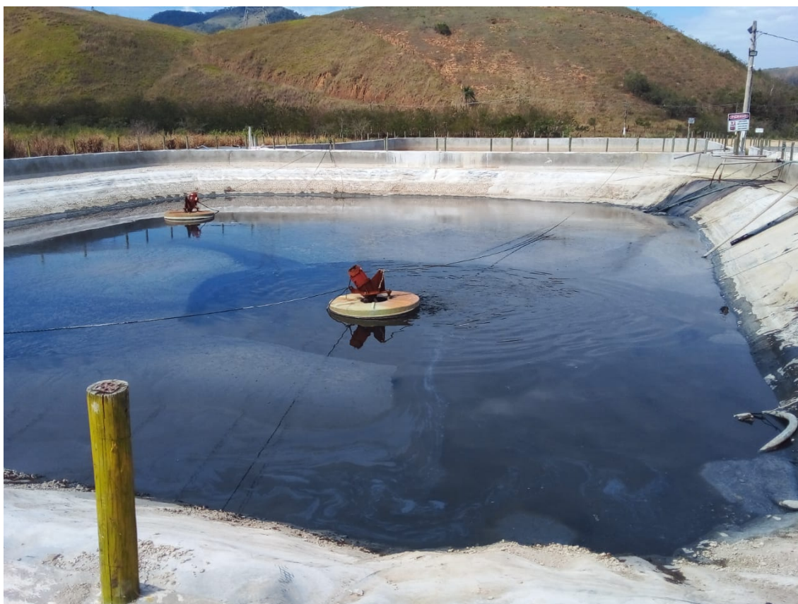
Figura7: Lagoa de tratamento de chorume.
