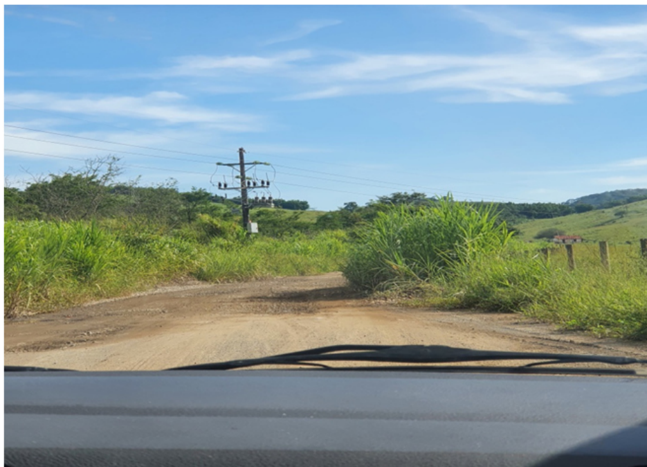
Figura 2: Estrada de acesso apresentando boas condições.
