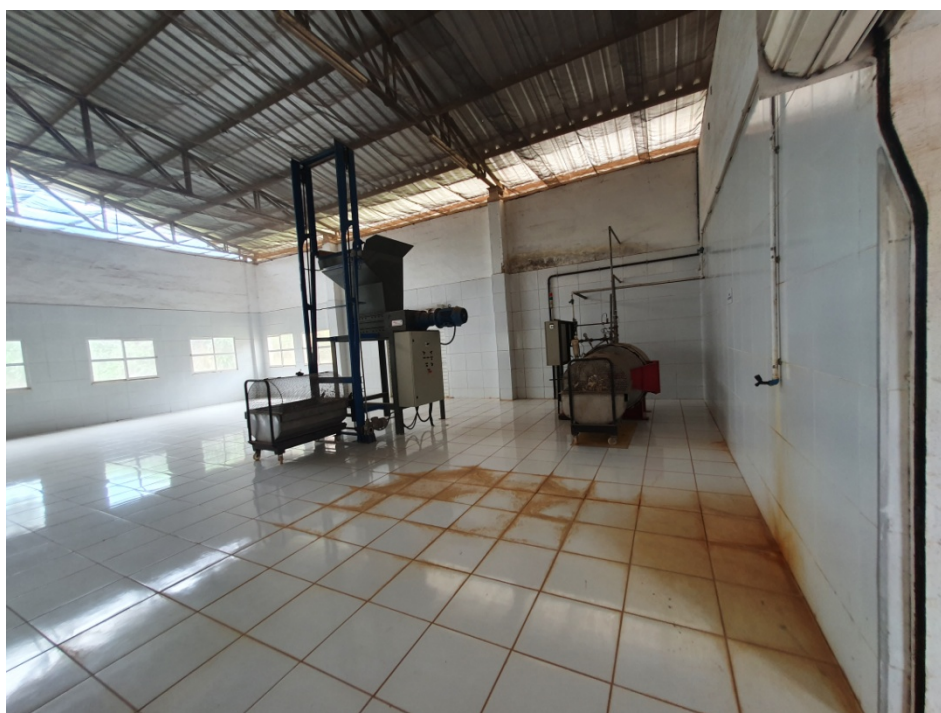
Figura 13: Autoclave disponibilizada para realizar o tratamento de RSS. Inoperante.
