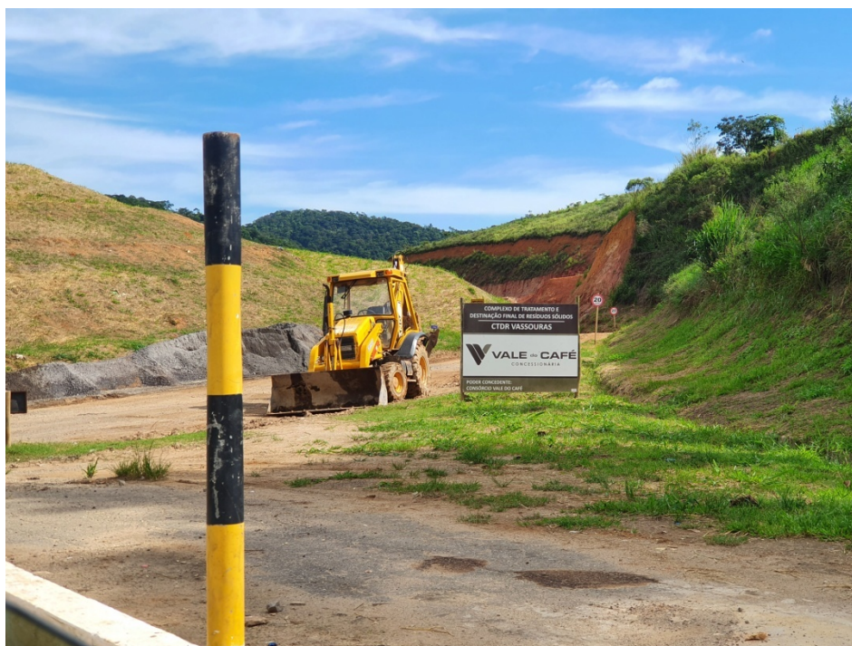
Figura 6: Entrada do aterro sanitário visto da balança de pesagem.
