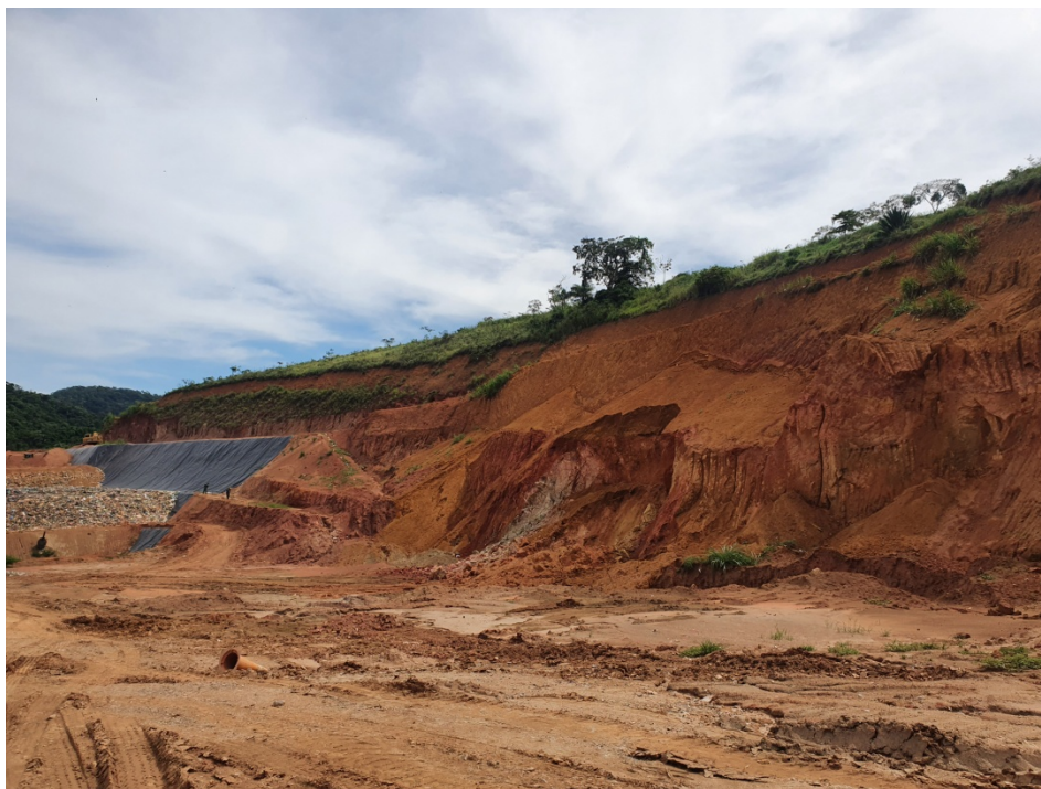
Figura 8: Jazida utilizada para recobrimento de resíduos e pavimentação das vias e, ao fundo, frente de trabalho.
