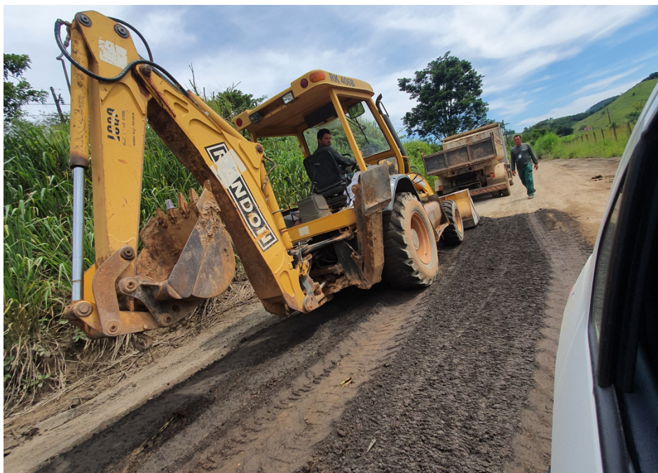
Figura 5: Trabalho de melhoria na via de acesso ao aterro.
