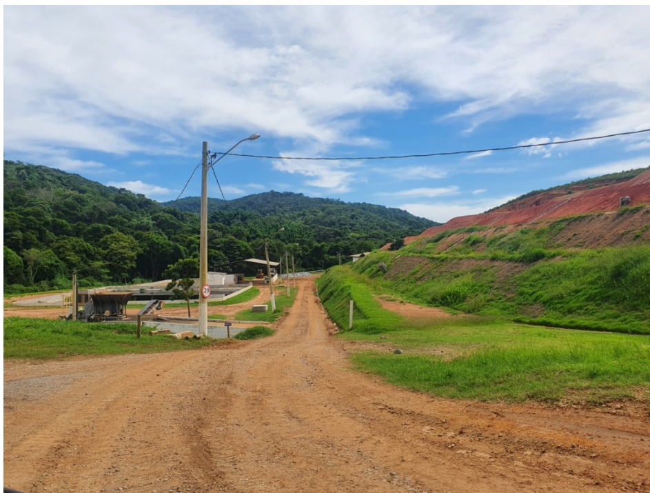
Figura 10: Vista do britador de resíduo de construção civil à esquerda e lateral da célula b, à direita.
