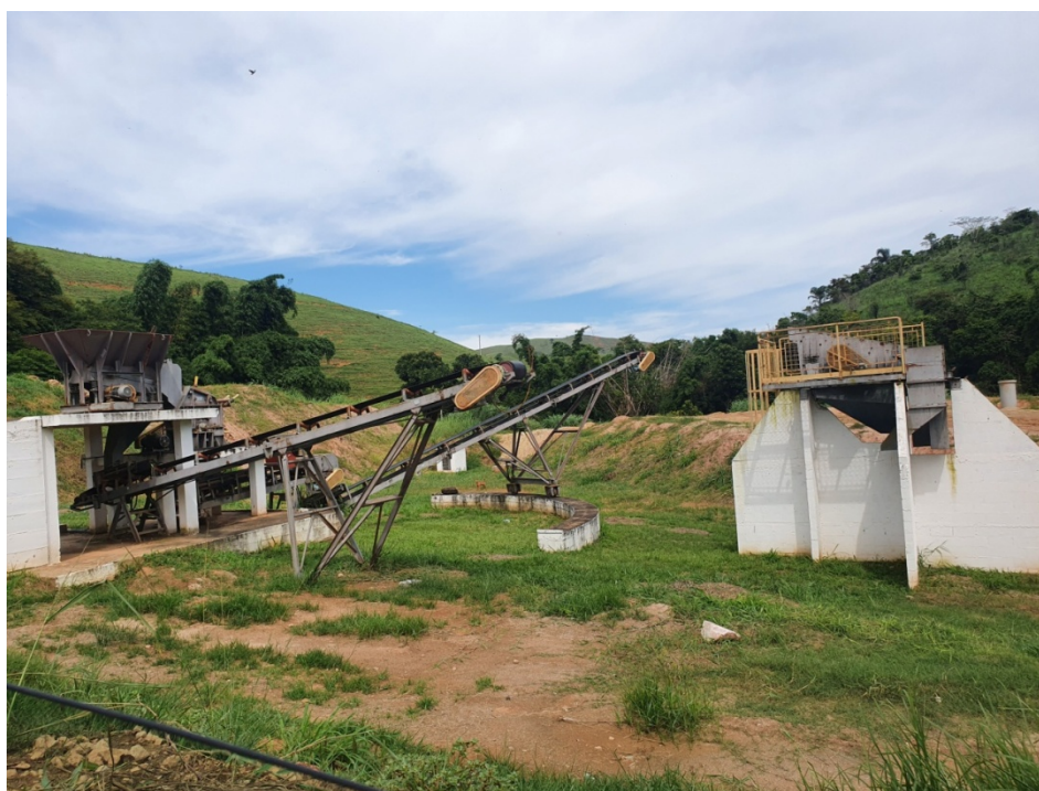
Figura 14: Britador de resíduos da construção civil inoperante.
