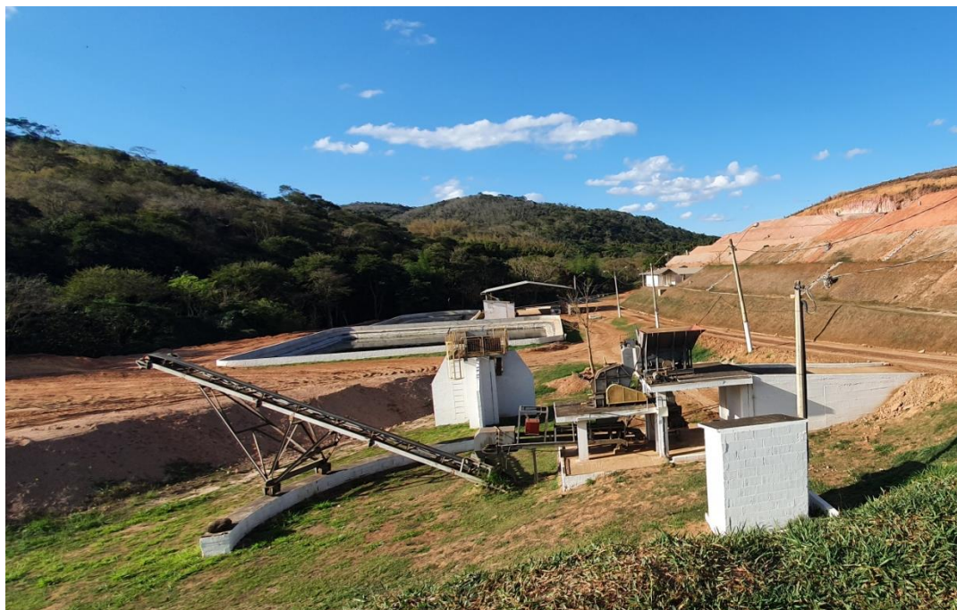
Figura 14: Área de RCC
