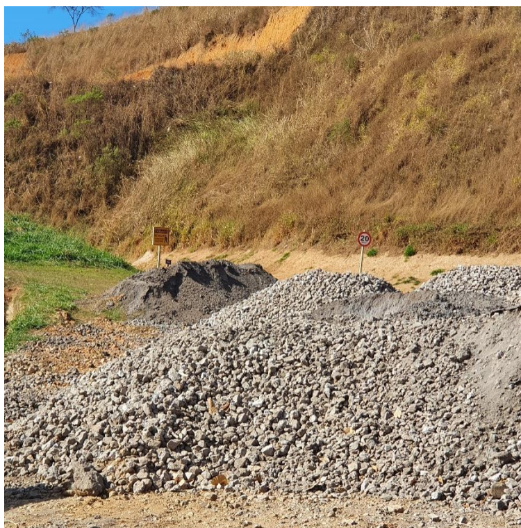
Figura 4: Material (escória de alto forno) utilizado na mistura para nivelamento da estrada de passagem veicular
