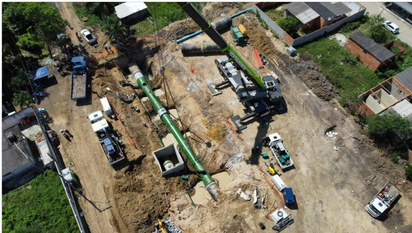
Foto 13 – Instalação do macro medidor do ponto da Ilha Guandu finalizada
