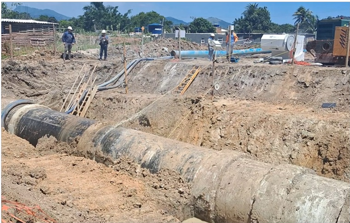
Foto 5 - Realização da etapa de corte da tubulação com fio diamantado
