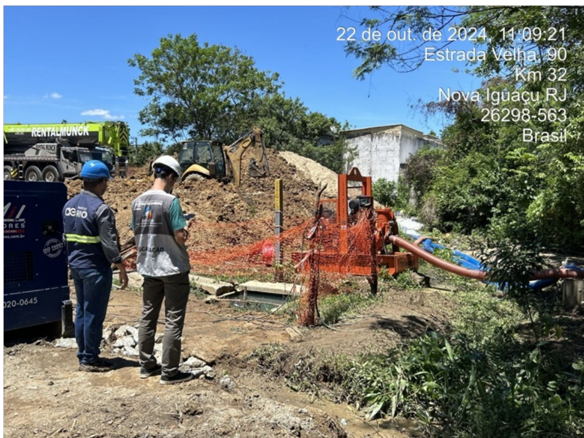
Foto 2 - Esgotamento da tubulação sendo realizado
