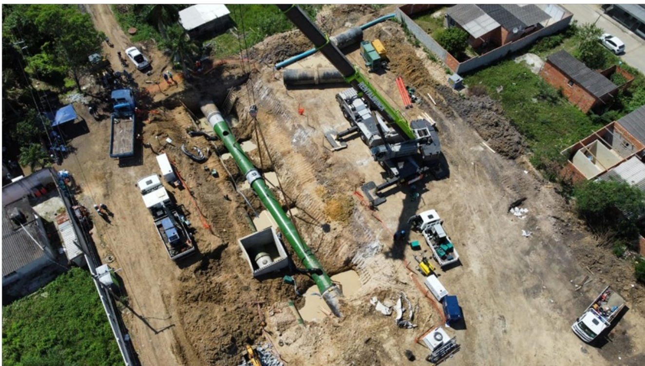
Foto 14 - Trabalhos sendo finalizados no Km 32 – Nova Iguaçu
