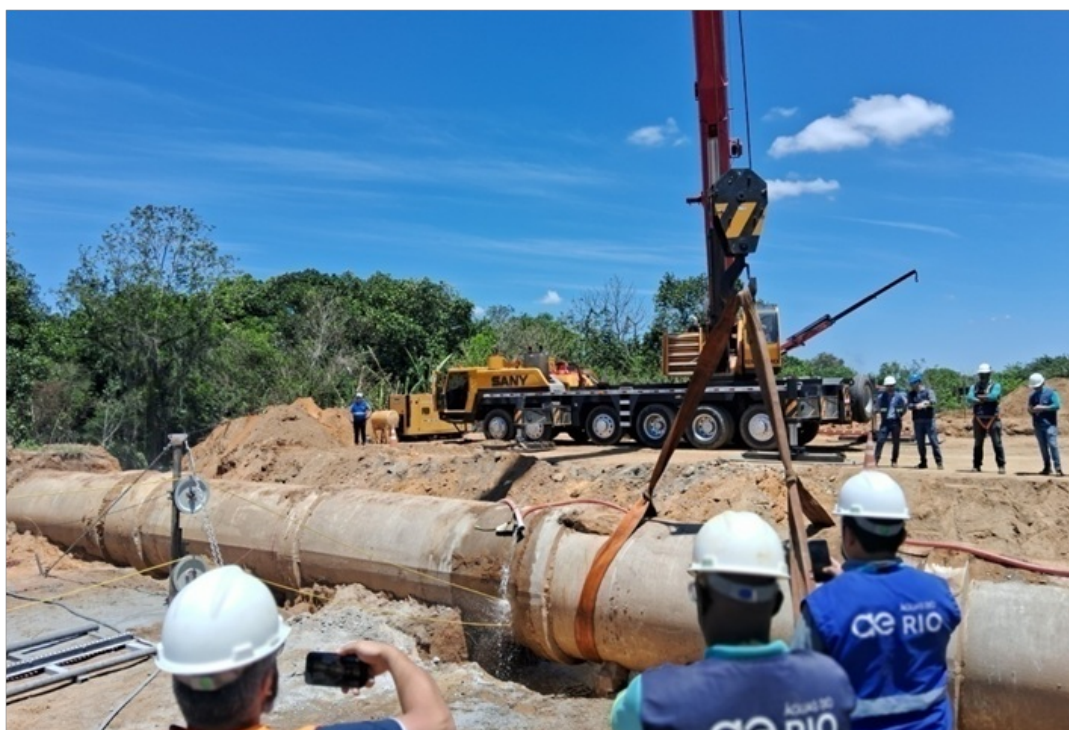
Foto 8 - Etapa de corte da tubulação com fio diamantado
