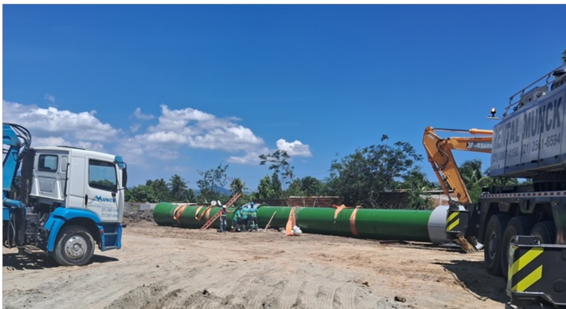
Foto 4 - Realização da montagem do conjunto tubo-medidor
