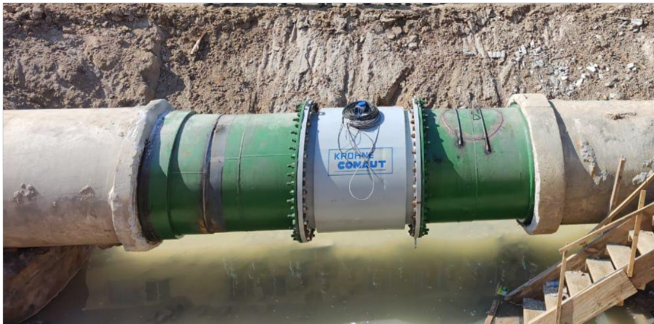
Foto 12 – Instalação do macro medidor do ponto de Guadalupe finalizada
