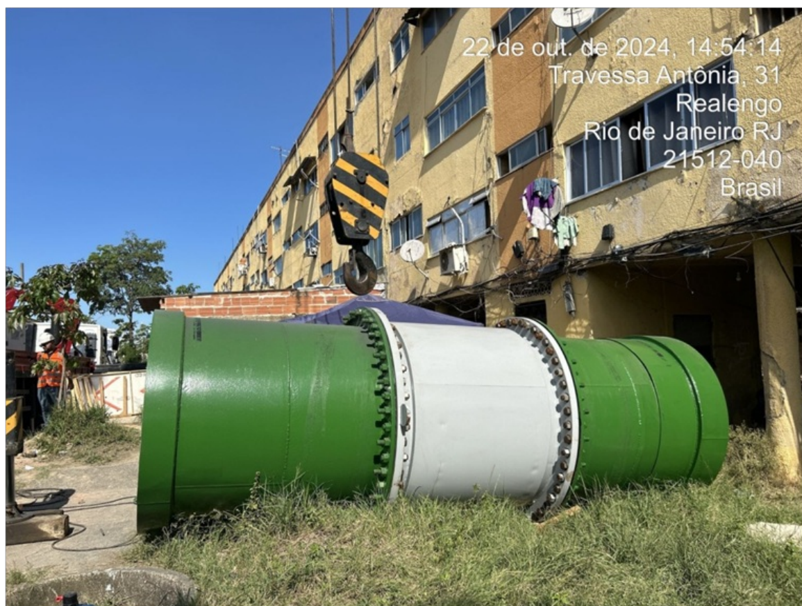
Foto 11 – Macro medidor de 1500 mm já conectado à tubulação
