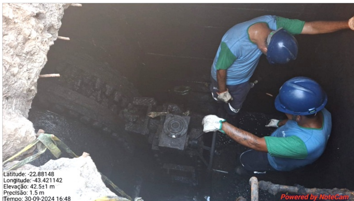
Foto 6 – Equipe concessionária realizando fechamento manual em válvula de grande porte
