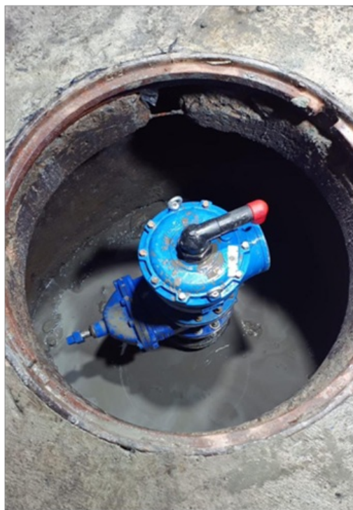
Foto 8 – Ventosa e registro novos, pós reparo
