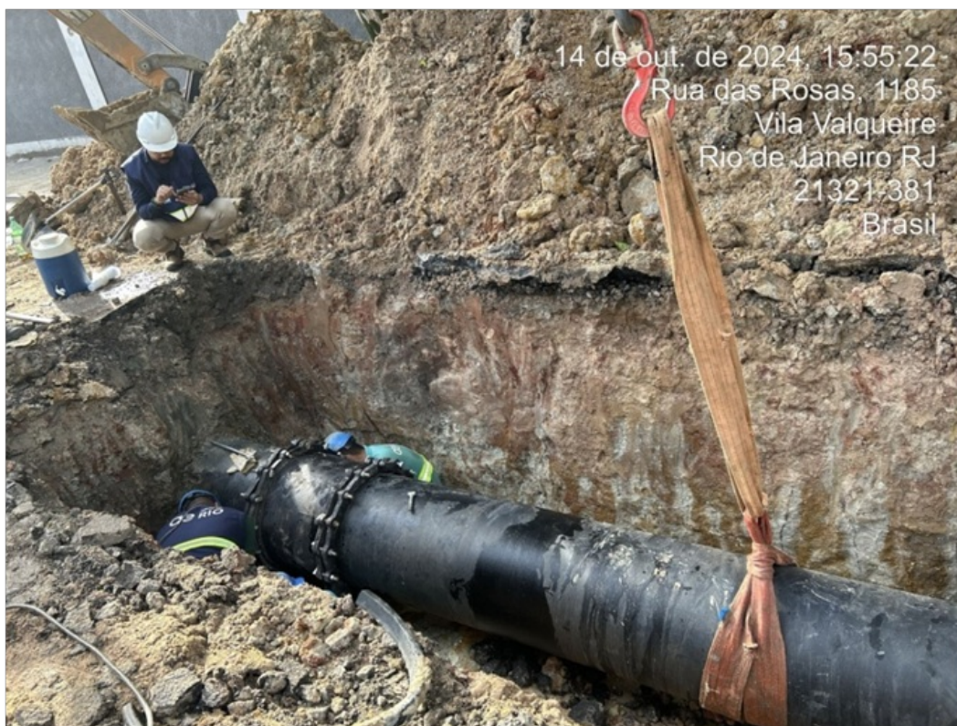
Foto 7 – Conexão da junta mecânica da tubulação sendo finalizada
