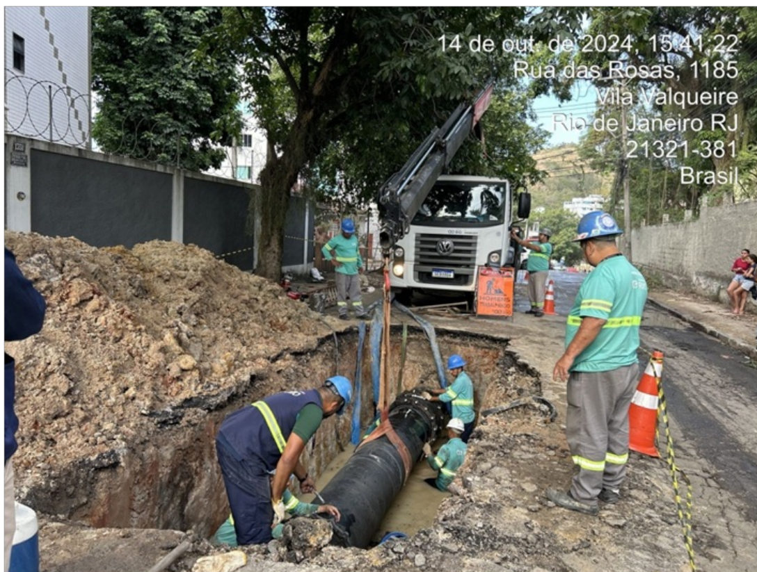
Foto 6 – Tubulação nova sendo acoplada na rede
