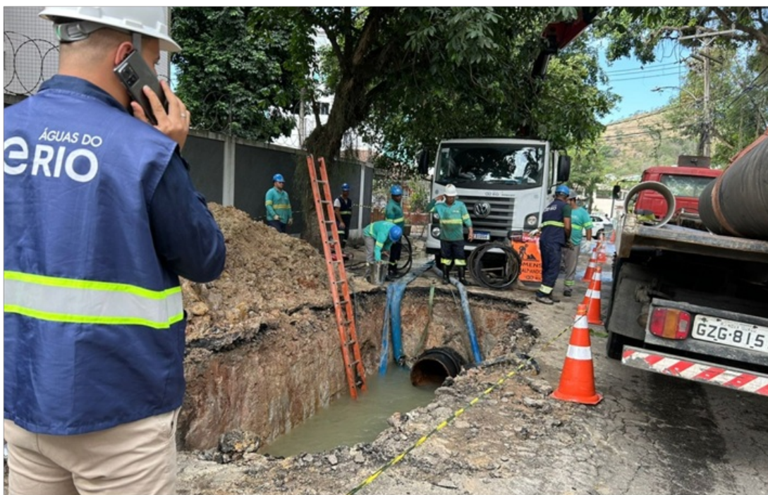
Foto 2 – Local da obra após retirada da tubulação com vazamento
