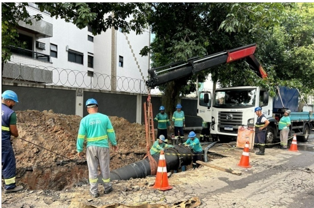
Foto 5 – Tubulação nova sendo inserida no local
