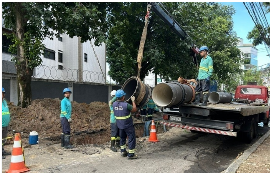
Foto 4 – Inserção de junta mecânica na nova tubulação
