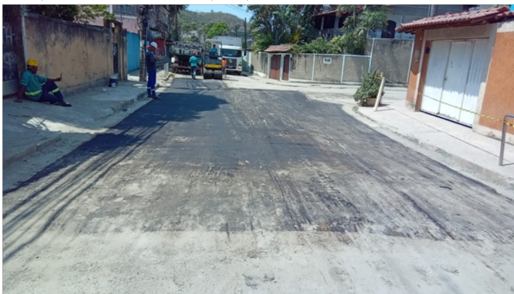
Foto 12 – Início do asfaltamento
