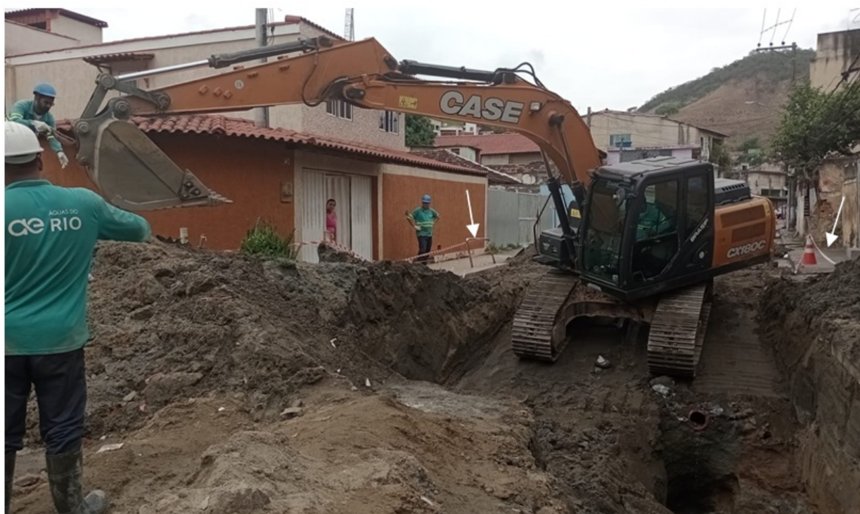
Foto 2 – Isolamento da área de trabalho
