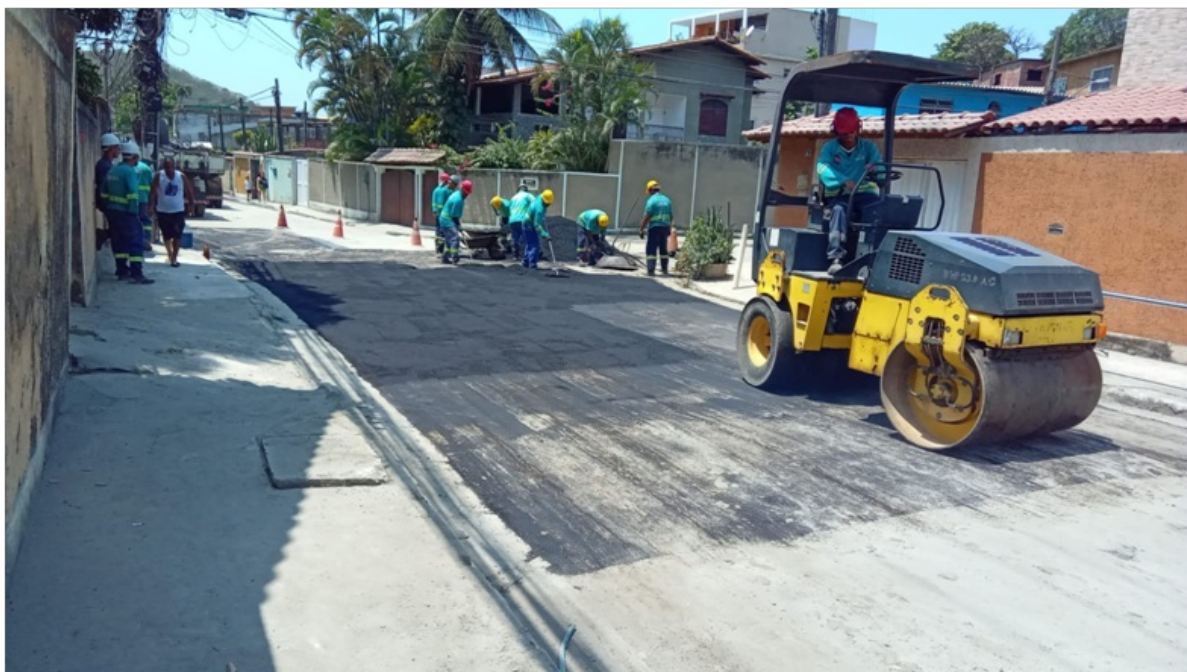
Foto 13 – Asfaltamento em andamento
