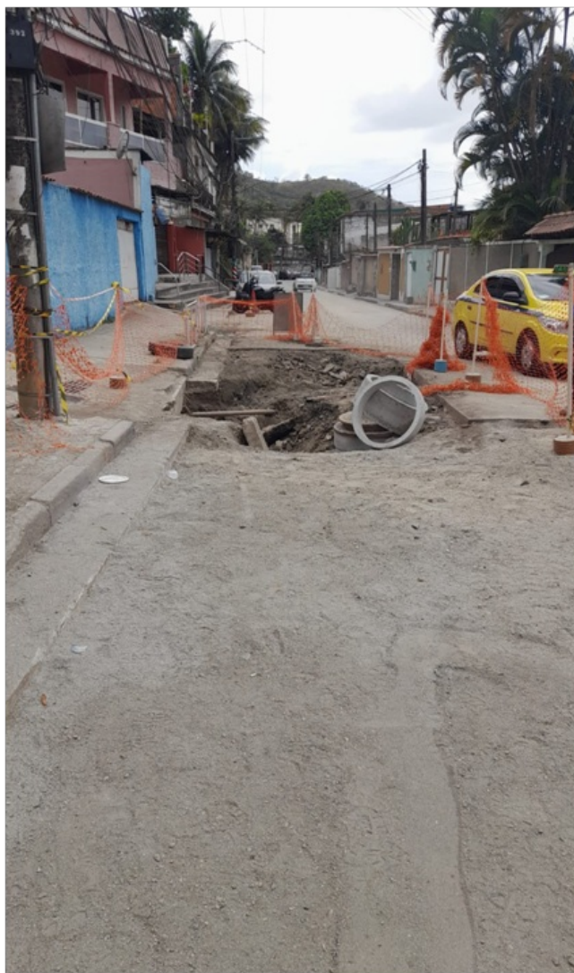
Foto 11 – Reaterro parcialmente executado
