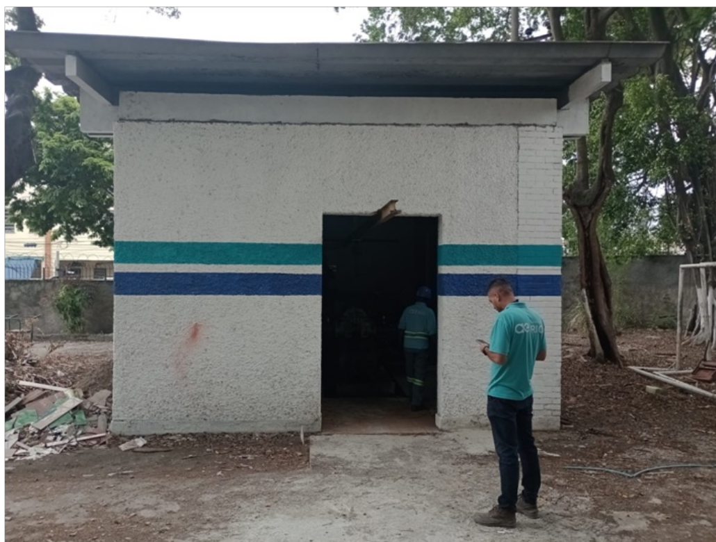
Foto 2 – Vista frontal do abrigo da elevatória
