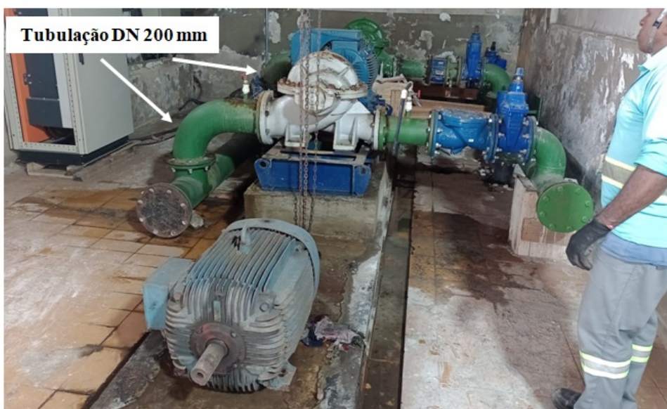
Foto 8 – Tubulação de retaguarda já reduzida
