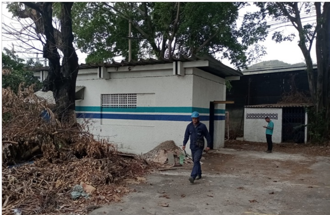
Foto 1 – Vista lateral do abrigo da elevatória
