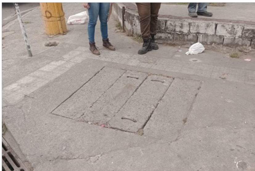
Foto 2 – Tampa de concreto do abrigo
