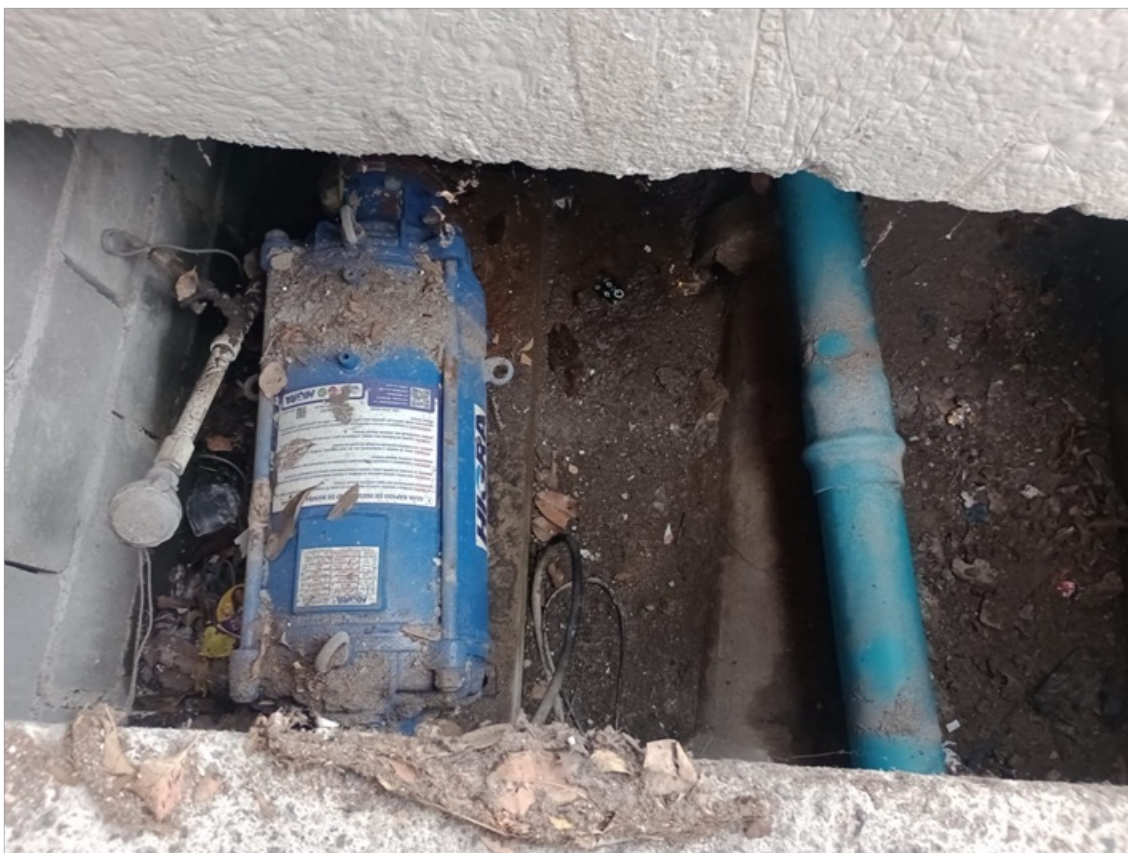
Foto 3 – Conjunto motobomba do tipo anfíbia
