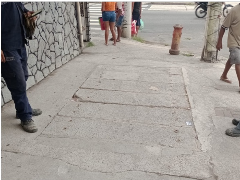
Foto 2 – Tampa de concreto do abrigo
