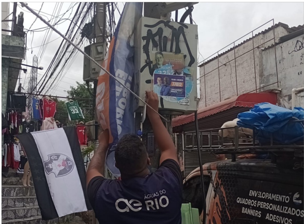
Foto 4 – Pannel de automação sem sinalização de risco de choque elétrico
