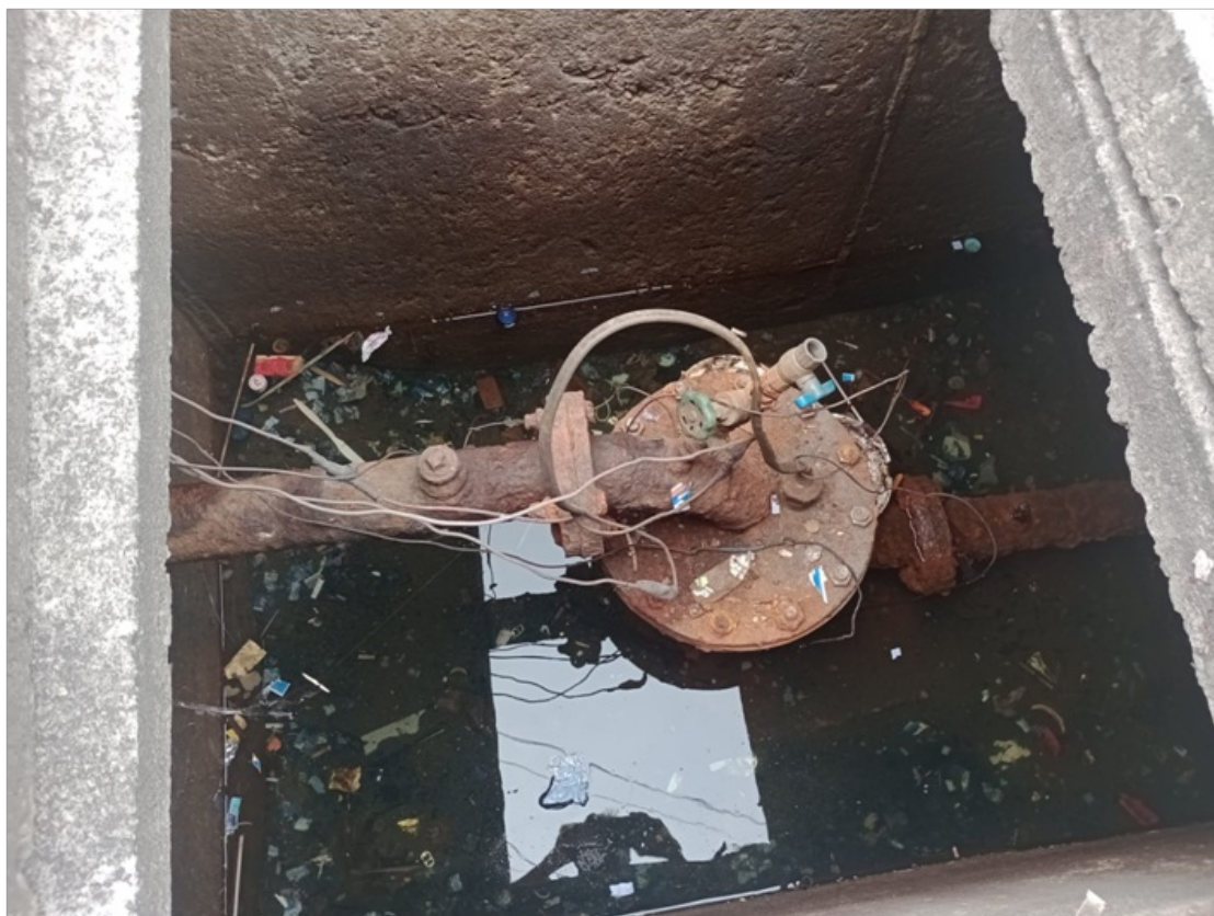
Foto 2 – Interior do abrigo subterrâneo com acúmulo de água e visualização da jaqueta da motobomba
