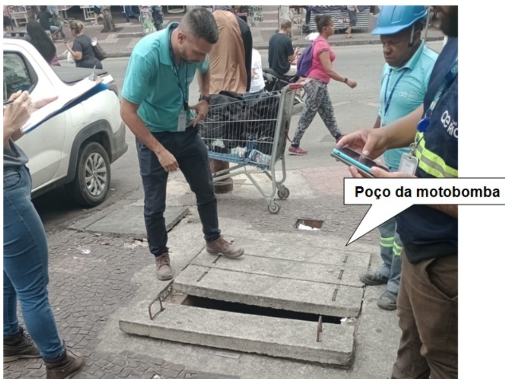
Foto 1– Tampa de concreto do abrigo
