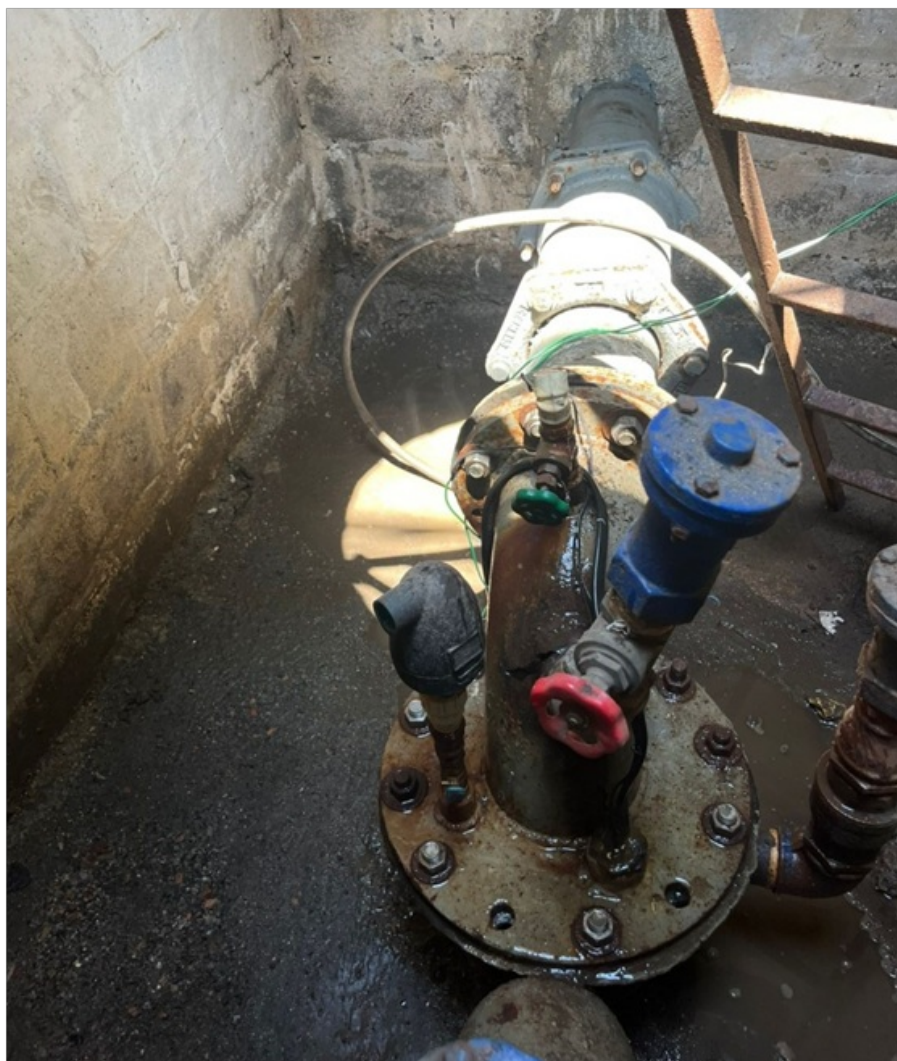
Foto 2 – Jaqueta da motobomba submersa
