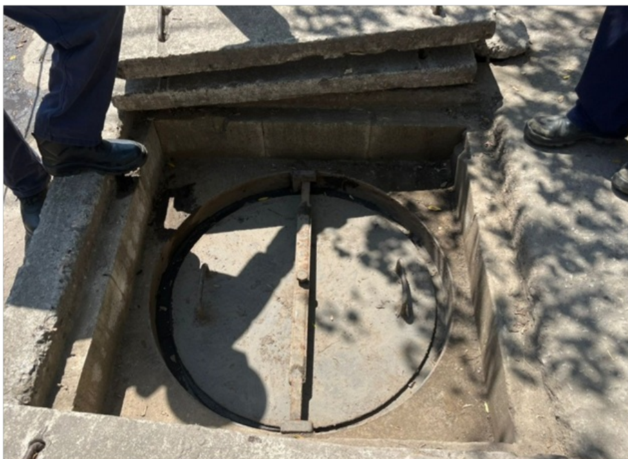
Foto 3 – Tampa de aço do panelão vedada
