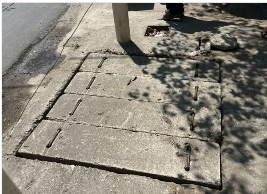
Foto 2 – Tampa de concreto
