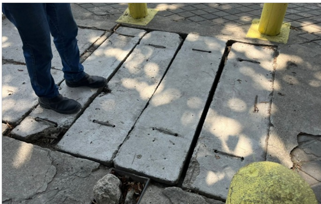
Foto 2 – Tampa de concreto
