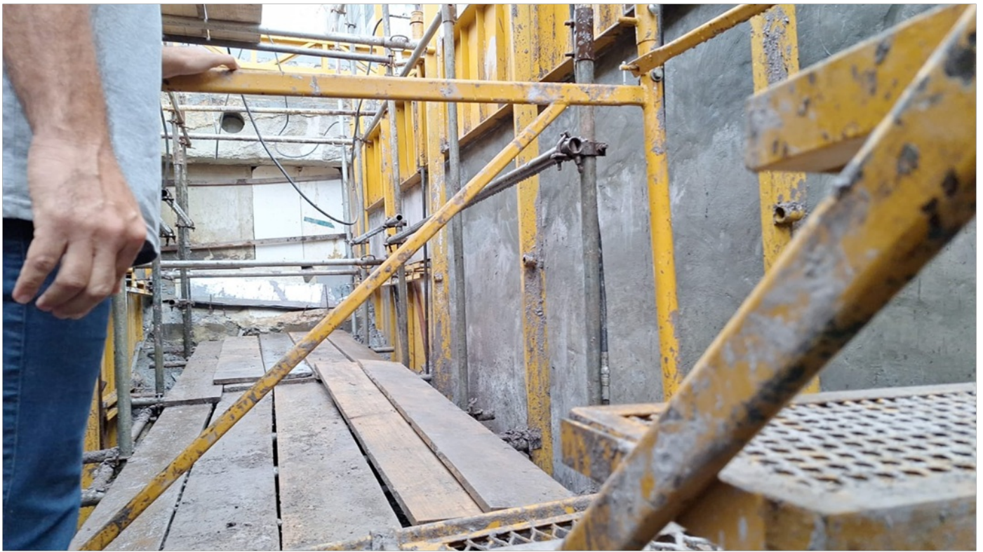
Foto 4 – Vista das paredes concretadas
