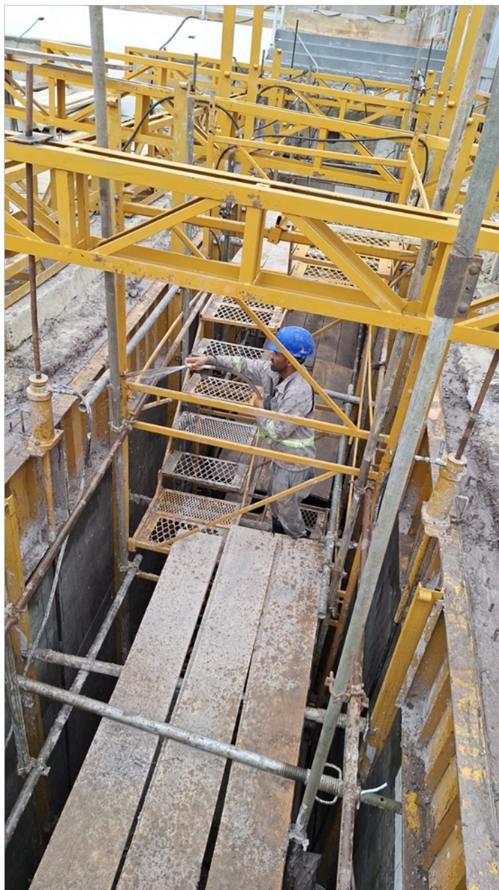
Foto 3 – Vista do poço 4 após concretagem, sendo molhado para cura
