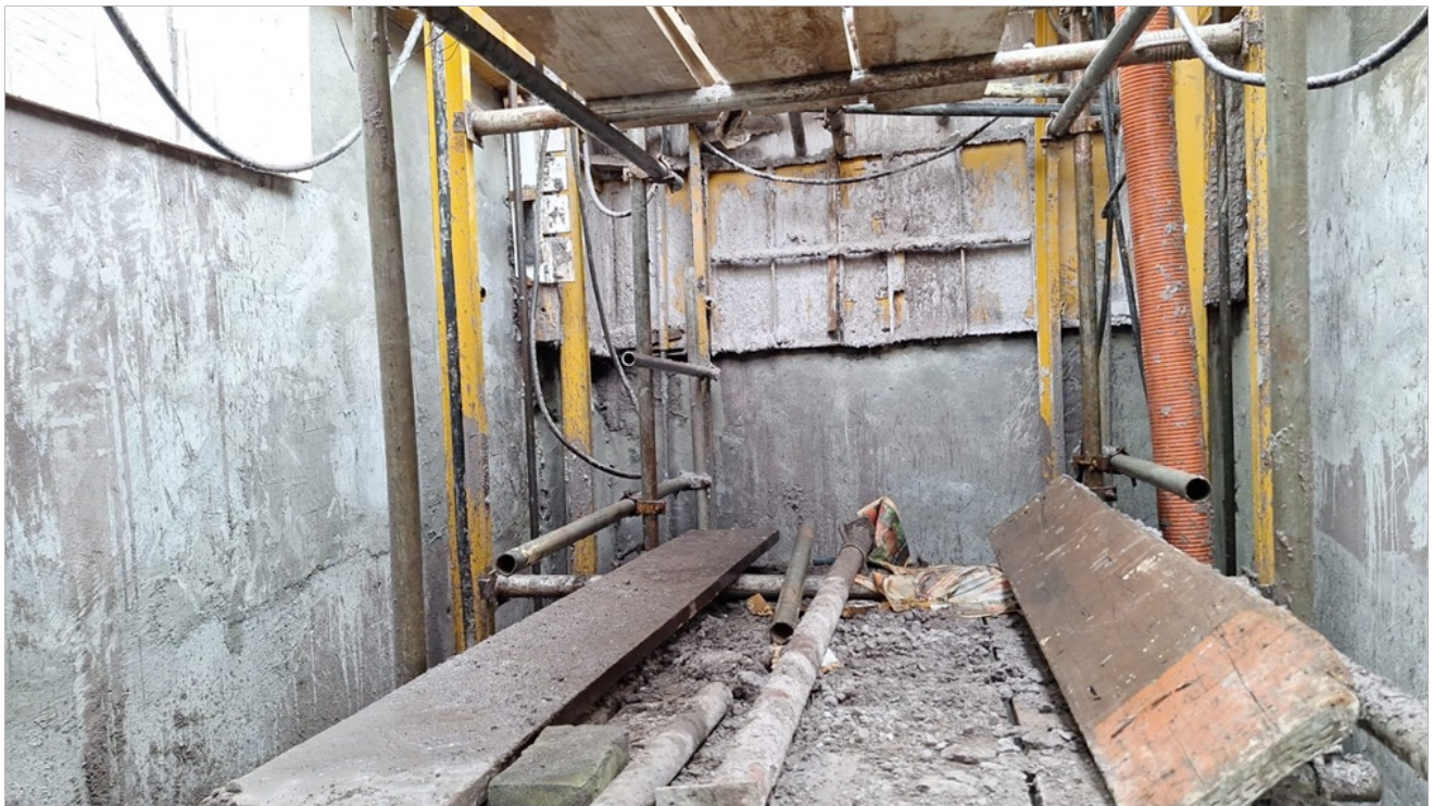
Foto 5– Vista das paredes concretadas
