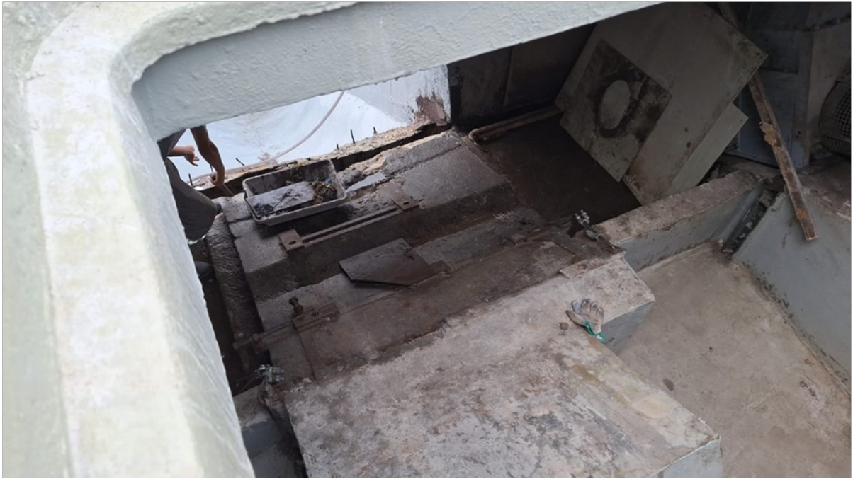
Fotos 6 – Reparo da base do acoplamento do parafuso; Vista da impermeabilização do poço após a concretagem, com drenagem do esgoto vazado pelas comportas, através de bomba sapo .
