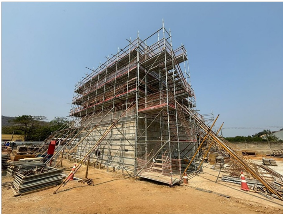
Foto 06 – ETE - obra do UASB (Upflow Anaerobic Sludge Blanket), reator de alta eficiência para tratamento de esgoto, em andamento.
