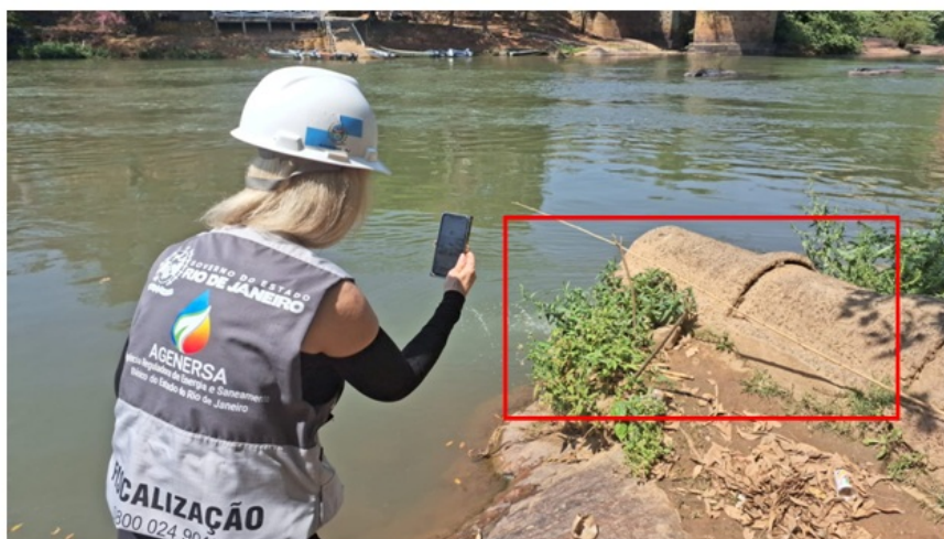
Foto 03 – Lançamento de esgoto in natura, no Rio Paraíba do Sul.
