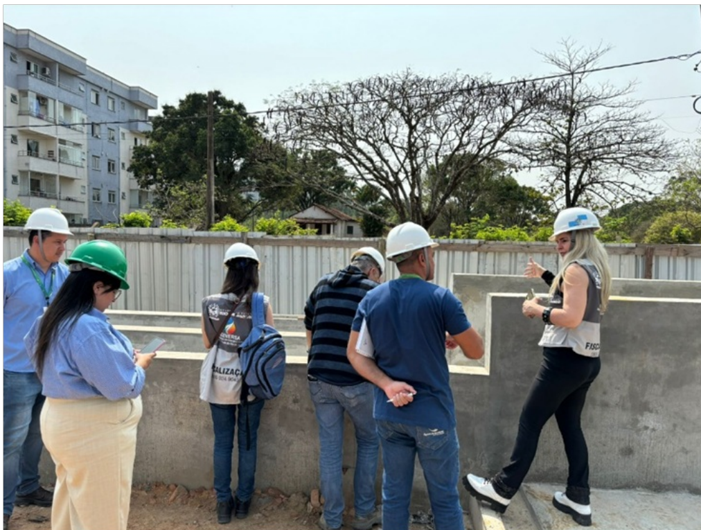
Foto 05 – Obra da etapa de Tratamento Preliminar de esgoto da ETE, encontra-se em fase bem adiantada..
