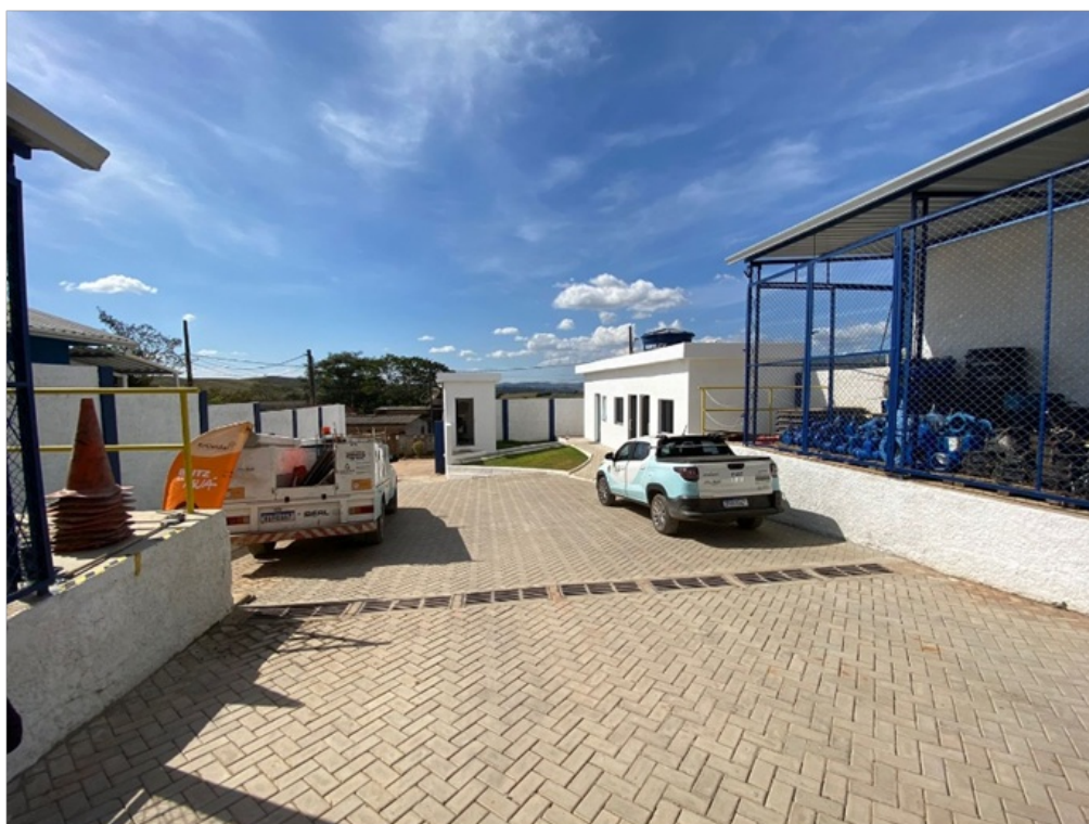
Foto4 - Pátio Operacional, terreno do Reservatório
