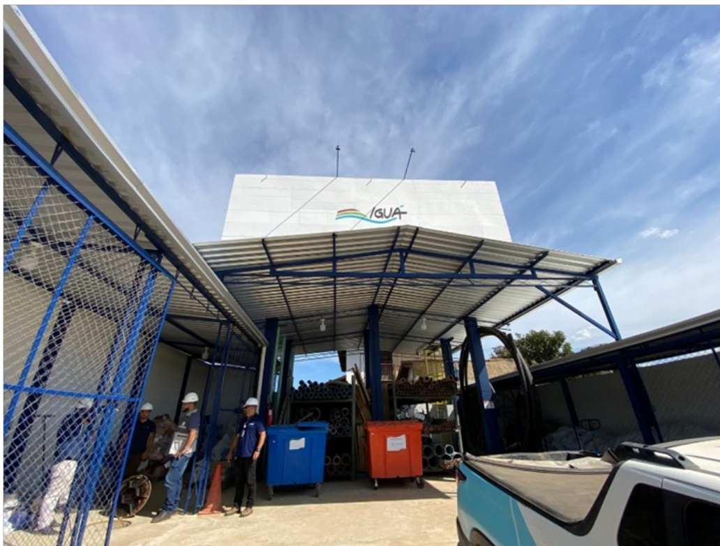
Foto 5 - Pátio Operacional, terreno do Reservatório
