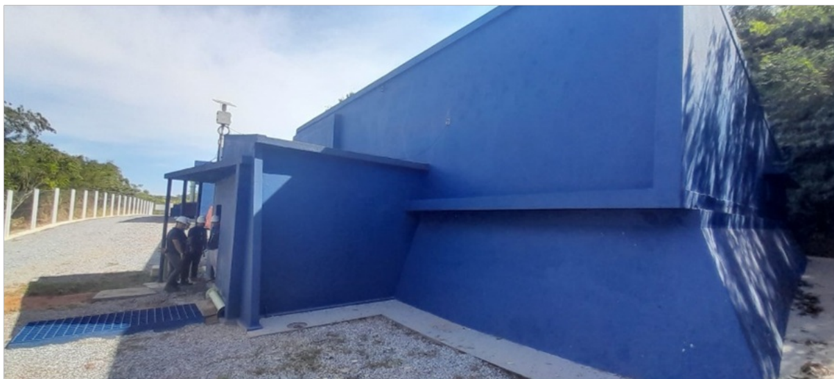
Foto3 - Externo Reservatório Central 2
