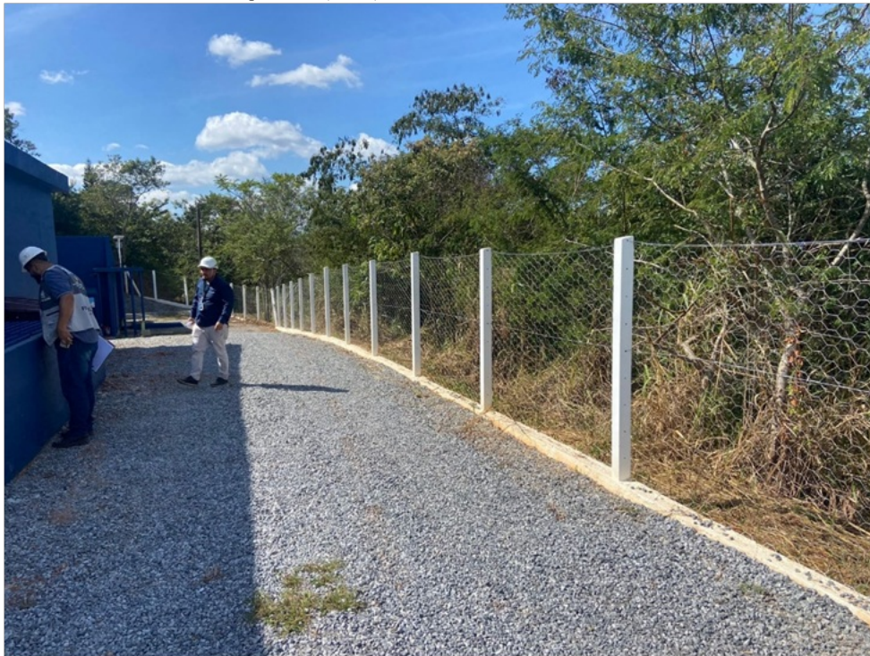
Foto 2- Cercas do reservatório
