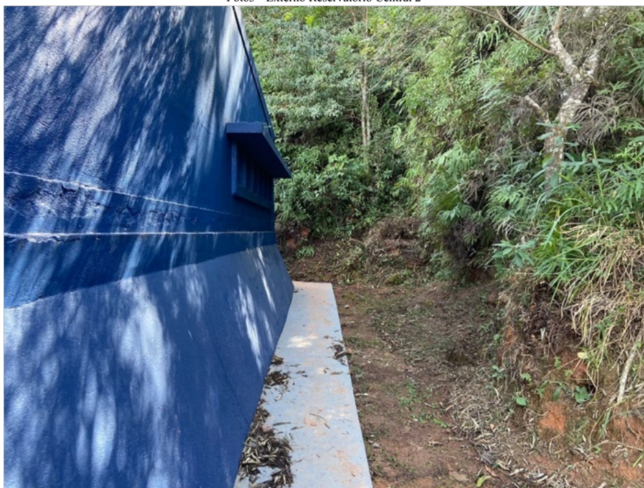
Foto 4 - Externo Reservatório Central 2
