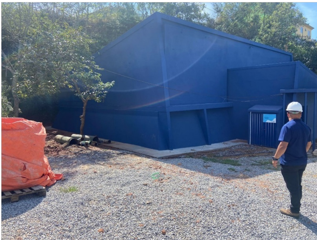
Foto 5 - Externo Reservatório Central 2
