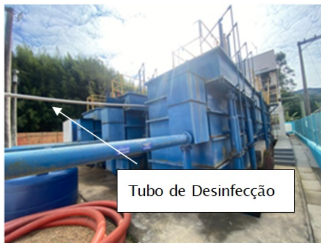
Foto 11 - Tubo de Desinfecção direto a câmara de contato/Reservatório
