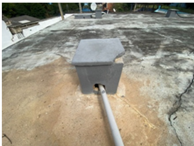
Foto 11 - Tubo de Desinfecção direto a câmara de contato/Reservatório
