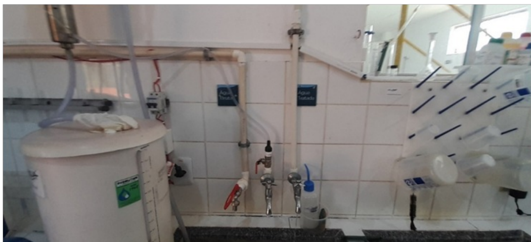
Foto 13 Ponto de Coleta Água Tratada e Bruta
