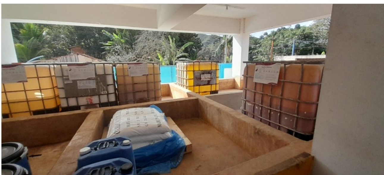
Foto 25 Área de Armazenamento de Produtos Químicos
