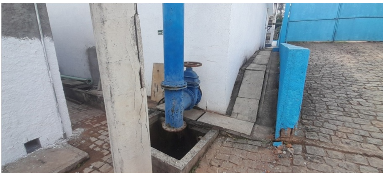
Foto 26 Extravaseiro do Reservatório
