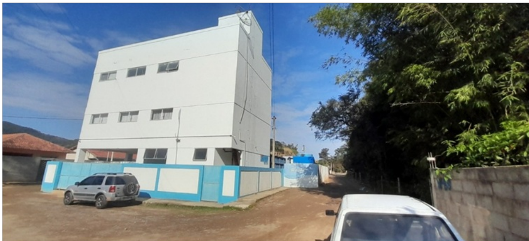
Foto 1 Estação de Tratamento de Água Fragoso
