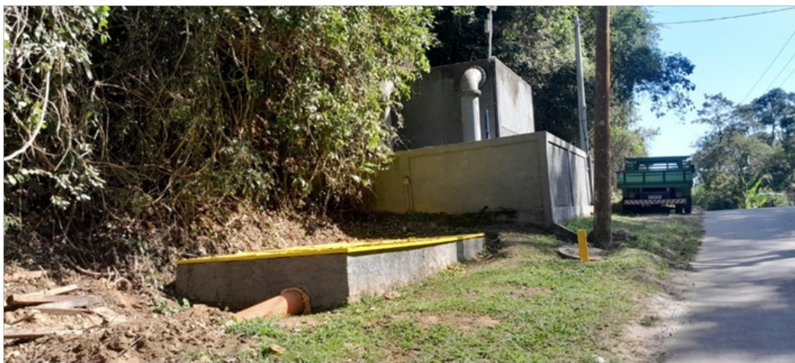
Foto 2 – Caixa de passagem
