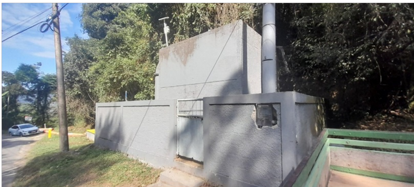
Foto1 - Entrada do reservatório
