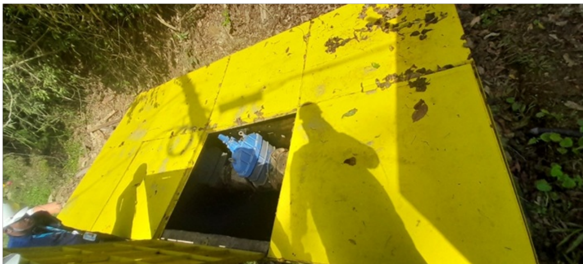
Foto 4 – guarda da tubulação de chegada
