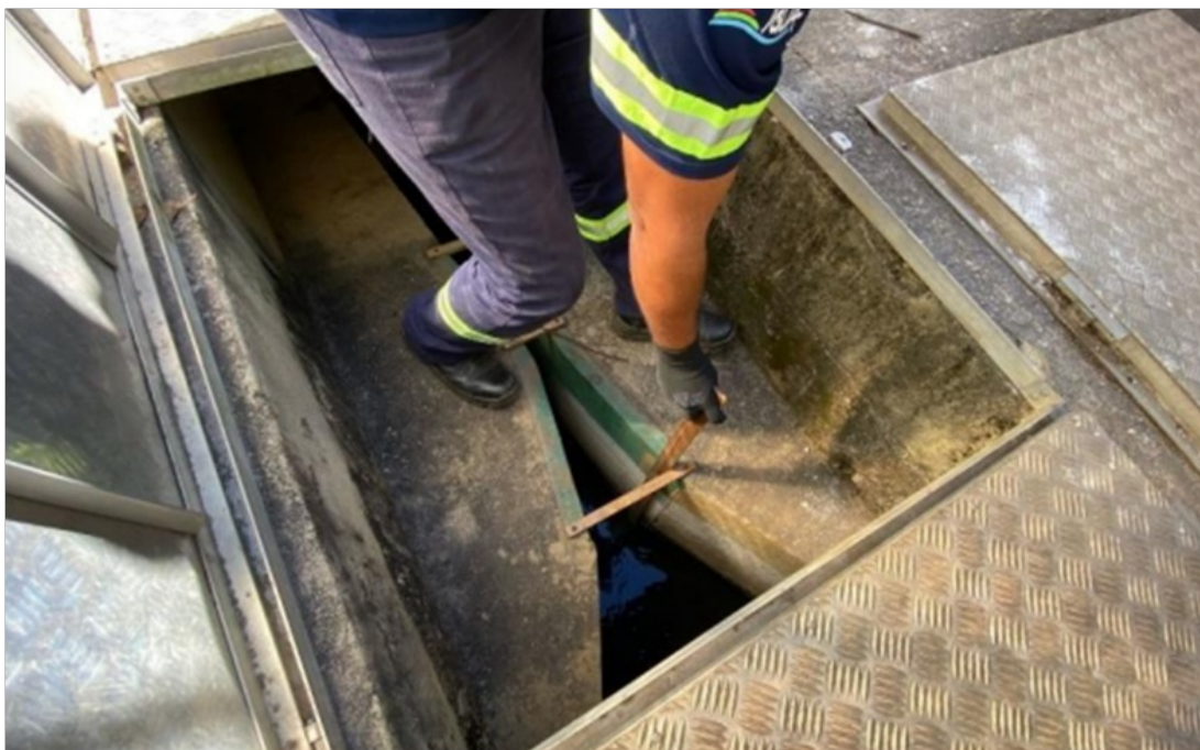
Foto 7 – Régua graduada na Calha Parshall
