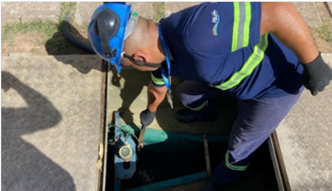
Foto 17 – Operador medindo a vazão de esgoto
