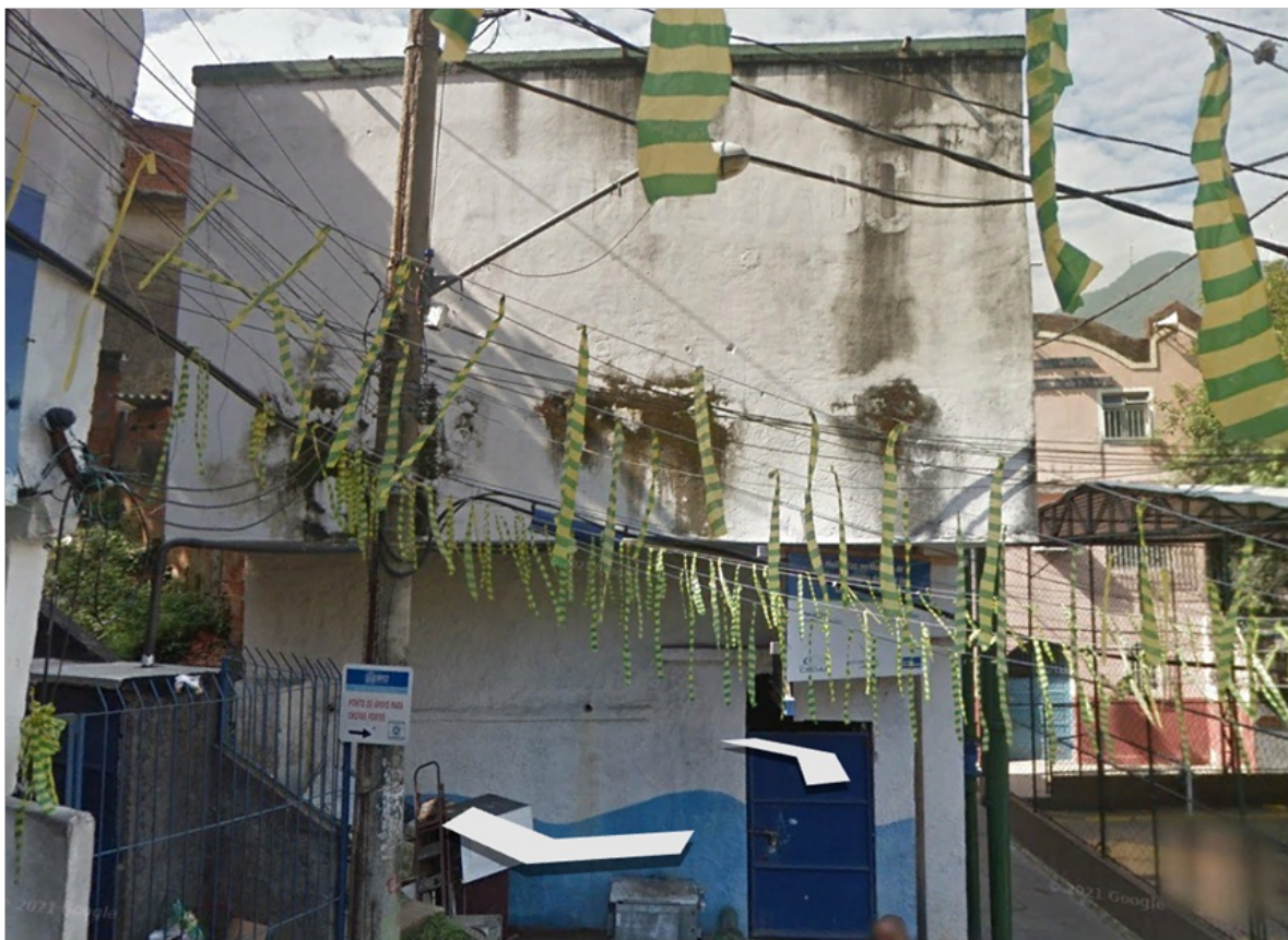
Foto 2 – Parte inferior do reservatório (fonte Google Earth)
