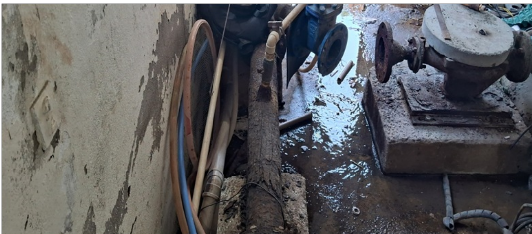
Foto 12 – Tubulação deteriorada
