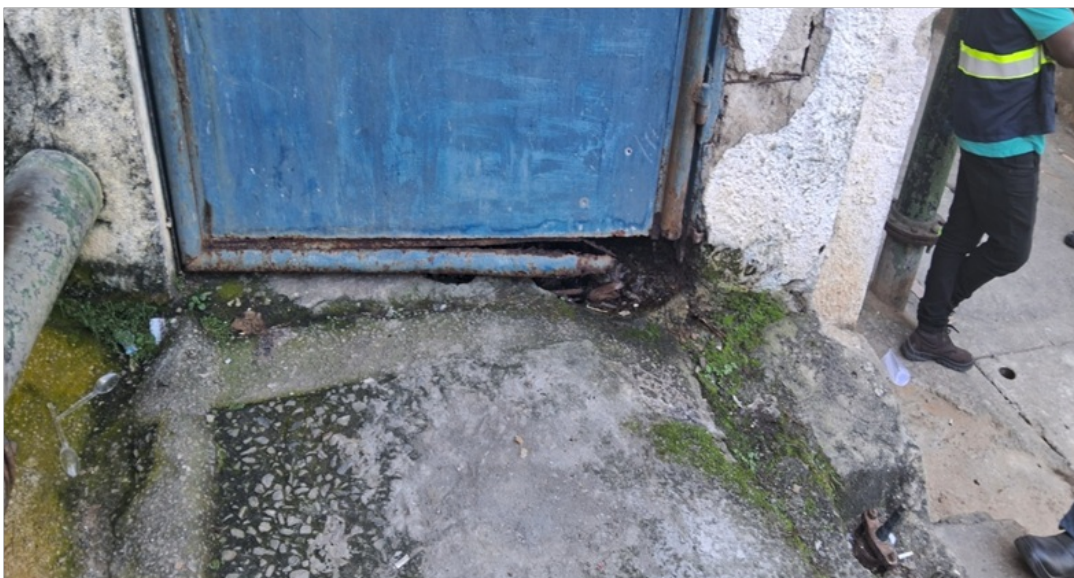
Foto 16 – Porta do abrigo das elevatórias
