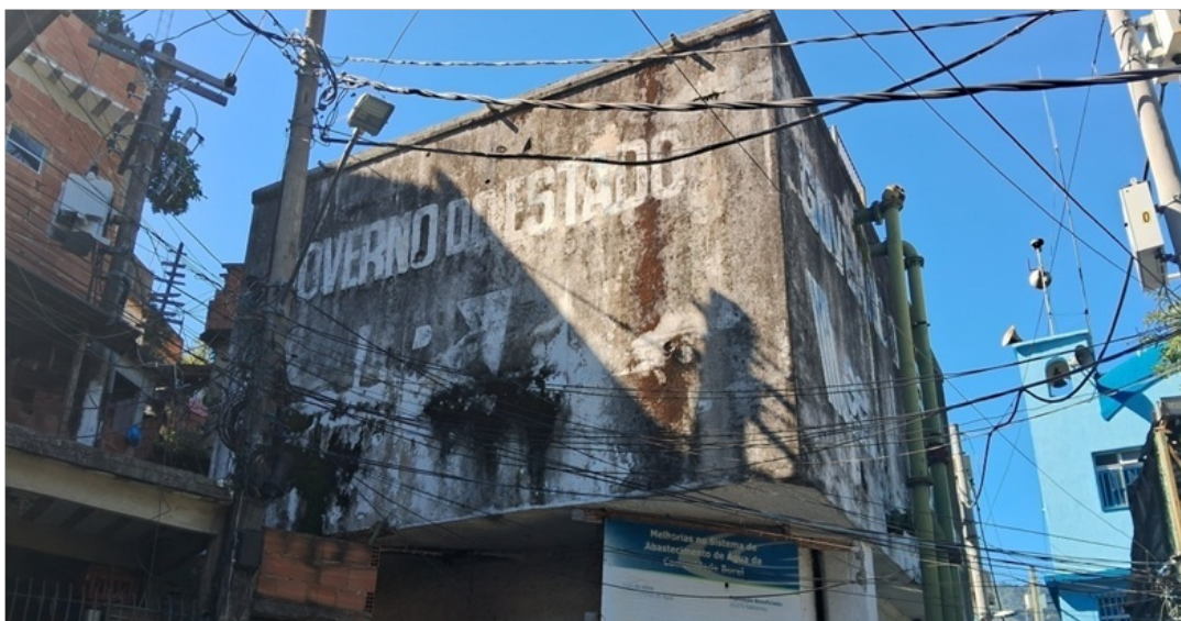
Foto 1 – Vista do reservatório
