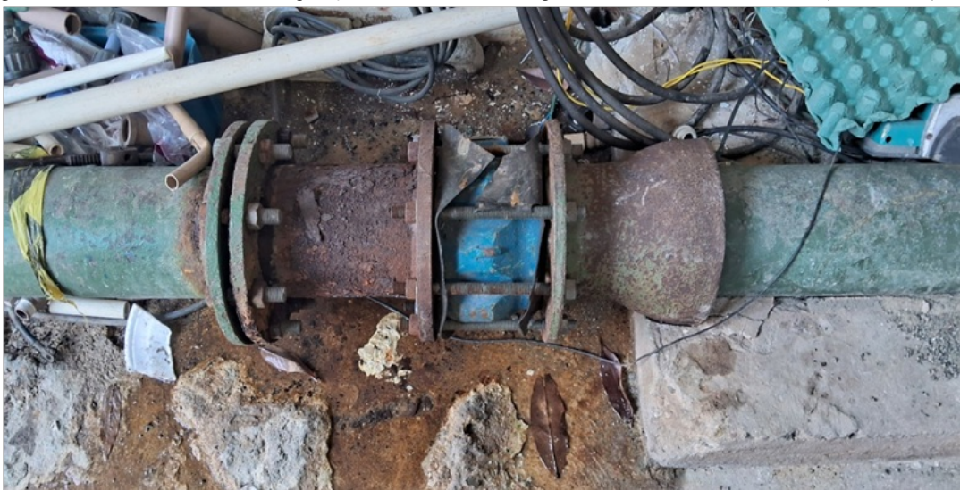
Foto 17 – Lixo no interior do abrigo
