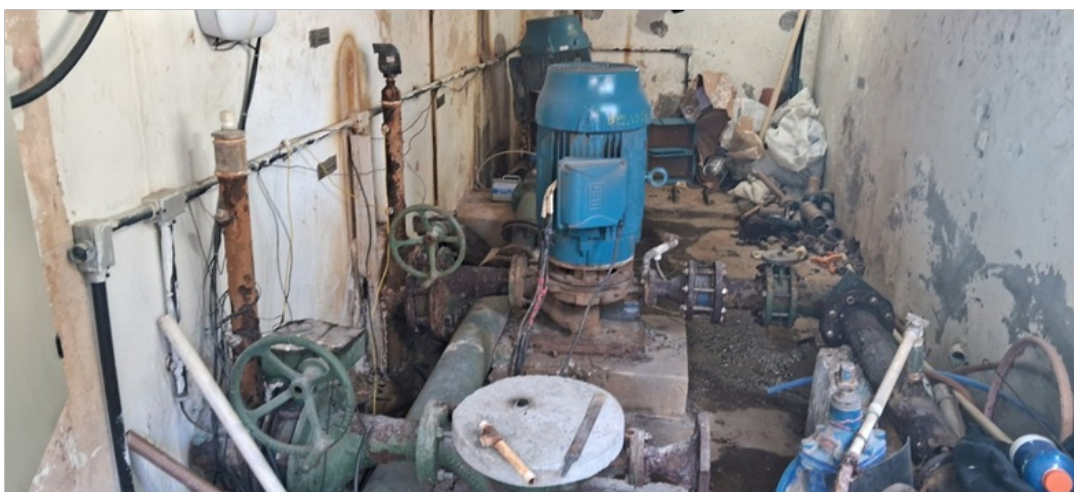
Foto 21 – Fiação desprotegida
