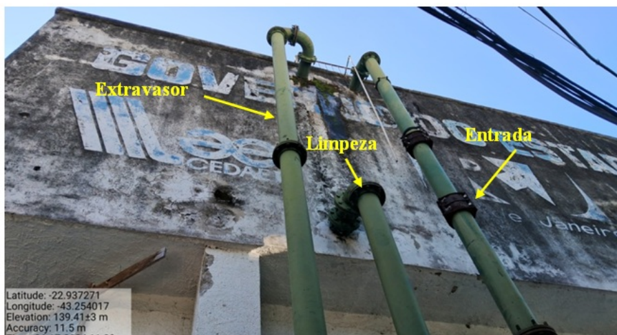
Foto 5 – Tubulações de entrada, extravasora, e de limpeza
