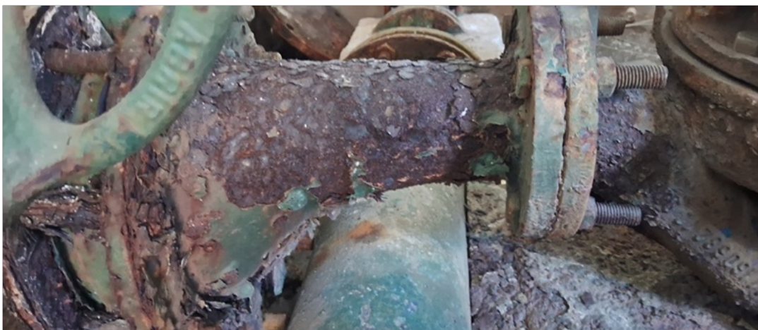
Foto 13 – Redução deteriorada
