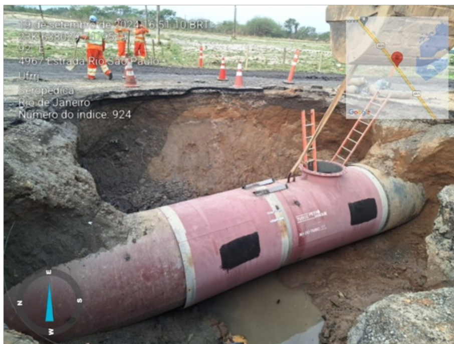
Foto 5 - Tubo telescópico já encaixado no local
