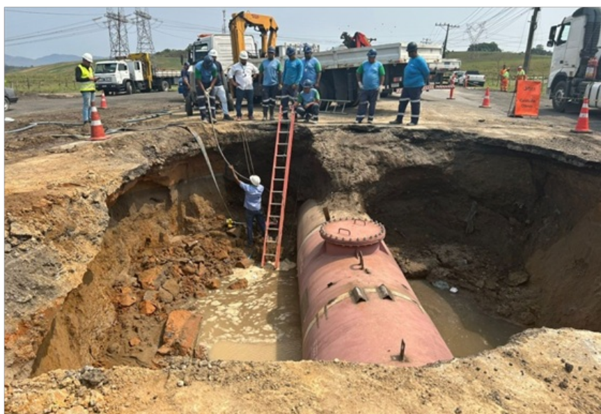
Foto 8 - Trabalho de bombeamento da água presente no local
