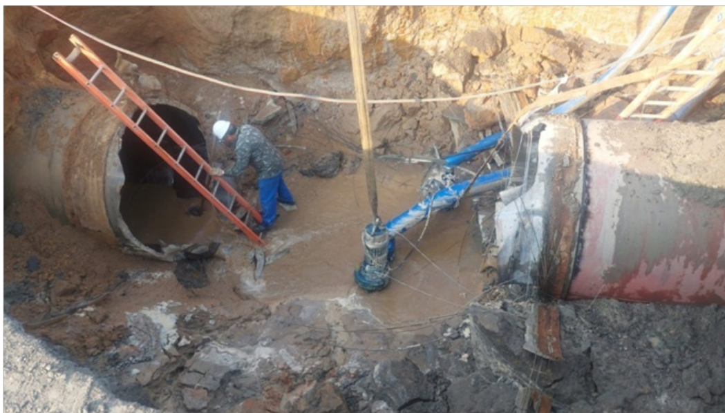
Foto 3 – Remoção do trecho a ser substituído
