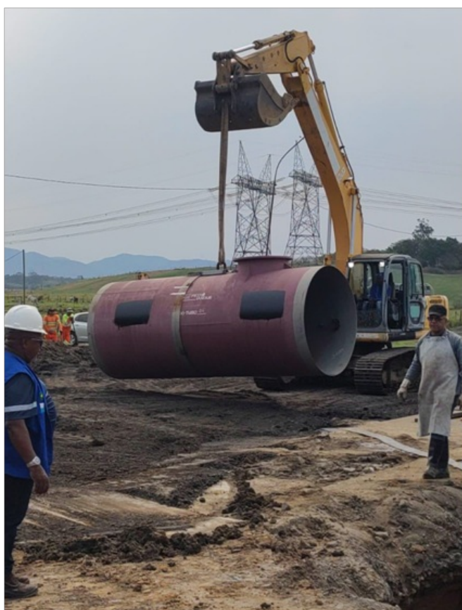
Foto 4 - Tubo telescopado sendo içado para a inserção no local
