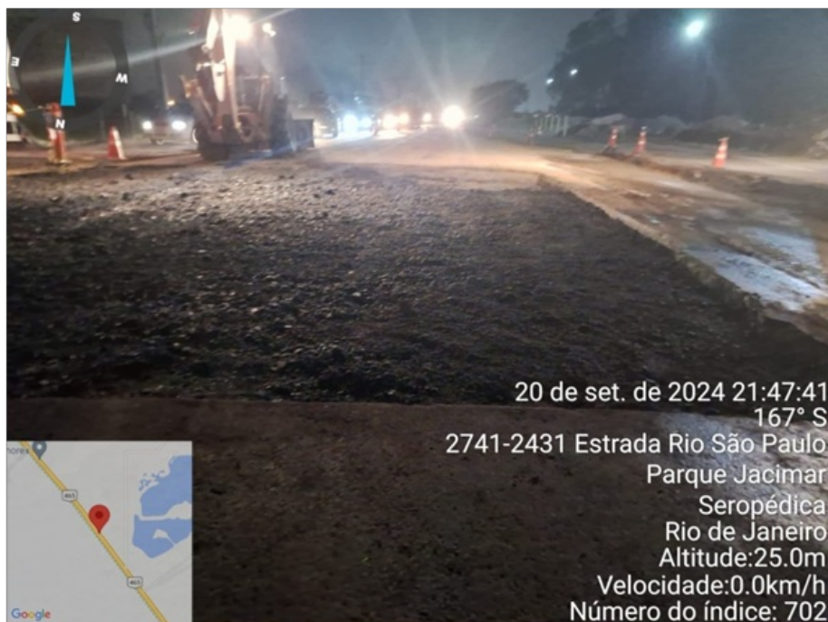
Foto 10 – Finalização do trabalho de pavimentação do local.
