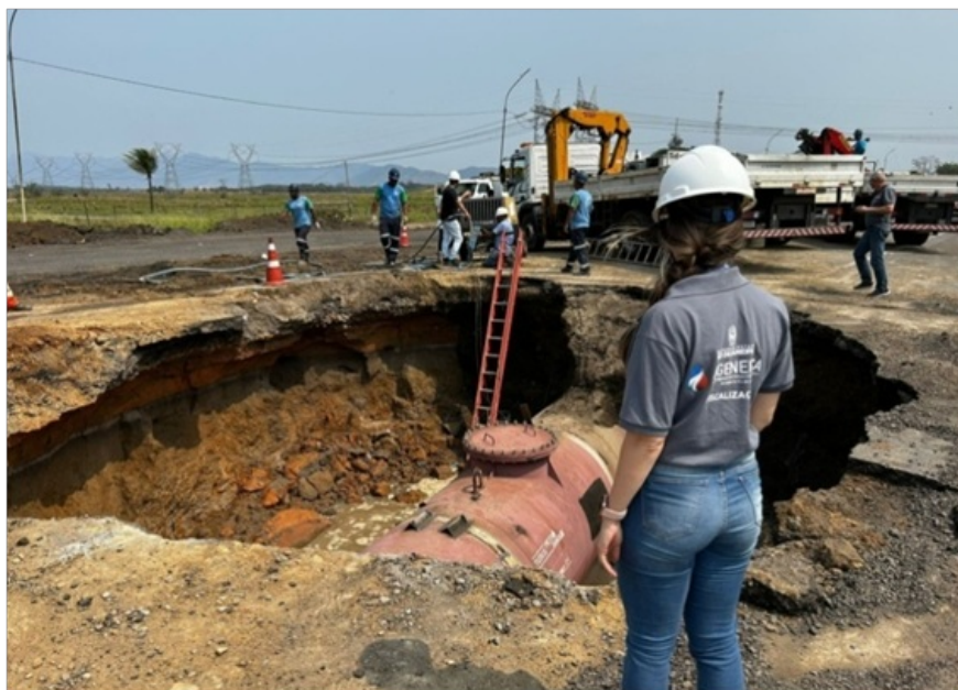
Foto 7 - Representantes da equipe da CASAN fiscalizando as obras do local
