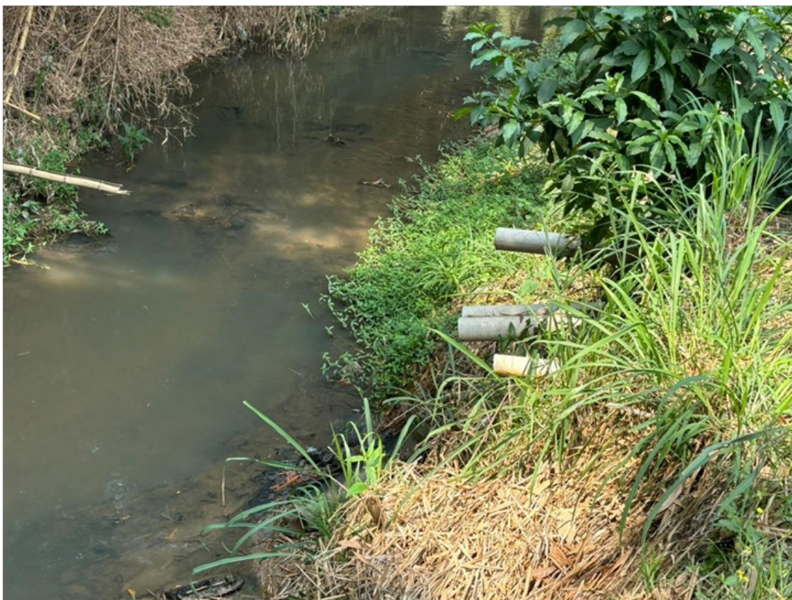
Foto 05 – Outro ponto onde ocorre lançamento de esgoto in natura no Córrego do Lucas.
