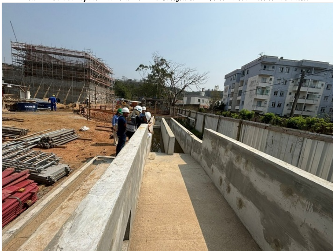
Foto 08 – Obra do UASB (UpflowAnaerobicSludgeBlanket), Reator de alta eficiência para tratamento de esgoto, encontra-se em andamento.
