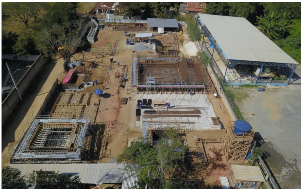
Foto 06 –Visita a construção da ETE – Paraíba do Sul, cuja obra foi iniciada em dezembro/2023,
