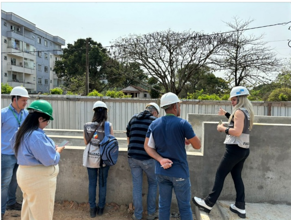
Foto 07 – Obra da Etapa de Tratamento Preliminar de esgoto da ETE, encontra-se em fase bem adiantada..
