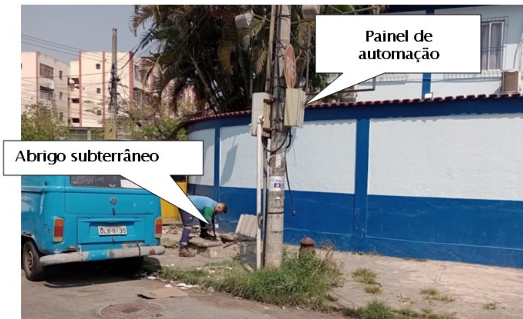
Foto 2 – Localização da EEAT São Cristiano
