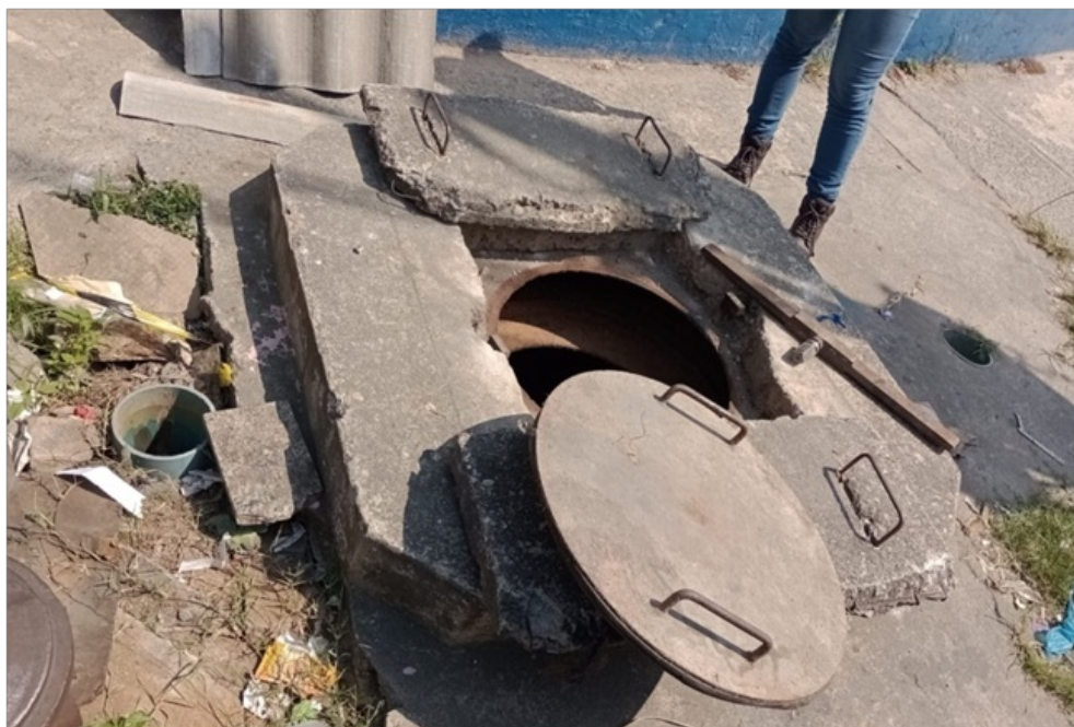
Foto 3 – Abertura do abrigo subterrâneo
