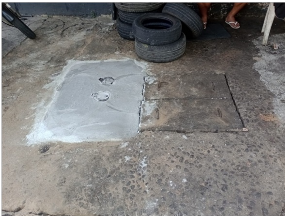
Foto 2 – Tapa de concreto do abrigo subterrâneo
