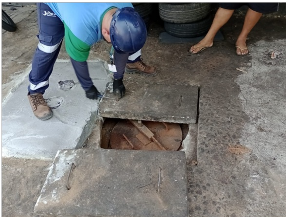
Foto 3 – Abrigo subterrâneo sendo aberto
