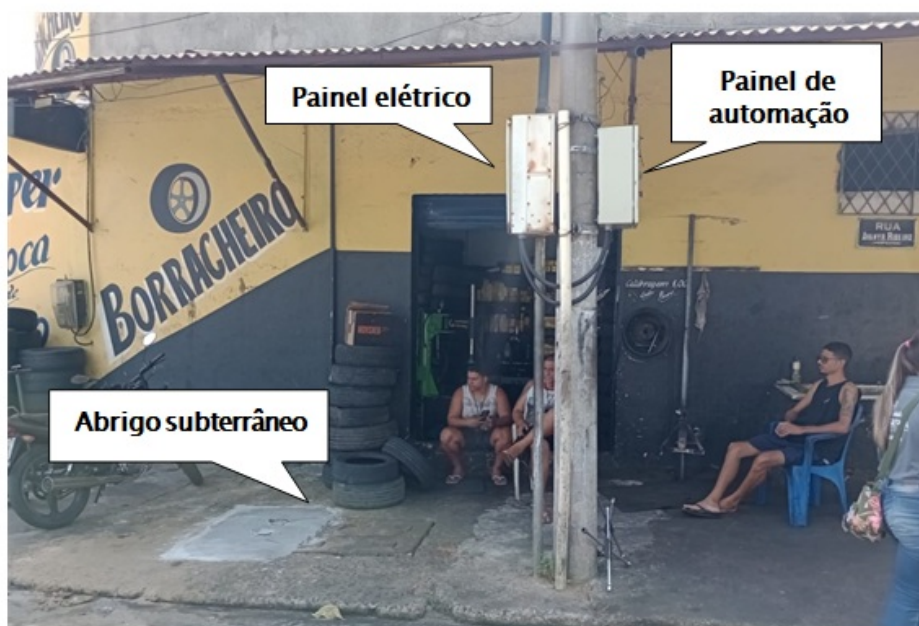
Foto 1 – Localização da EEAT
