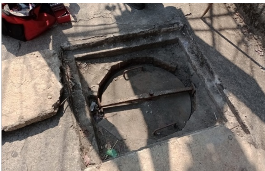
Foto 3 – Tampa de aço do “panelão” vedada
