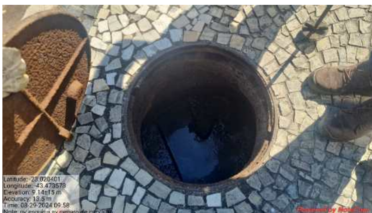
Fig. 5. - Poço de Visita de rede coletora DN150 da Av. Genaro de Carvalho
