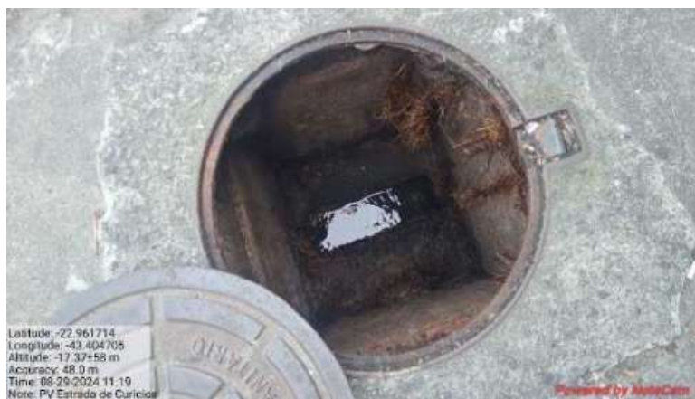
Fig. 12. - Poço de Visita no meio da Estrada de Curicica.
