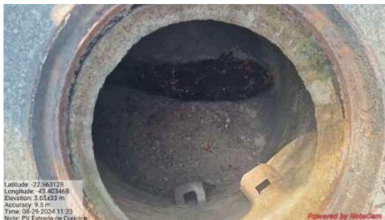
Fig. 13. - Poço de Visita no fim da Estrada de Curicica (próximo a Estrada dos Bandeirantes).
