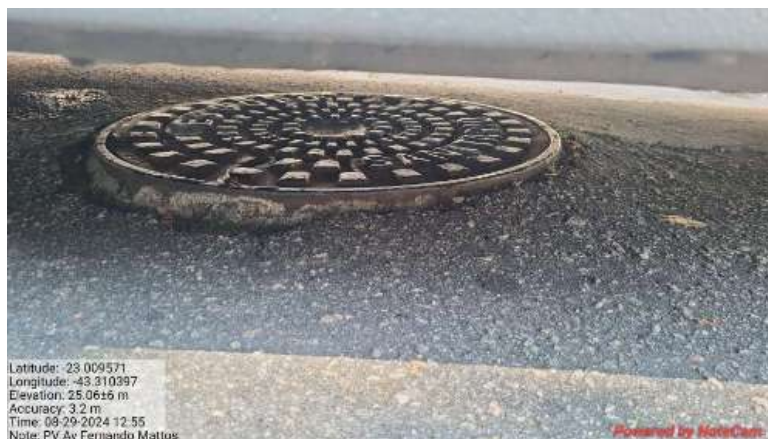
Fig. 22. - Poço de Visita na Av. Fernando Mattos
