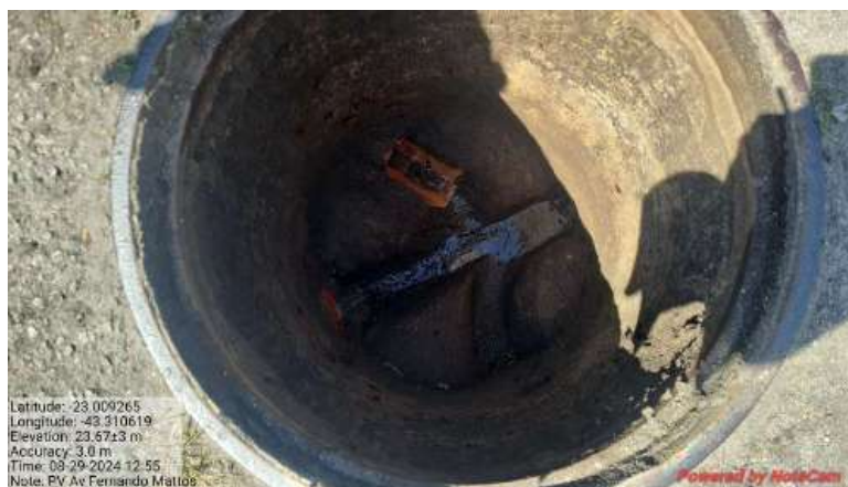
Fig. 21. - Poço de Visita na Av. Fernando Mattos
