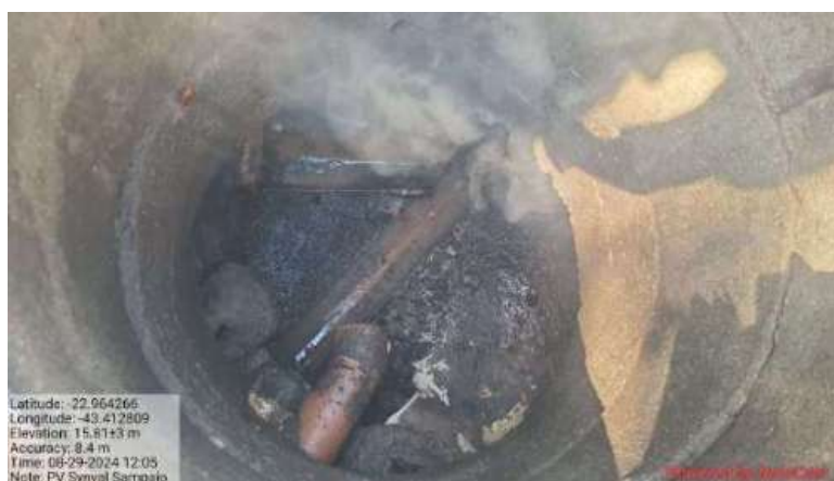
Fig. 17. - Poço de Visita na Rua Synval Sampaio
