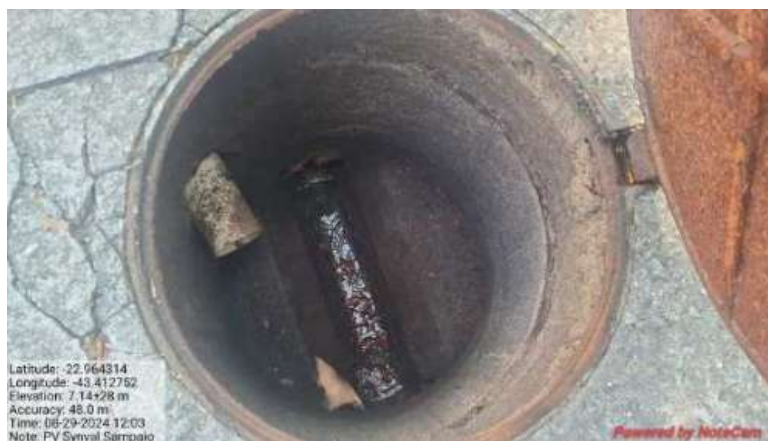
Fig. 16. - Poço de Visita na Rua Synval Sampaio
