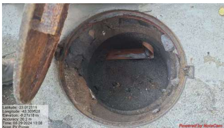
Fig. 23. - Poço de Visita na Av. Fernando Mattos
