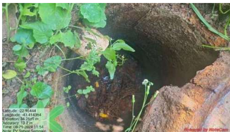
Fig. 15. - Poço de Visita na Rua Synval Sampaio
