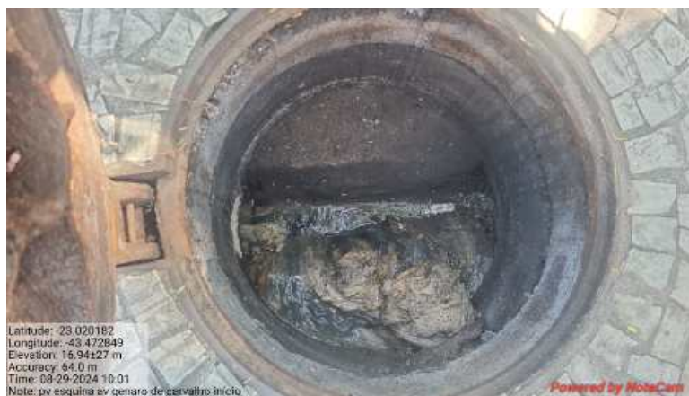
Fig. 6. - Poço de Visita de rede coletora DN150 da Av. Genaro de Carvalho
