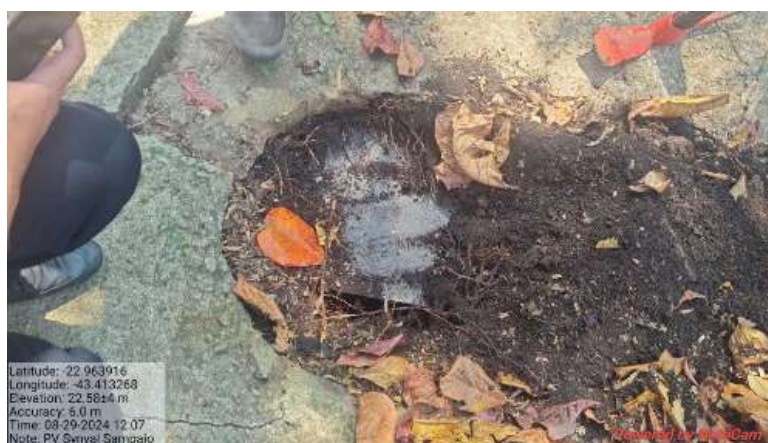
Fig. 18. - Poço de Visita na Rua Synval Sampaio
