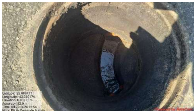
Fig. 23. - Poço de Visita na Av. Fernando Mattos
