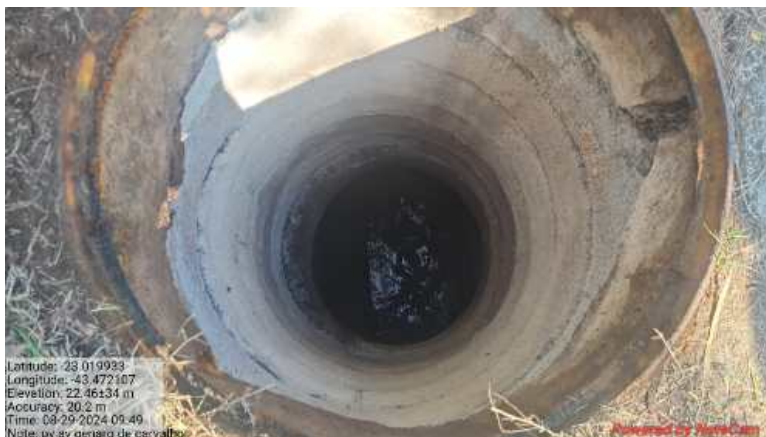
Fig. 3. - Poço de Visita de ligação entre linha de recalque DN630 e interceptor DN1000.
