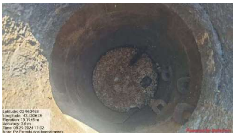
Fig. 14. - Poço de Visita na Estrada dos Bandeirantes 6669
