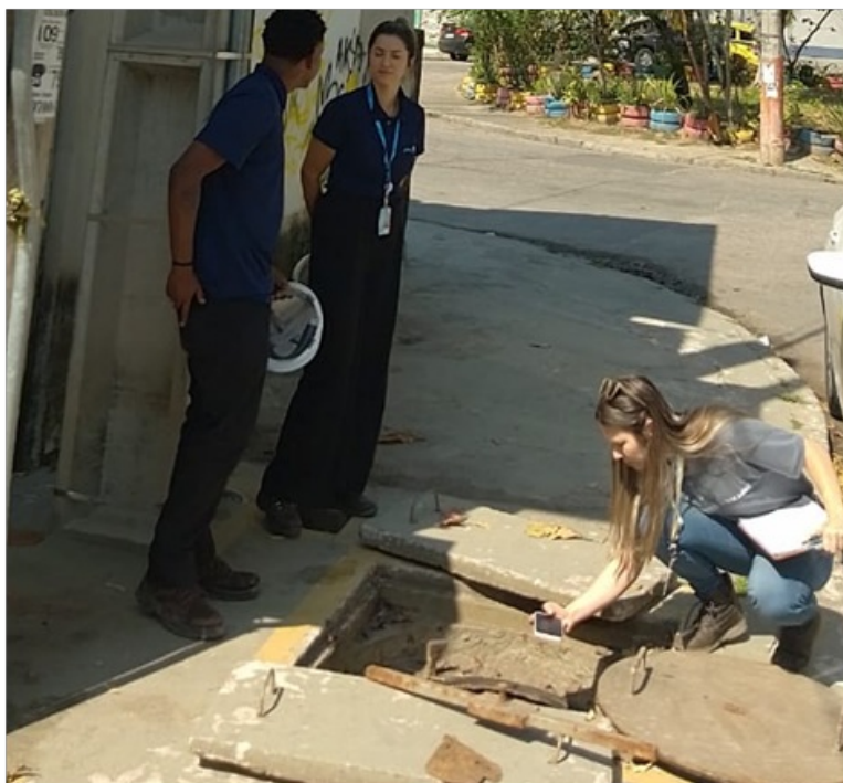
Foto 3 – Tampa de aço do panelão da motobomba
