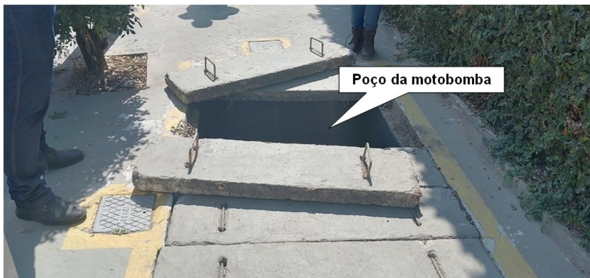
Foto 02 – Tapa de concreto do poço da motobomba.
