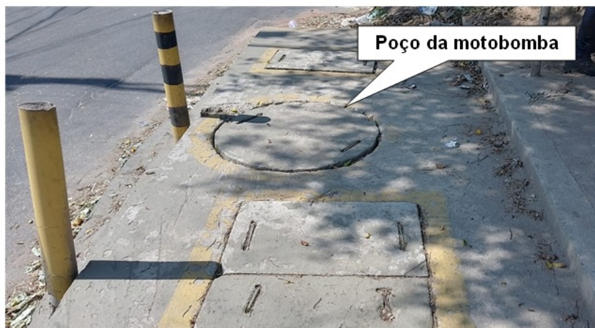
Foto 2 – Tapa de concreto do poço da motobomba
