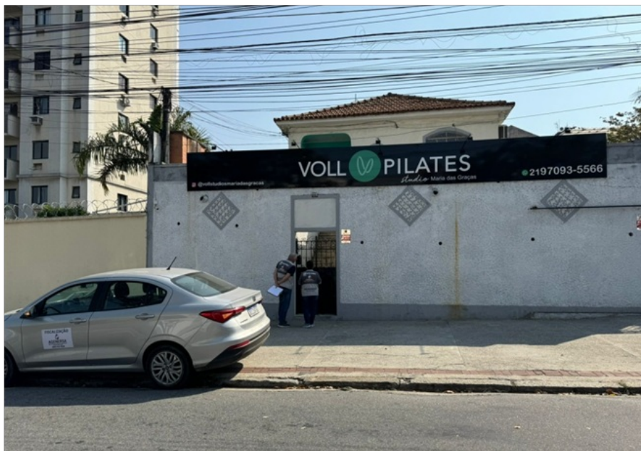
Foto 1 - Fachada principal do imóvel
