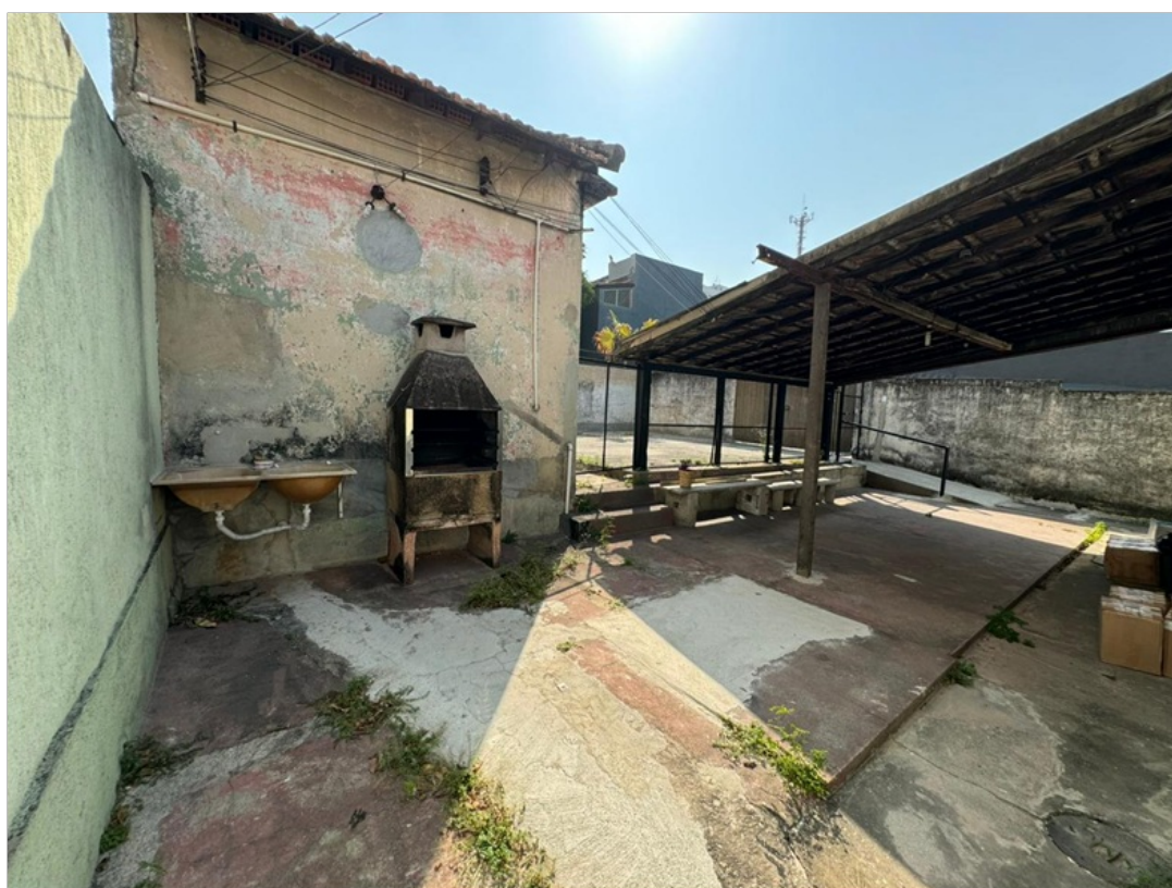
Foto 4 – Área de serviço
