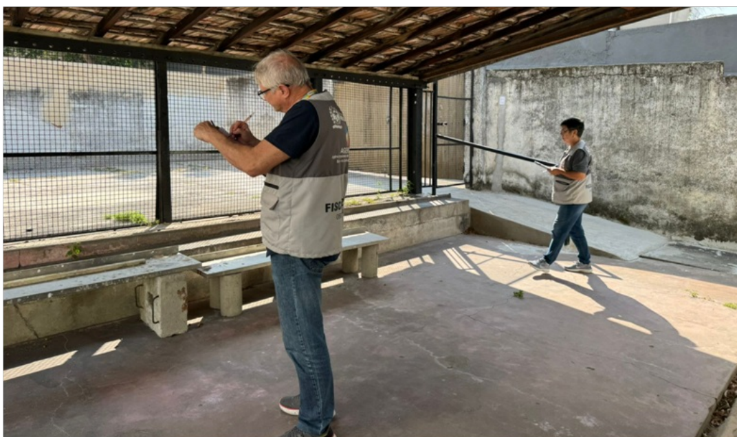
Foto 7 – Grade de ferro que separa as duas edificações
